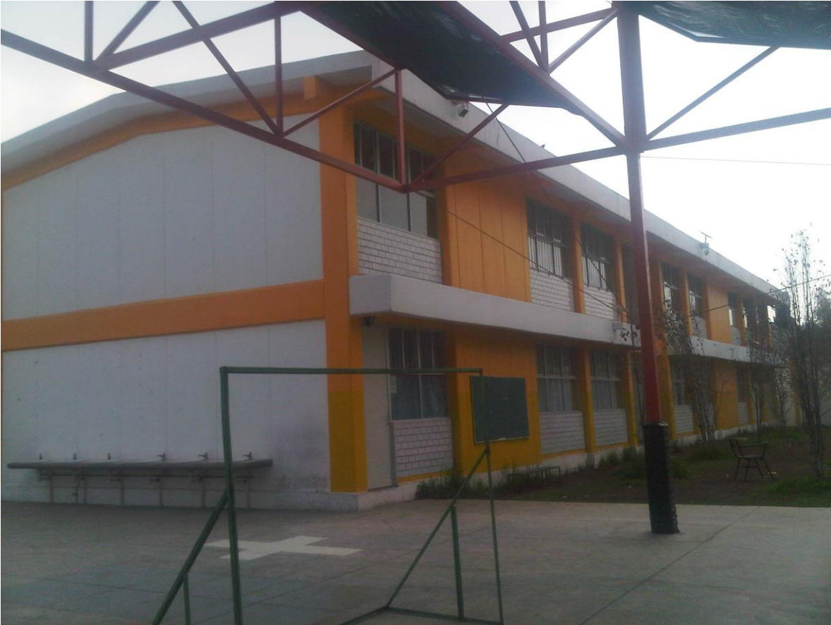
Figura 5.4: Fachada Sur del Edificio 2.
