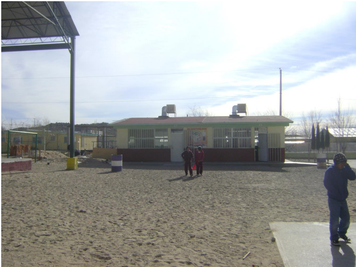
Figura 5.10: Edificio 1, vista de la fachada Norte.
