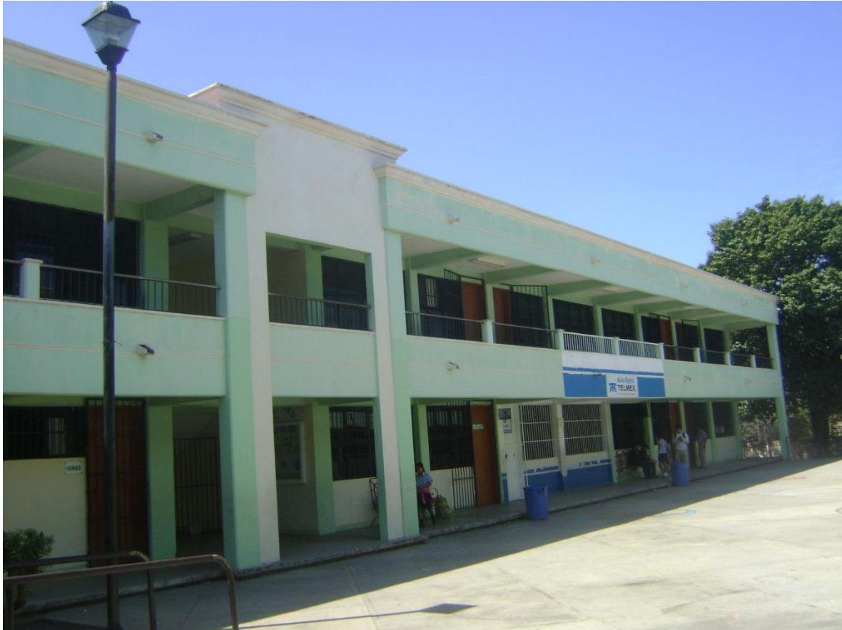
Figura 5.14: Fachada Norte edificio A.
