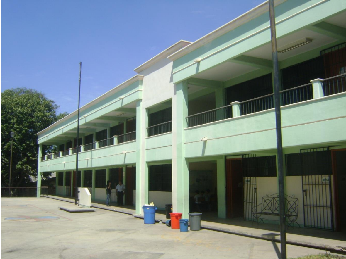
Figura 5.16: Fachada Sur del Edificio B.
