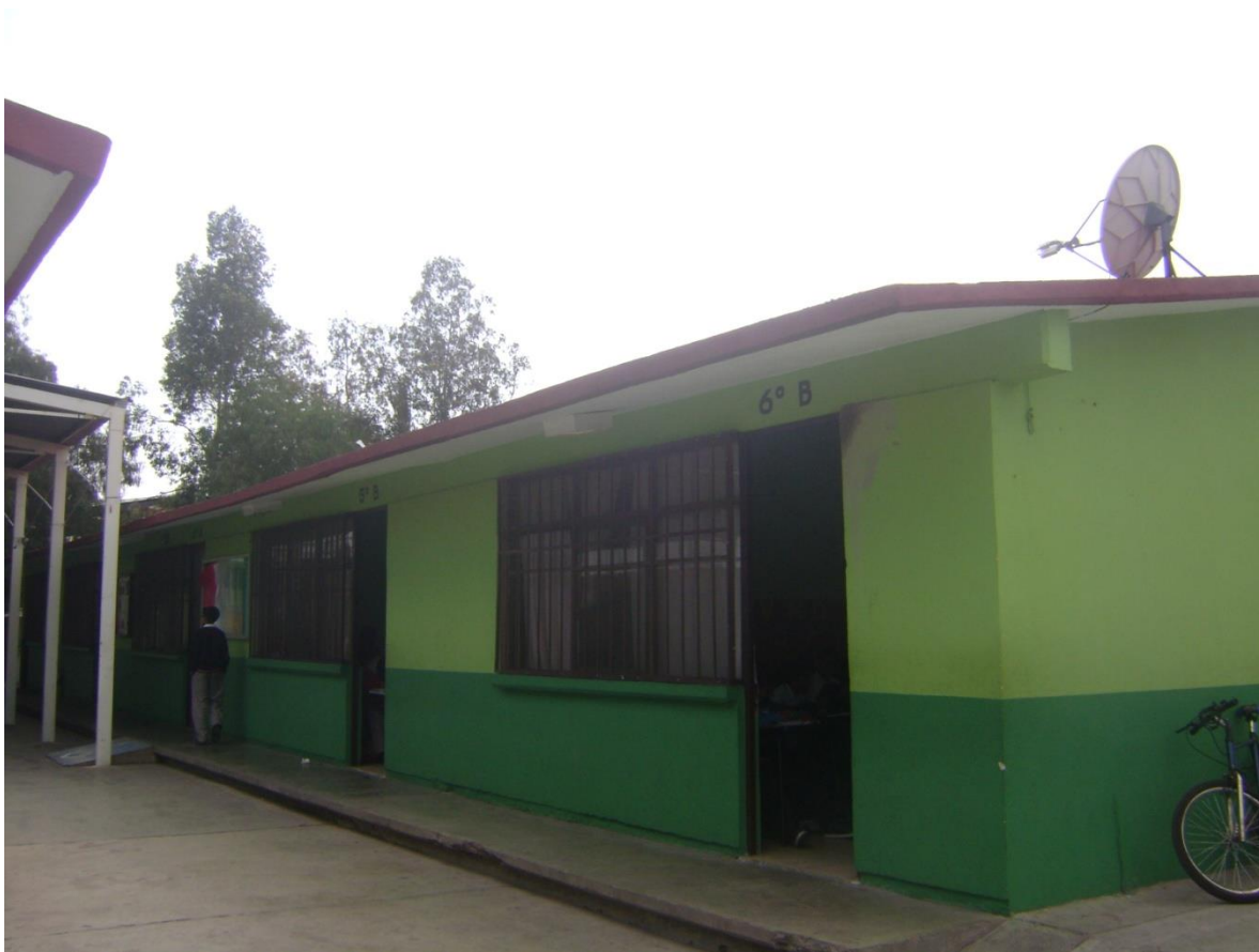
Figura 5.5: Fachada Norte del edificio.
