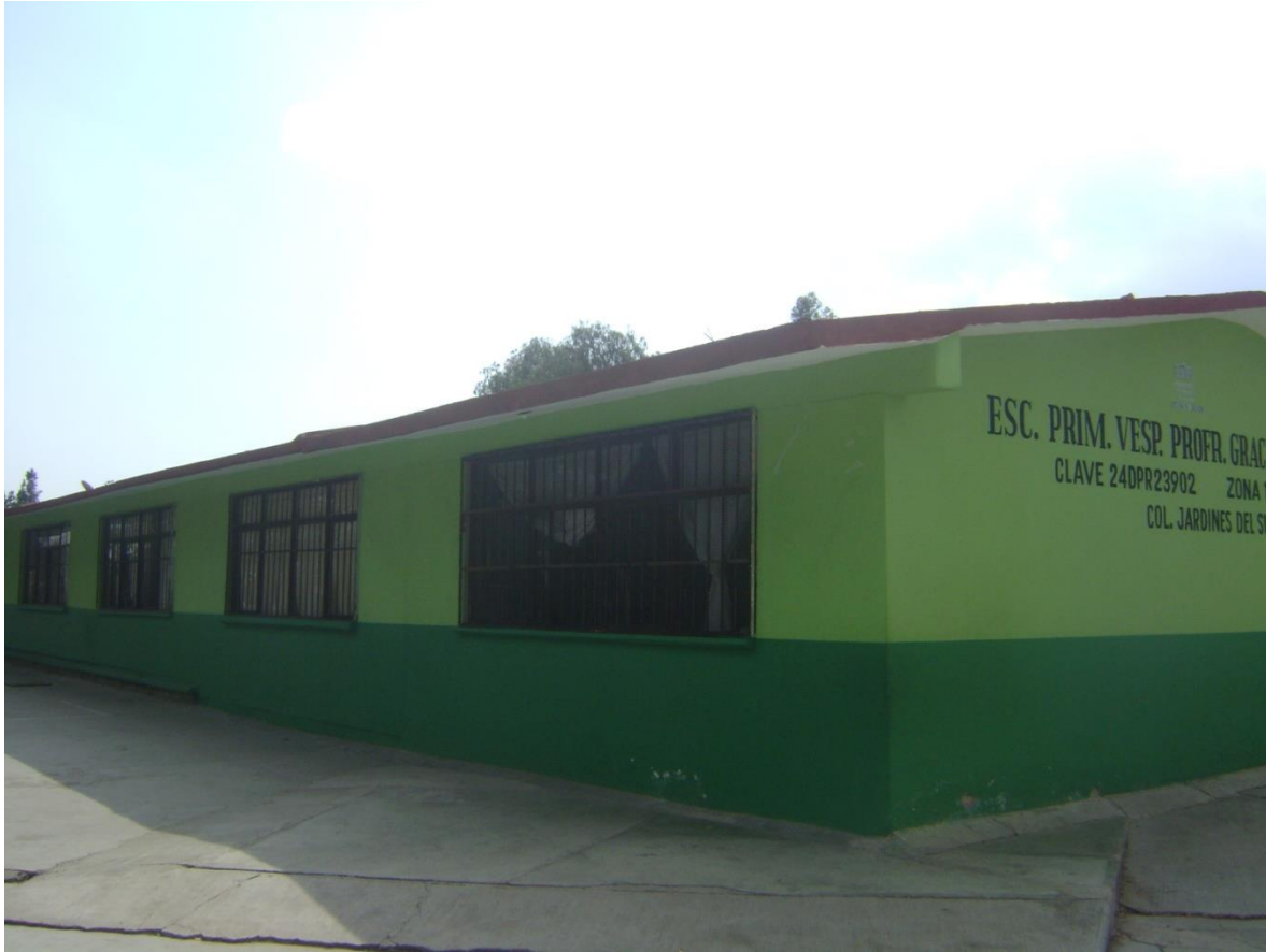
Figura 5.6: Fachada Sur del edificio.
