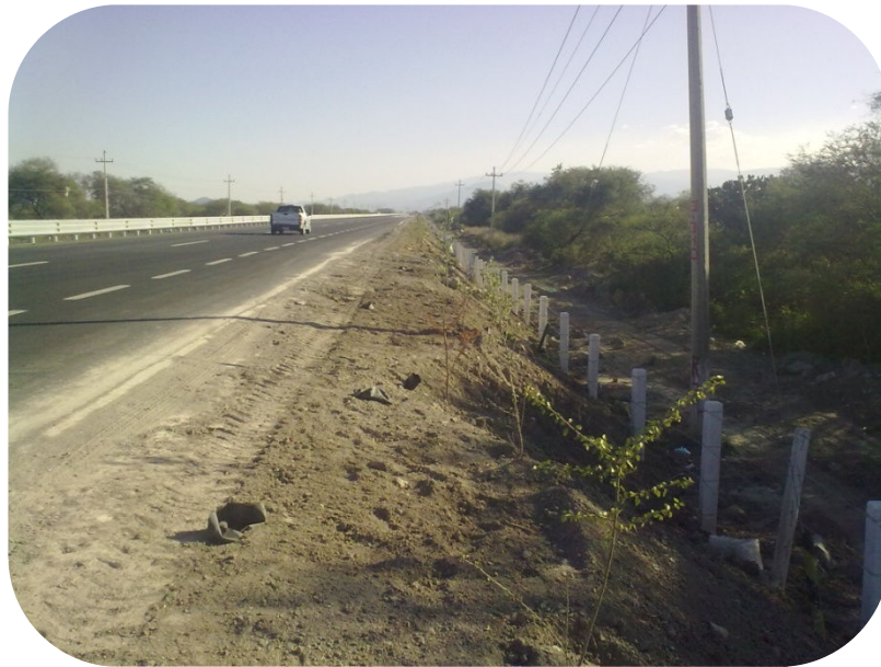
Imagen 3.3 Tramo de Carretera Terminado.
