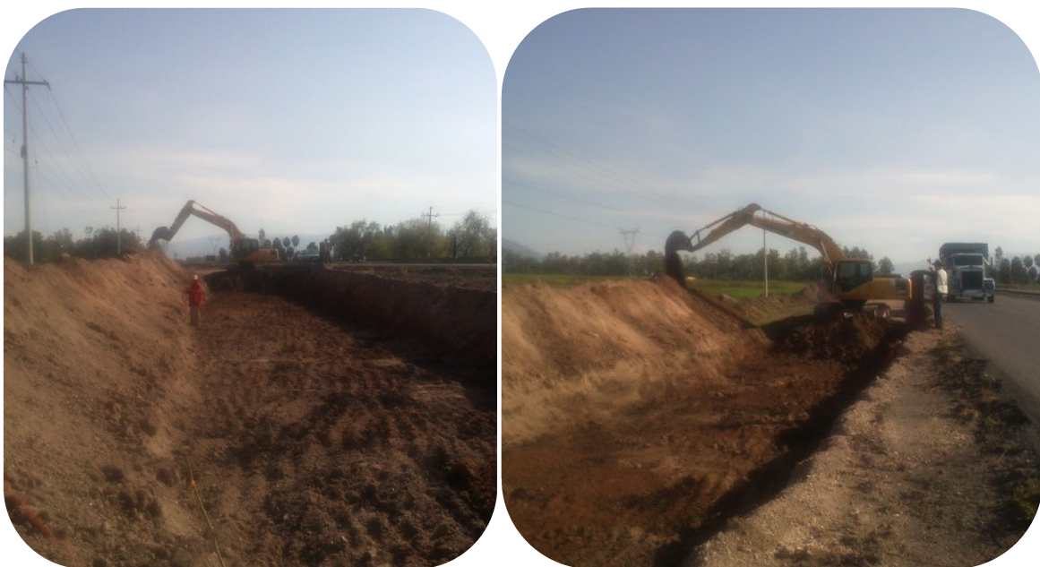
Imagen 4.19 .Levantamiento de secciones en excavación en caja
