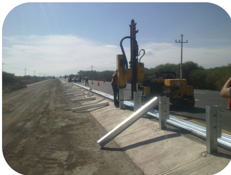
Imagen 4.27 Verificación alineamiento, ubicación y nivelación de las barreras centrales
