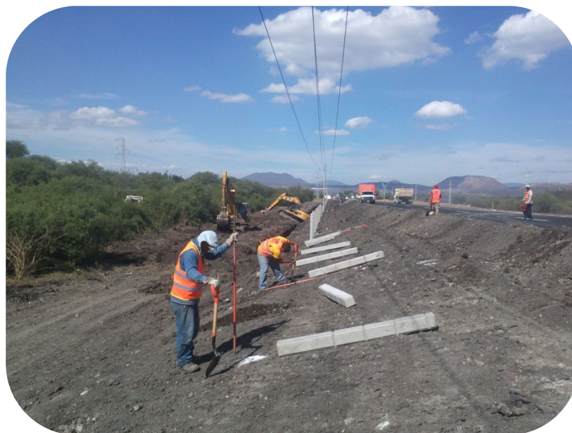
Imagen 4.28 Verificación alineamiento, ubicación y nivelación de alambre de púas.
