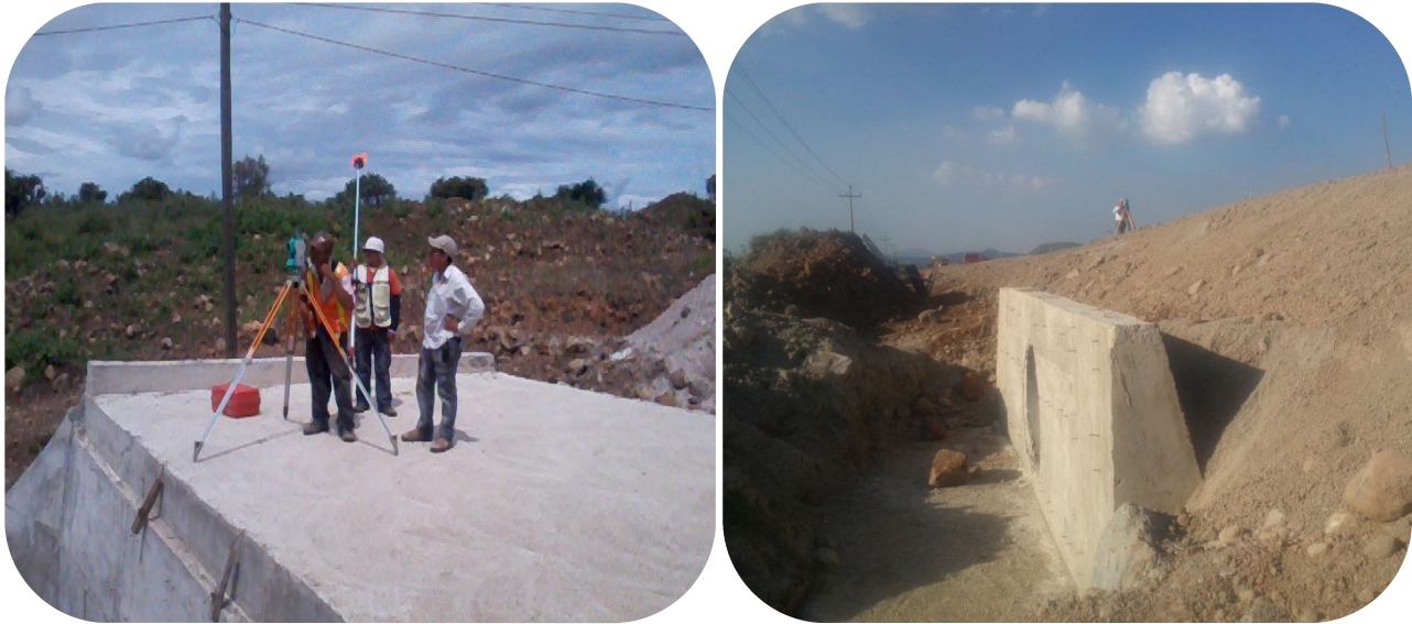
Imagen 4.37 Levantando niveles finales y la geometría de obras de drenaje para verificar con el proyecto.
