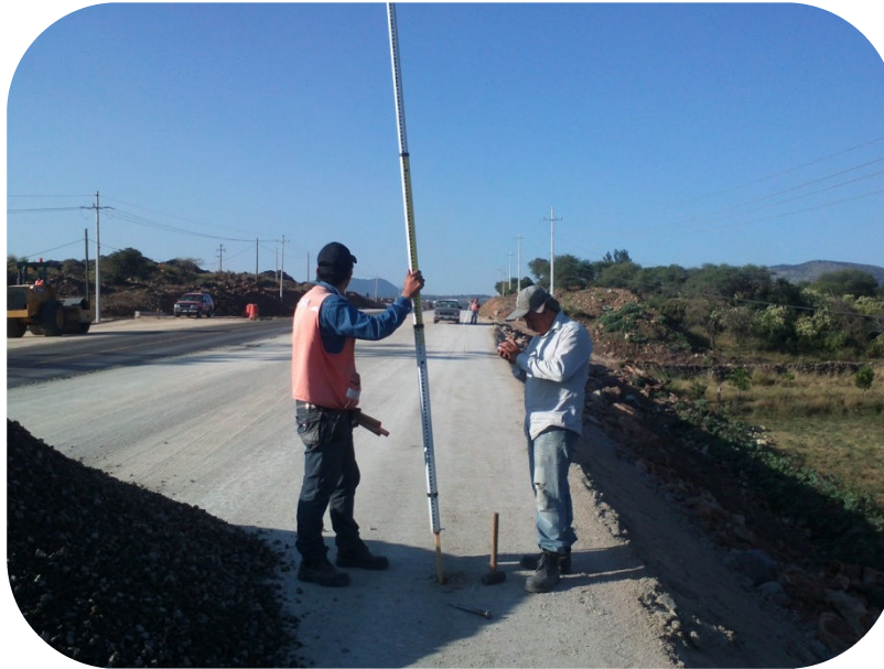
Imagen4.5. Control y alineamiento vertical para capa de base hidráulica.
