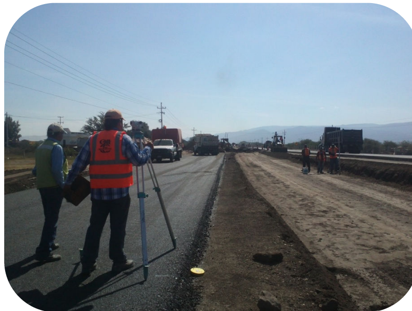
Imagen4.3. Métodos topográficos y de estacado.
