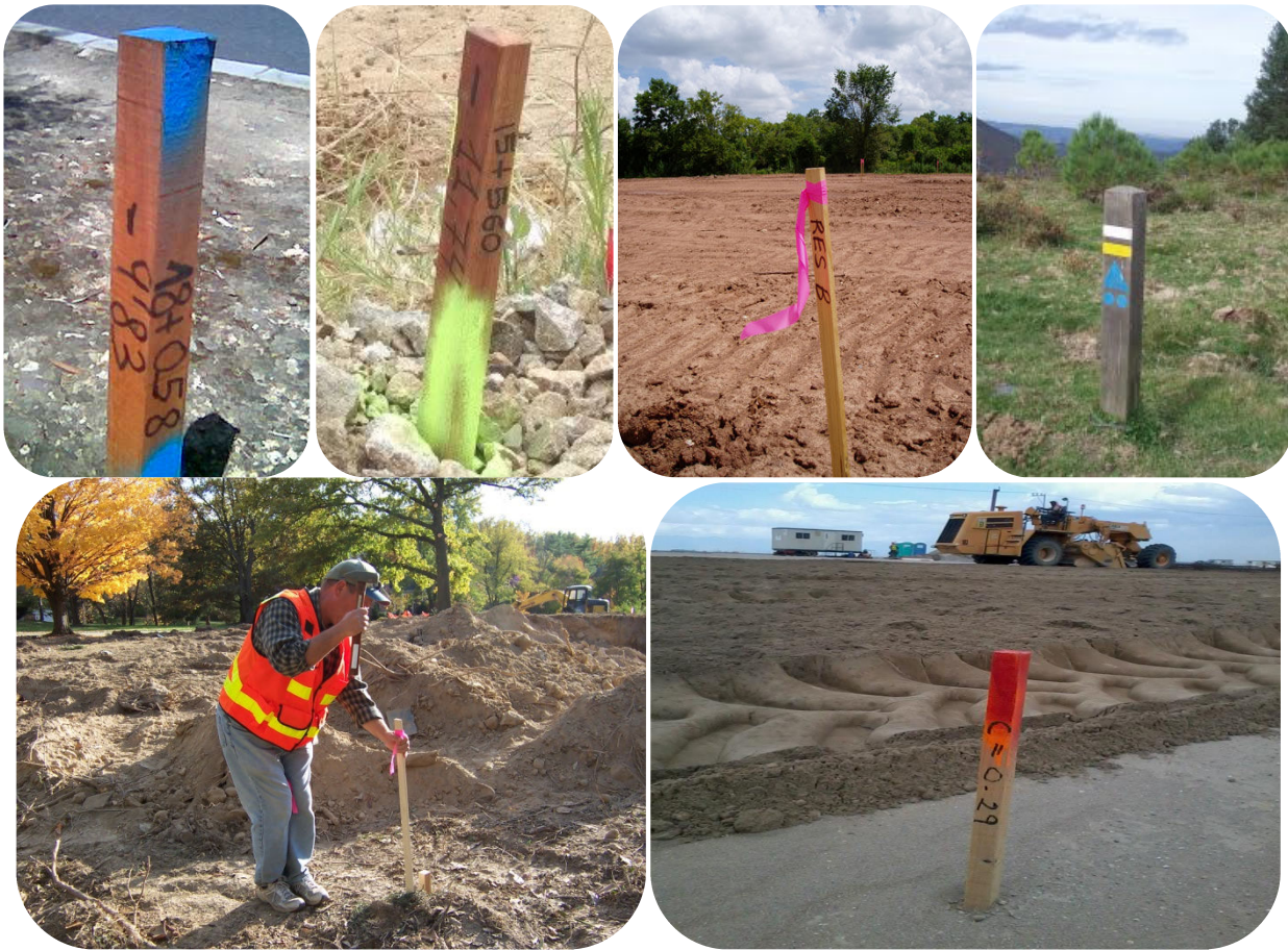
Imagen4.4. Anotaciones y marcas en estacas.
