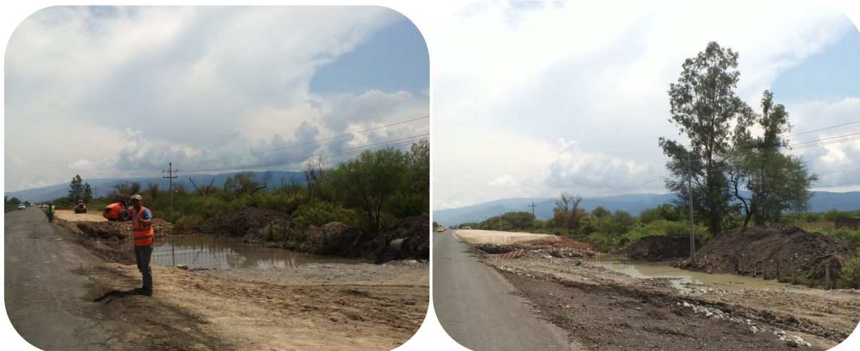
Imagen 4.33 Obra de drenaje en proceso de construcción.
