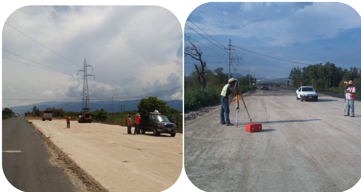
Imagen 4.23 .Levantamiento de secciones en capa final de subyacente.
