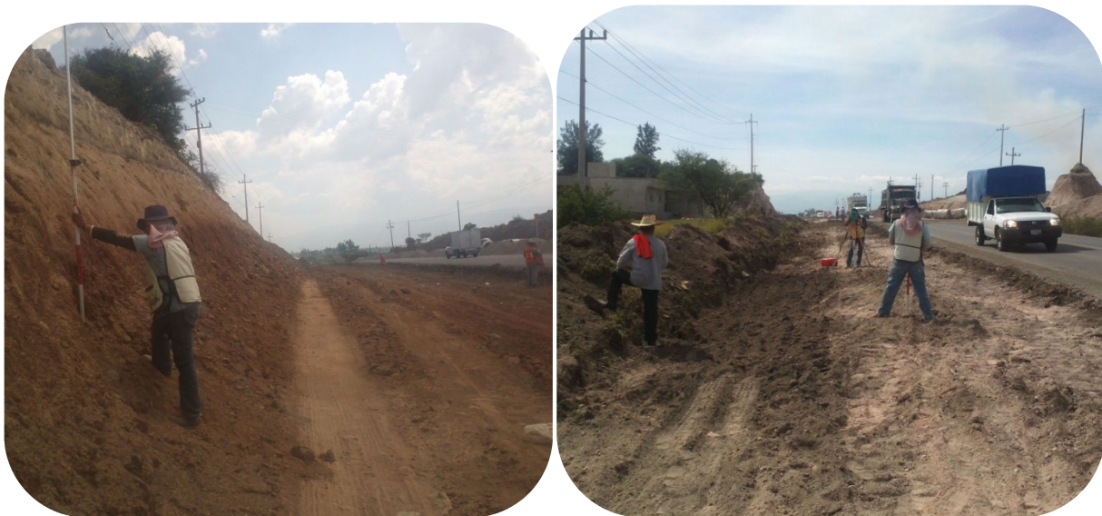
Imagen 4.14.- Levantamiento de secciones transversales de cortes.
