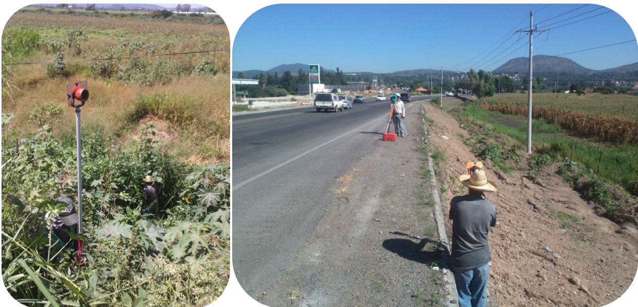
Imagen 4.12 Brigada de topografía levantando secciones de terreno natural.
