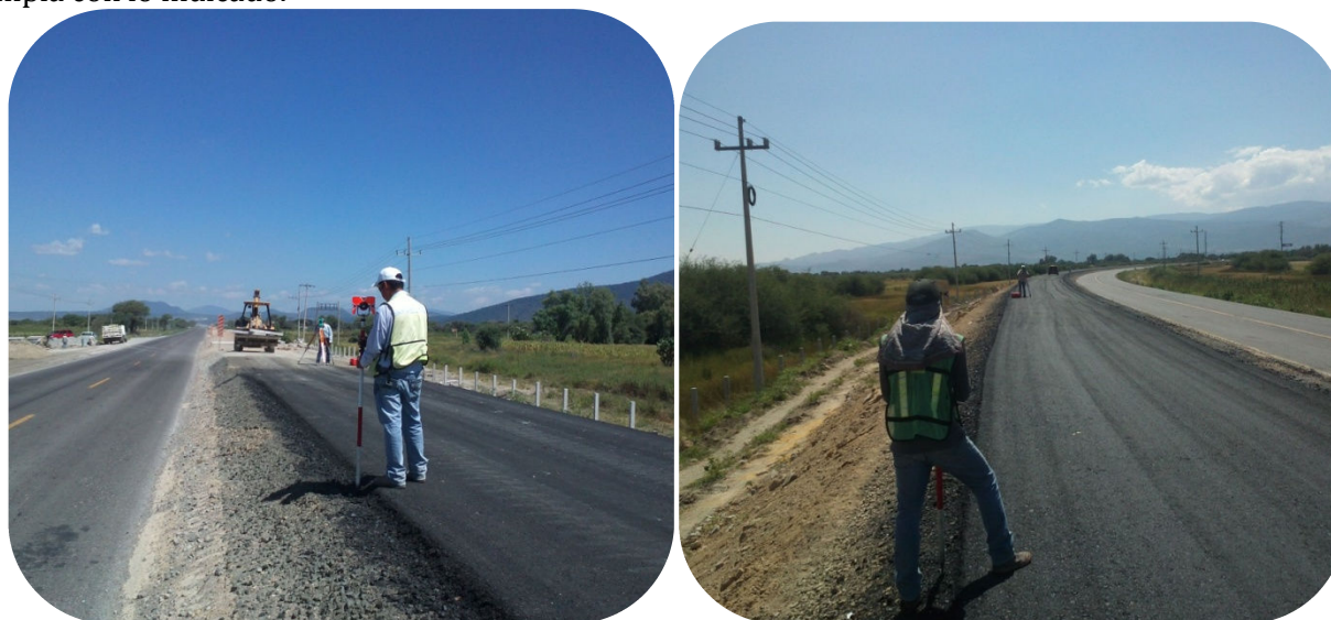
Imagen 4.28. Levantamiento de secciones transversales para tramo terminado de base asfáltica.
