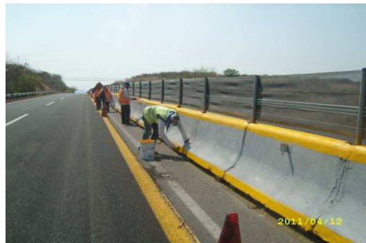
Fotografía No.96. Vista durante la aplicación de pintura en franjas de barrera central.
