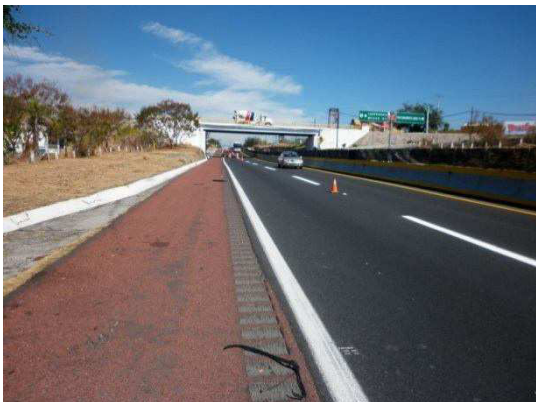
Fotografía No. 101 Vista de tramo antes de iniciar los trabajos de suministro y aplicación de pintura blanca en rayas continuas.
