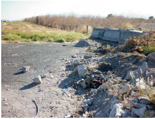
Fotografía No.12 Vista del Subtramo una vez retirada la basura.
