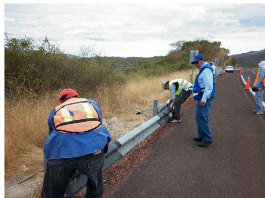
Fotografía No. 110. Vista durante el desmantelamiento de la defensa metálica de dos crestas.
