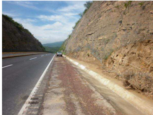
Fotografía No. 82 Vista después de realizados los trabajos de retiro de material acumulado en malla triple torsión en el talud del corte
