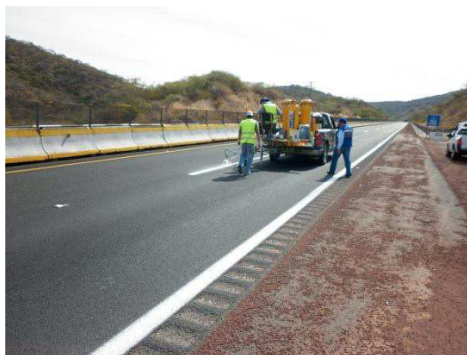
Fotografía No. 99. Se observa a la pintarías realizando el suministro y aplicación de pintura blanca en rayas discontinuas
