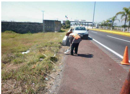
Fotografía No. 40 Se observa el acotamiento sin guarnición.
