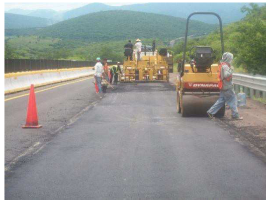
Fotografía No.5. Se observa a personal de la contratista realizando el tendido de material asfáltico.
