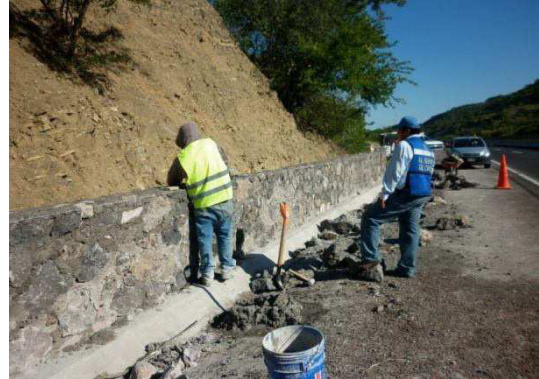
Fotografía No.64. Vista durante la reparación de los muros de mampostería.
