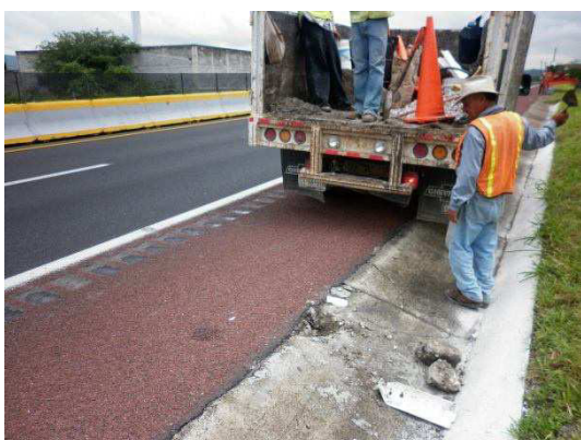
Fotografía No. 86 Se observa que no existe indicador de alineamiento.
