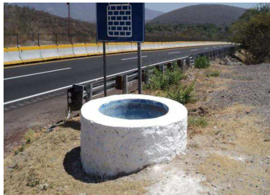
Fotografía No.18. Vista después de pintar el depósito de agua.
