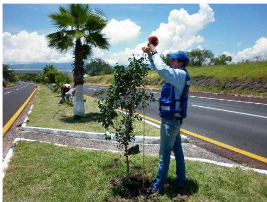
Fotografía No. 33 Vista después de terminados los trabajos de Siembra de árboles en zonas jardinadas y derecho de vía.
