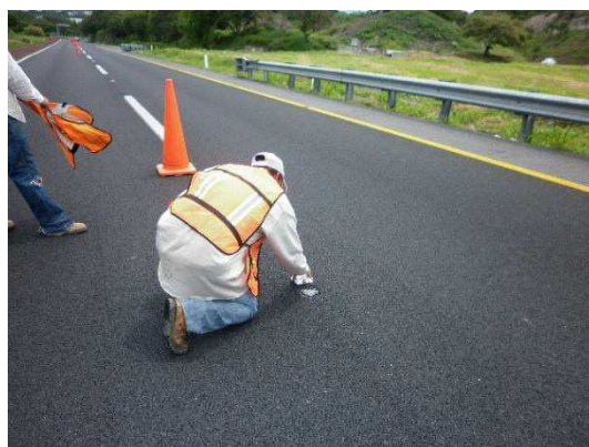
Fotografía No.84. Se observa a personal de la empresa contratista realizando la colocación de vialeta blanca.
