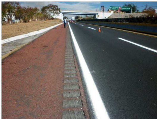
Fotografía No. 103. Vista después de realizados los trabajos de suministro y aplicación de pintura blanca en rayas continuas.
