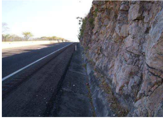
Fotografía No.3 Vista después del barrido del acotamiento.
