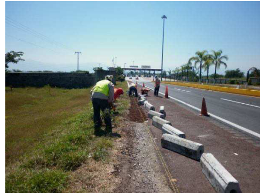
Fotografía No.44. Una vez nivelado y alineado el personal de la contratista procede a la rehabilitación de dichos elementos..
