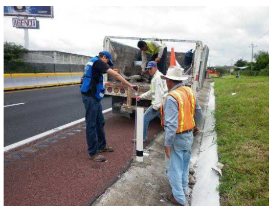
Fotografía No. 87. Vista durante el suministro de indicador de alineamiento.
