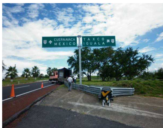
Fotografía No. 116 Vista después del suministro e instalación de 2 señales bandera doble SID-14.
