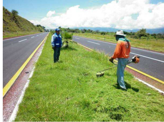
Fotografía No.47. Se observa a personal de la contratista realizando la poda del camellón central.
