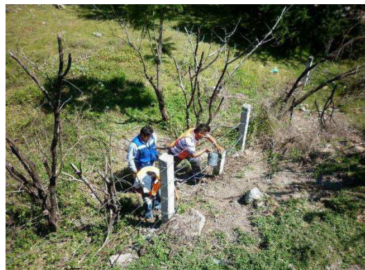
Fotografía No.20. Se observa a personal de la empresa contratista realizando el tensado de alambre de púas en el cercado del derecho de vía
