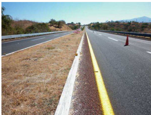
Fotografía No. 106. Vista después de realizados los trabajos de suministro y aplicación de pintura amarilla en rayas continuas.
