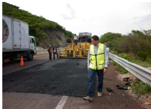
Fotografía No. 112. Vista durante los trabajos de tendido de mezcla asfáltica en caliente.
