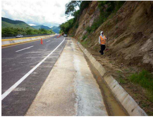
Fotografía No. 73 Vista una vez terminados los trabajos de extracción de caídos.
