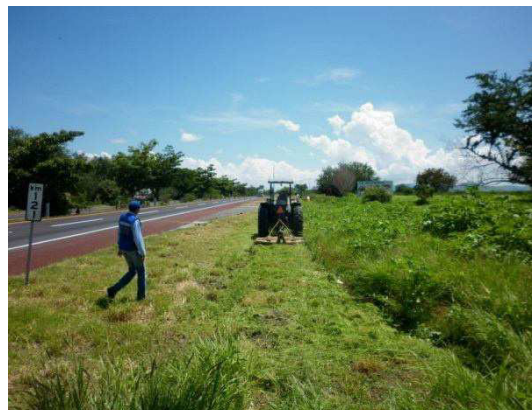
Fotografía No.8. Se observa el tractor con el que se llevan a cabo los trabajos de deshierbe de derecho de vía.
