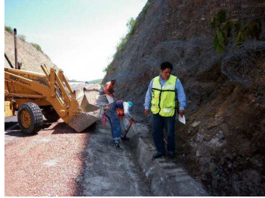
Fotografía No.81. Se observa a personal de la empresa contratista realizando la remoción de material acumulado.
