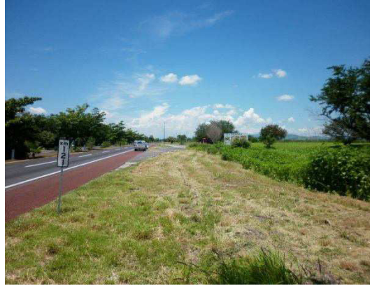
Fotografía No.9 Vista una vez realizado el deshierbe del derecho de vía.
