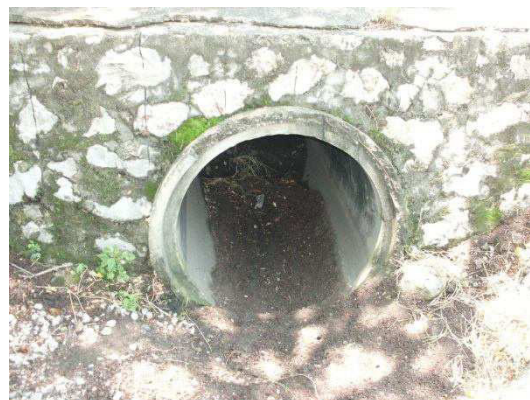
Fotografía No.56. Vista después de realizar el desazolve de la alcantarilla.
