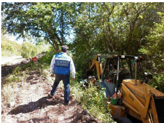
Fotografía No. 66 Se observa retroexcavadora realizando la limpieza del canal de salida de una obra de drenaje.
