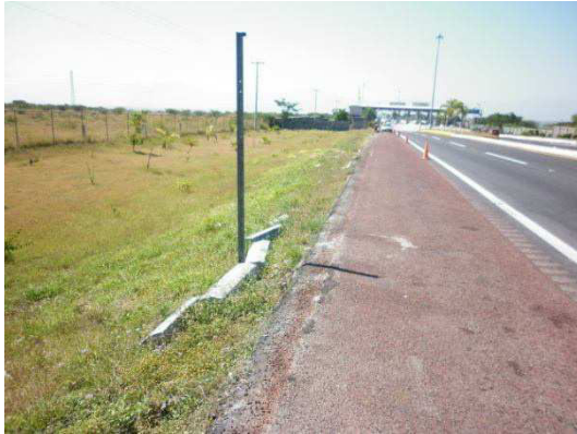
Fotografía No. 43 Se observan algunas secciones de guarnición prefabricada al lado del camino.
