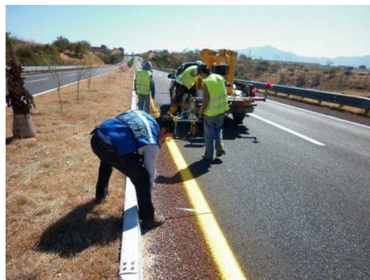
Fotografía No. 105. Se observa a la pintorías realizando el suministro y aplicación de pintura amarilla en rayas continuas.
