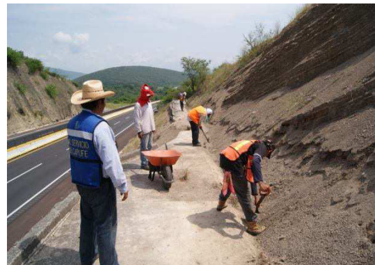
Fotografía No.78. Se observa a personal de la empresa contratista realizando la remoción de material acumulado.
