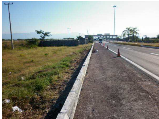
Fotografía No. 45 Vista después de terminados los trabajos de Alineación, renivelación y junteo de guarnición prefabricada de concreto hidráulico existente.
