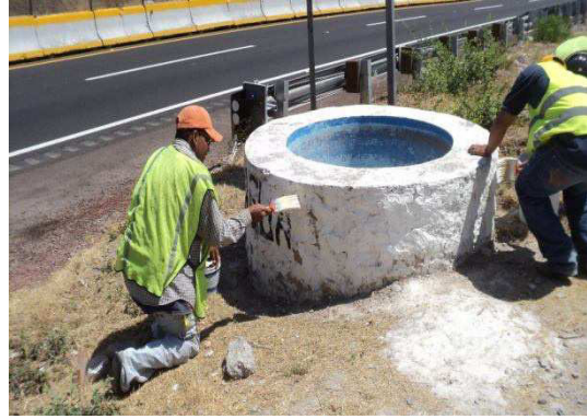
Fotografía No.17. Se observa a personal de la empresa contratista realizando el pintado de depósitos de agua.
