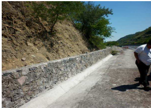
Fotografía No. 65. Vista después de realizados los trabajos de muro de mampostería.
