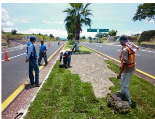
Fotografía No. 51 Vista durante el proceso de suministro y colocación de pasto.
