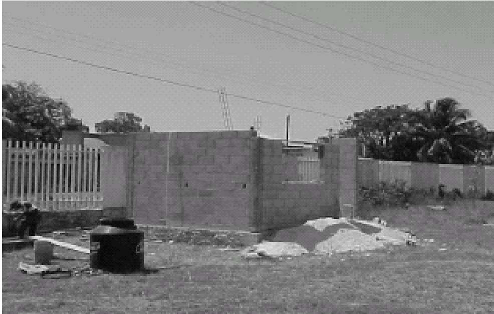
Fig. V.I.6.- Muros, dalas y castillos.
