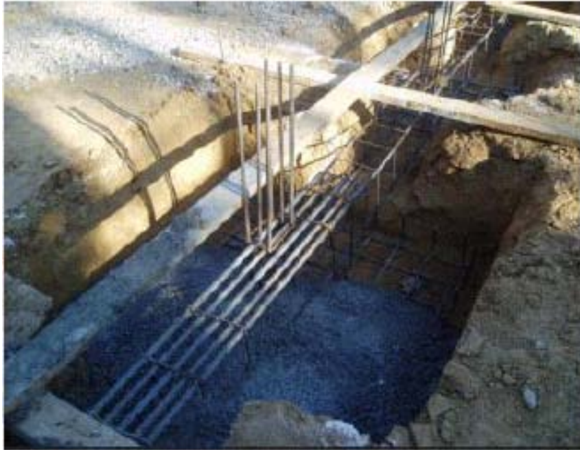
Fig. V.2.3.1.- Cimentación: zanja y zapatas.
