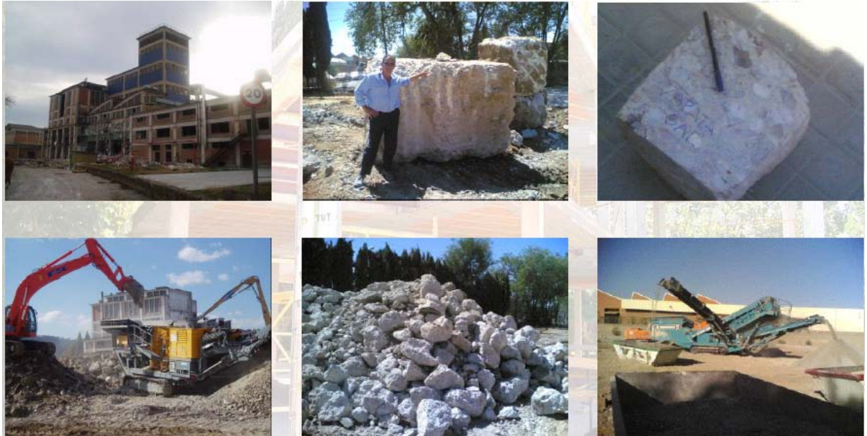
Fig. V.2.1.- Demolición de la fábrica de perfumes GAL.
