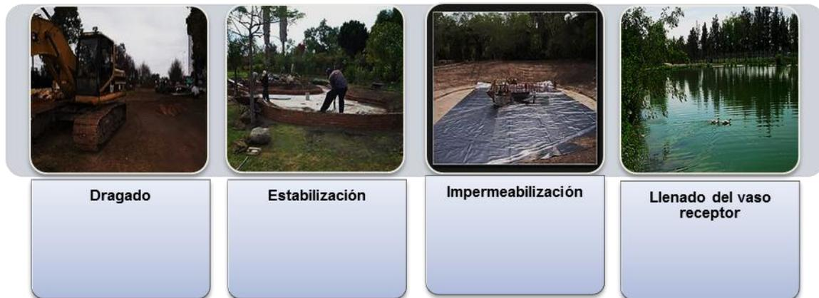
**Figura 2.3 Etapas para la construcción del Lago Alameda Oriente**
