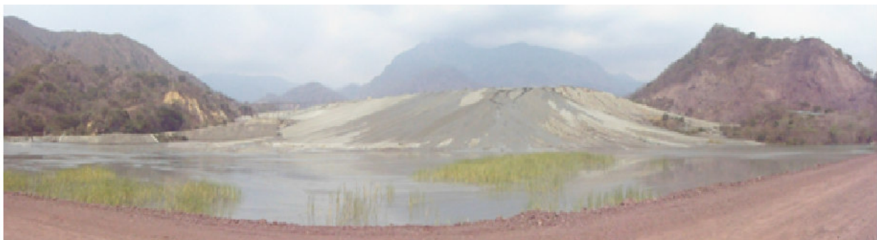
Figura 3. 6 Ubicación de la presa de Jales Fuente: Peña Colorada
