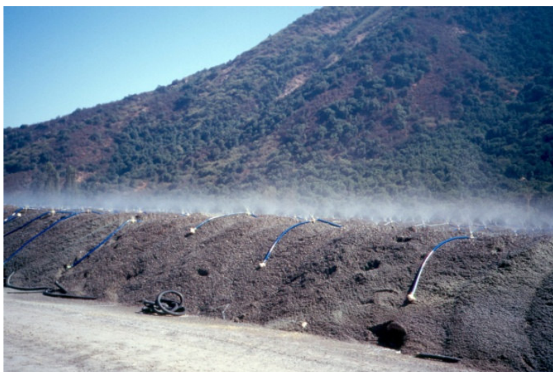
Figura 4. 13 Ejemplo de una pila de cianuración en las instalaciones de la mina El Soldado (Chile)
