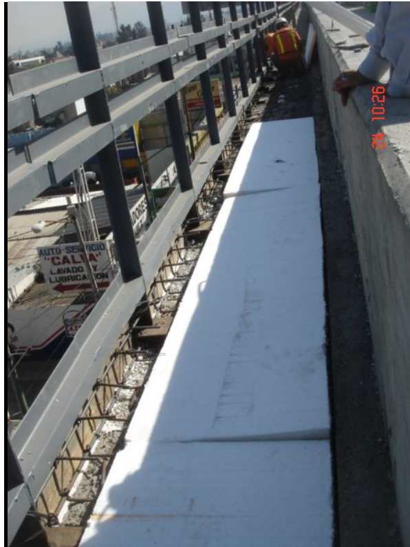
Imagen 58. Relleno de poliestireno en trinchera
