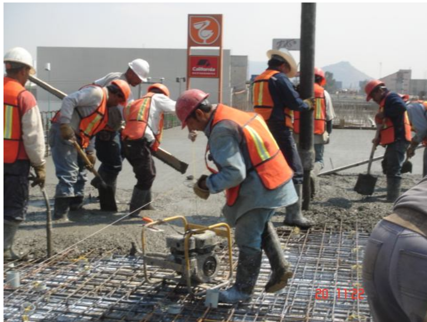
Imagen 43. Colado de losa de compresión
