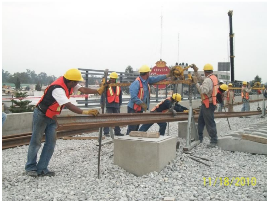
Imagen 53. Colocación de rieles
