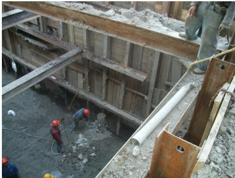
Imagen 9. Descabece de pilotes
