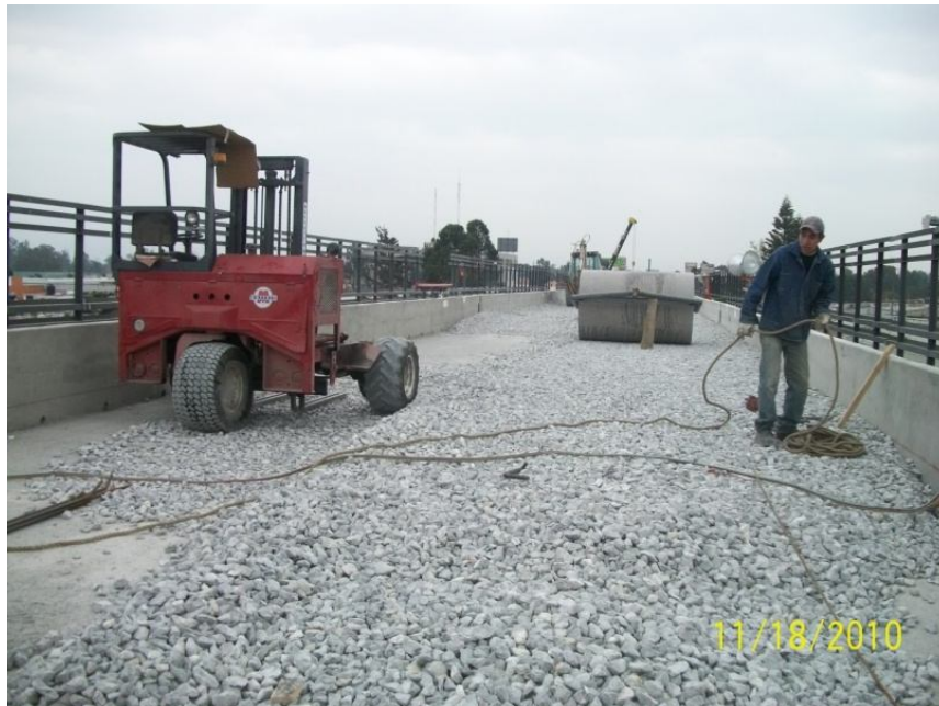
Imagen 50. Tendido de balasto
