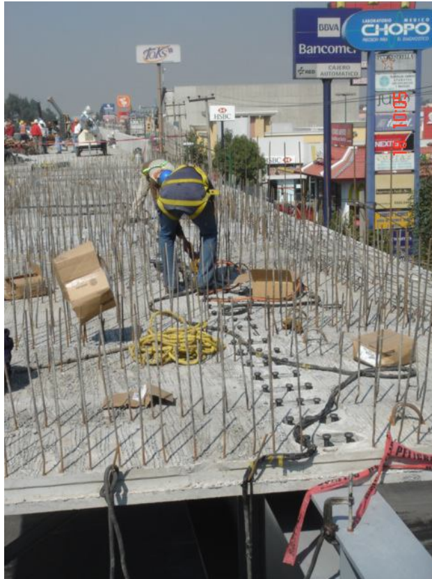
Imagen 41. Levantamiento de punta de varillas y colocación de conectores Nelson
