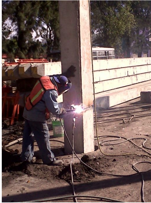
Imagen 7. Unión de tramos de pilote de fricción con soldadura a tope
