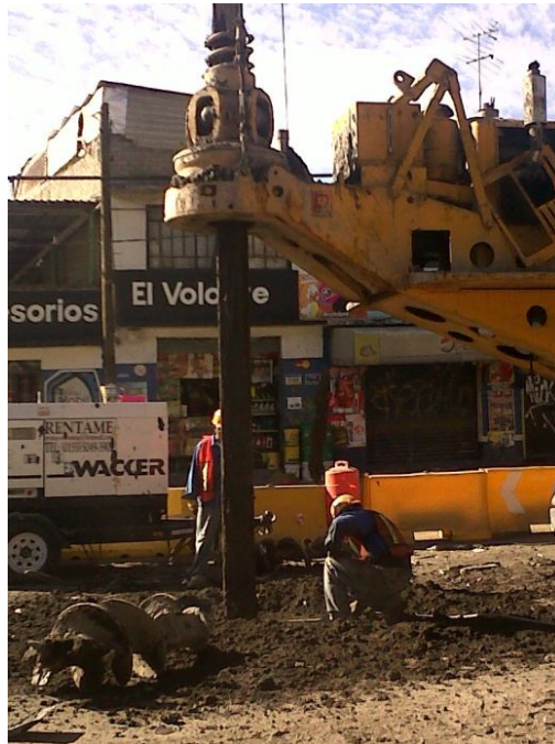
Imagen 5. Perforación previa con broca helicoidal
