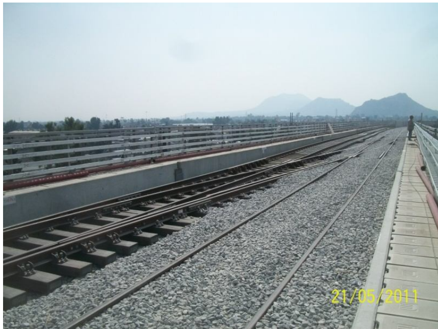
Imagen 55. Balasto a nivel de durmientes
