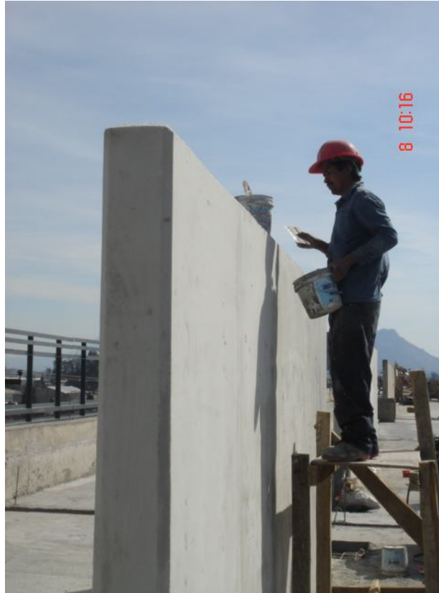
Imagen 48. Aparentado de muros
