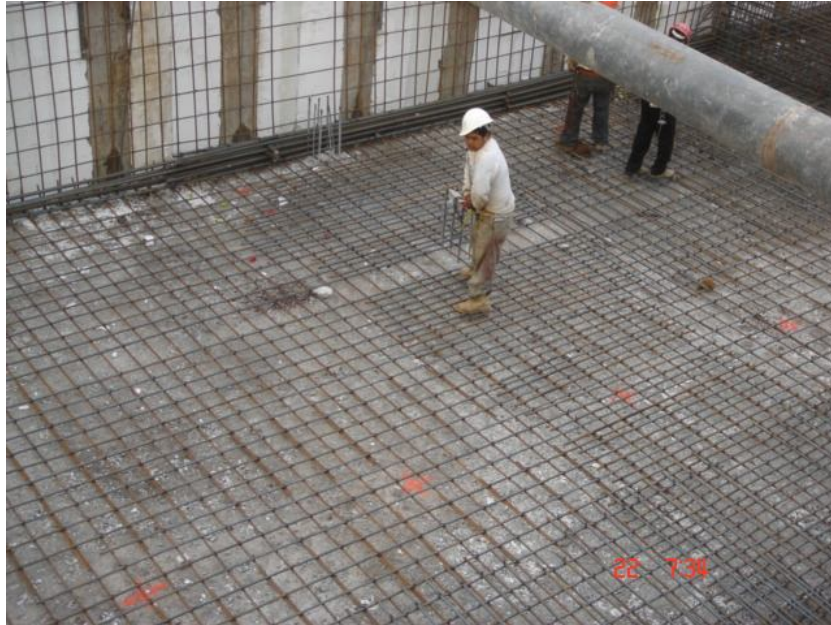
Imagen 10. Armado de losa de fondo y preparaciones para muros perimetrales
