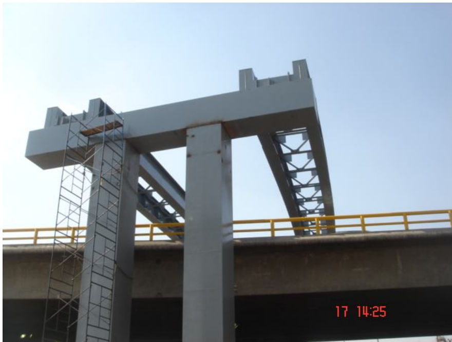
Imagen 3. Tramo en bocina
