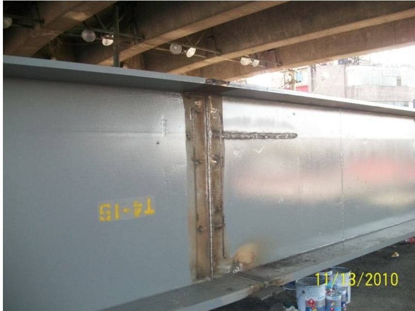
Imagen 34. Junta de penetración completa en el centro del claro
