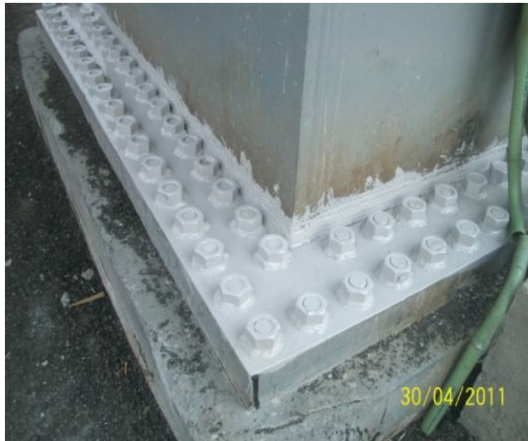
Imagen 26. Aplicación de pintura en base de columna
