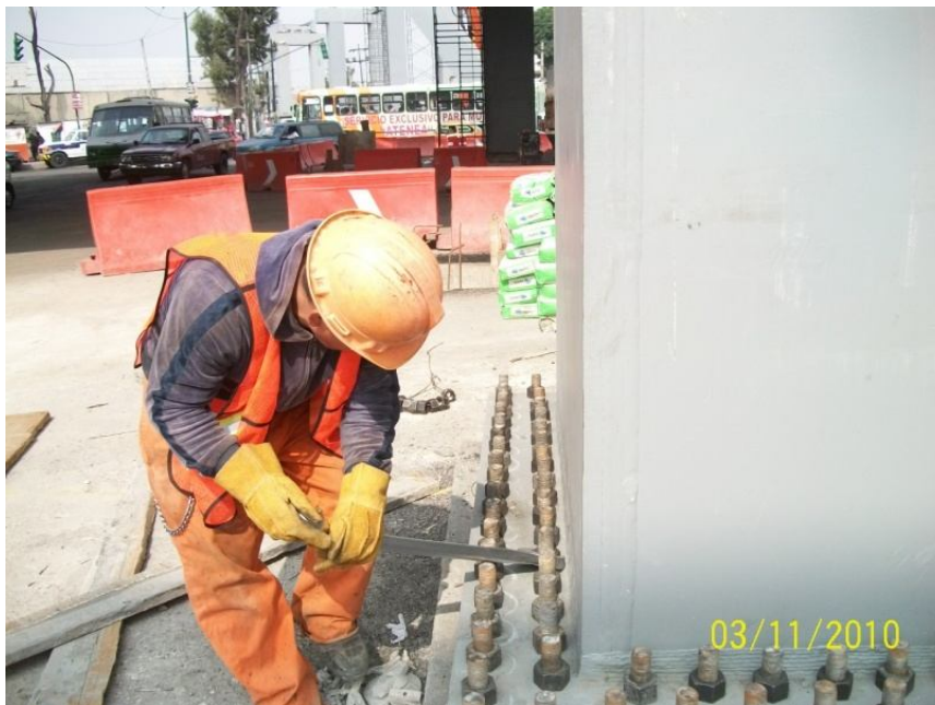
Imagen 24. Colocación de tuercas hexagonales tipo pesado
