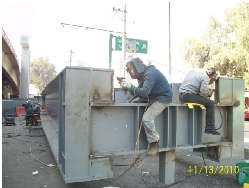
Imagen 37. Tope sísmico móvil
