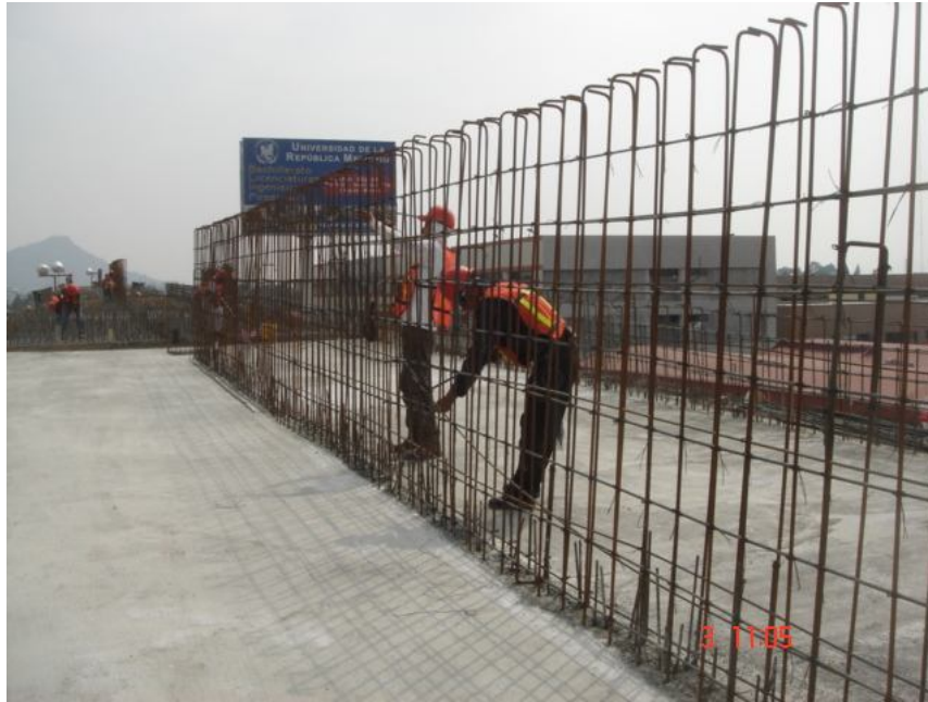
Imagen 46. Armado de muro central
