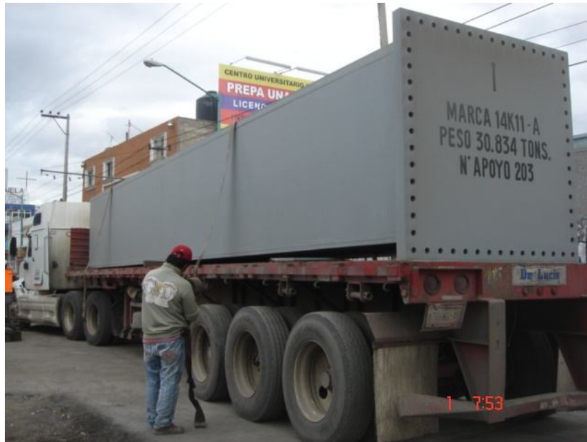
Imagen 20. Traslado de columnas metálicas
