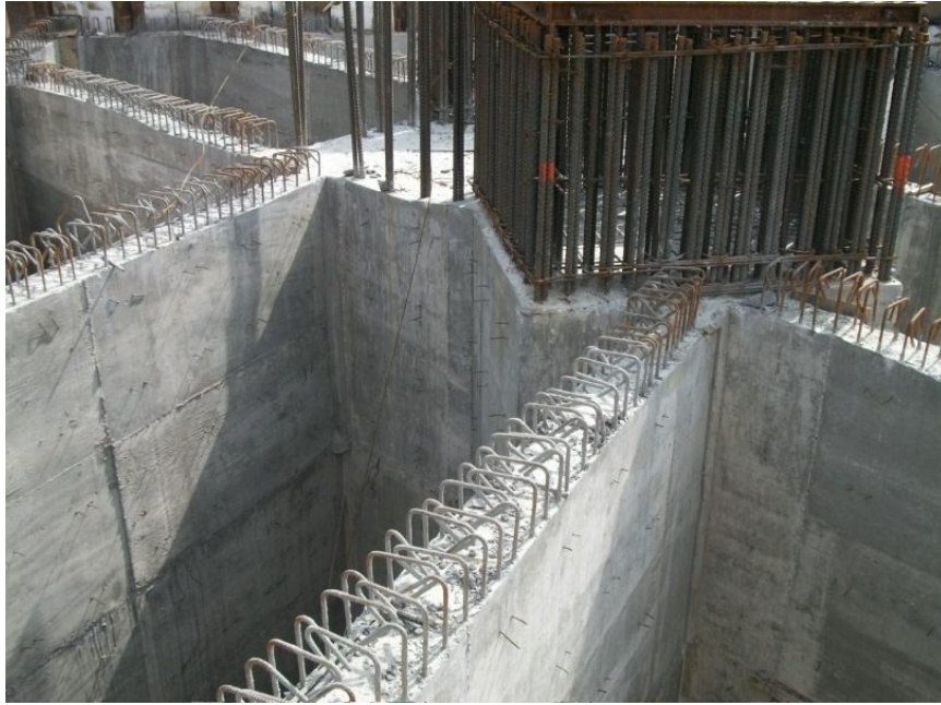
Imagen 14. Primer colado hasta altura de 3.50 m
