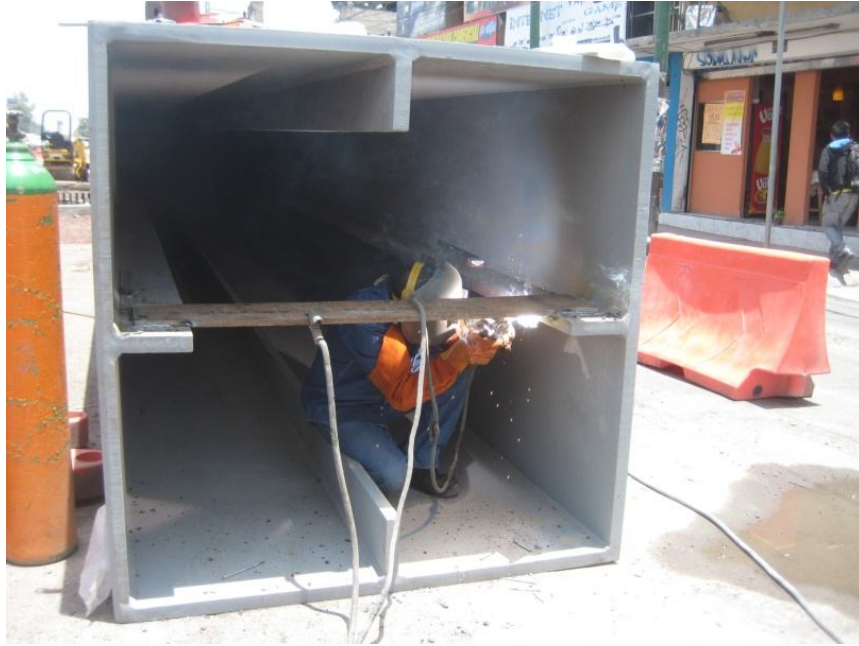
Imagen 21. Placas metálicas soldadas para sujeción de columna metálica
