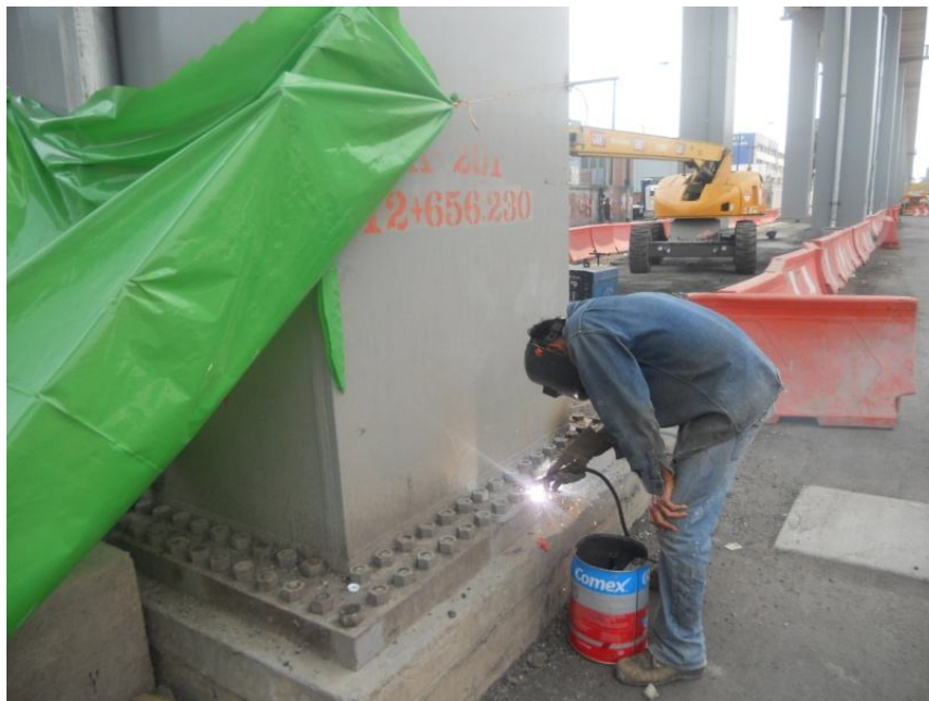
Imagen 25. Aplicación de cordón de soldadura alrededor de tuercas tipo pesado
