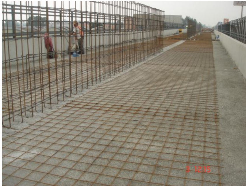
Imagen 44. Tendido de malla equipotencial
