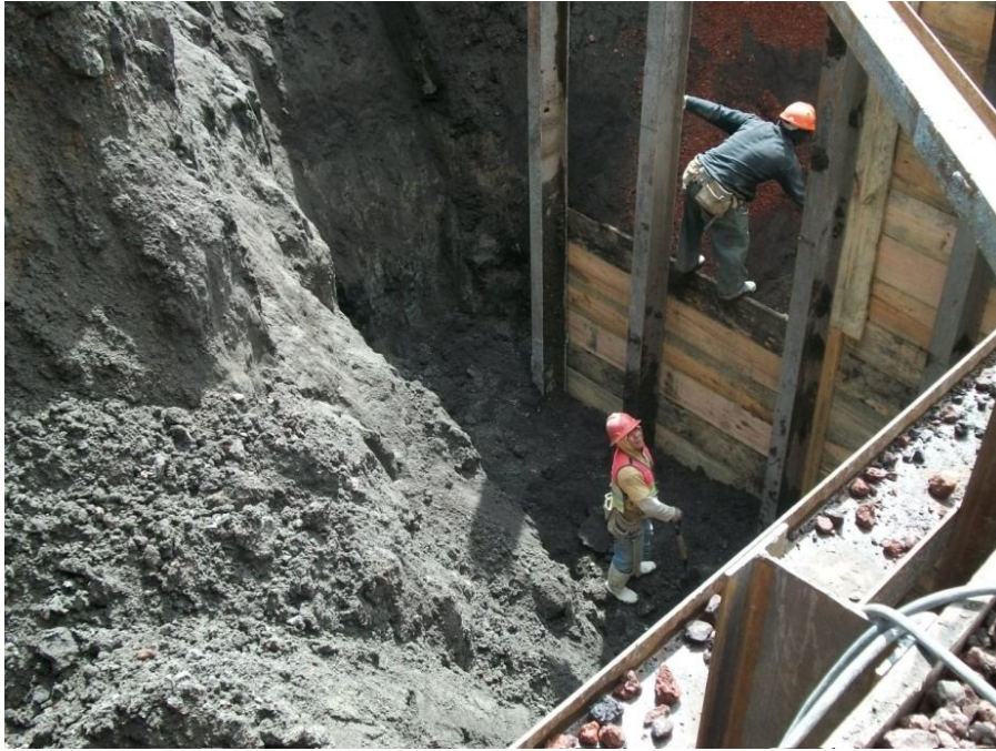
Colocación de tablonés de madera para sistema de retención
