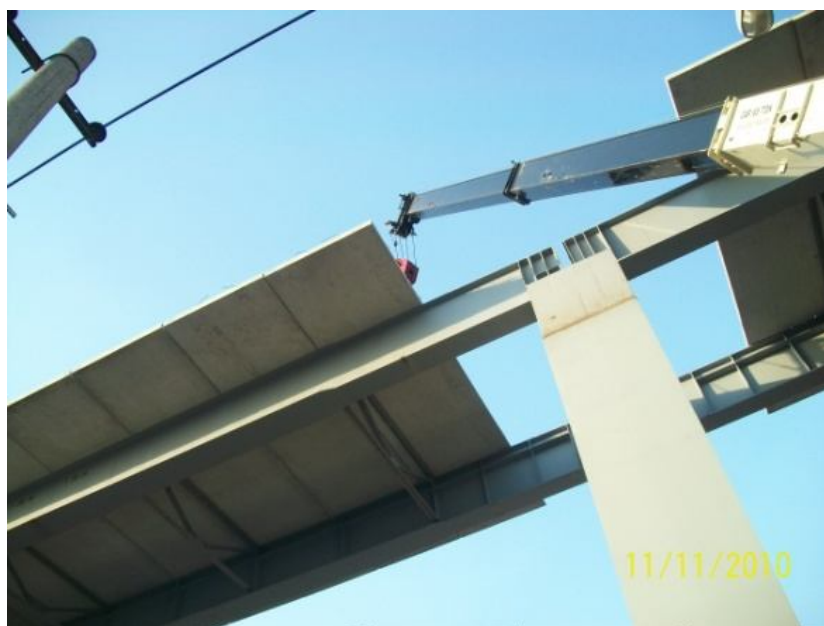
Imagen 40. Montaje de tabletillas precoladas
