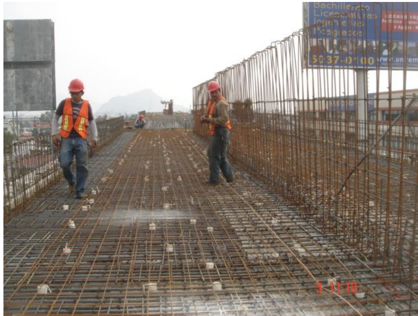
Imagen 42. Armado de losa de compresión
