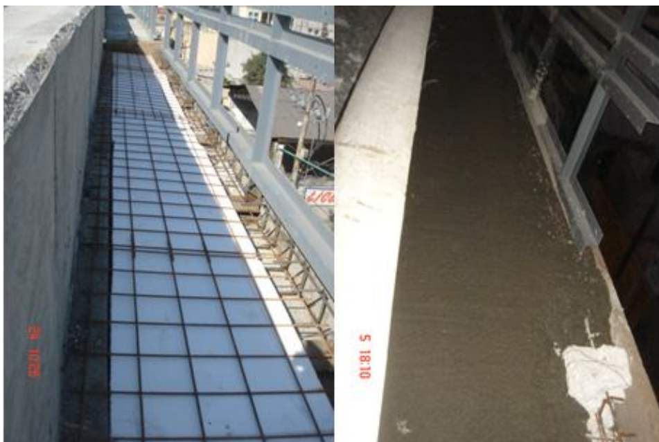
Imagen 59. Refuerzo de malla electrosoldada y colado de firme de concreto
