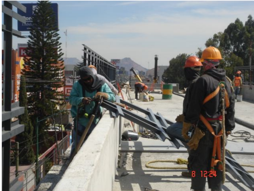
Imagen 56. Colocación de bastidores metálicos
