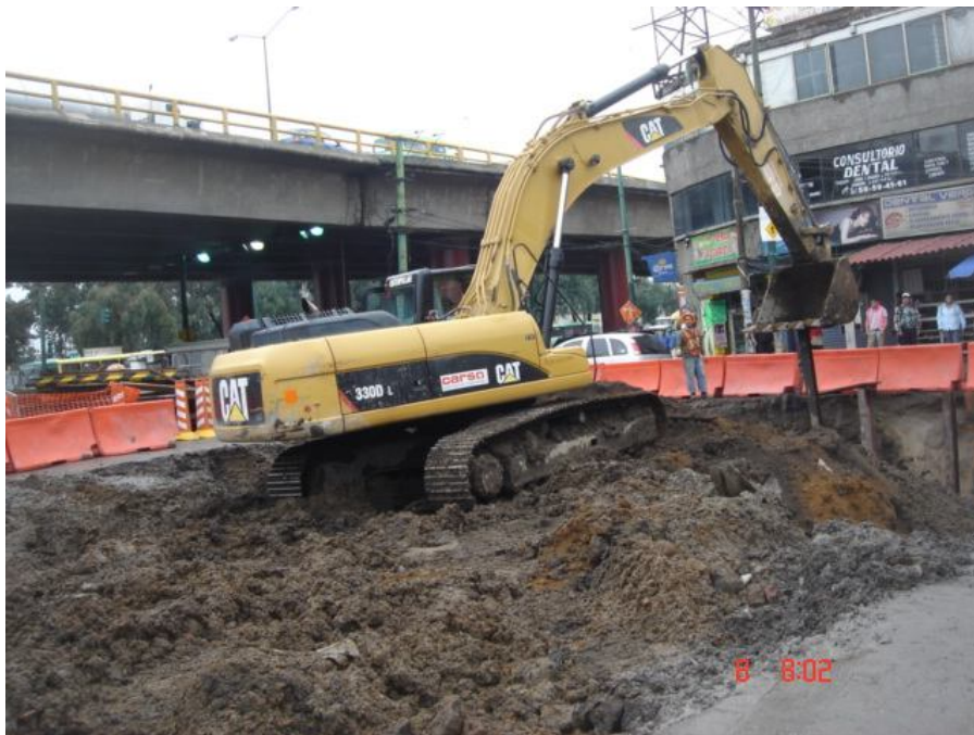
Excavación e hincado de viguetas verticales
