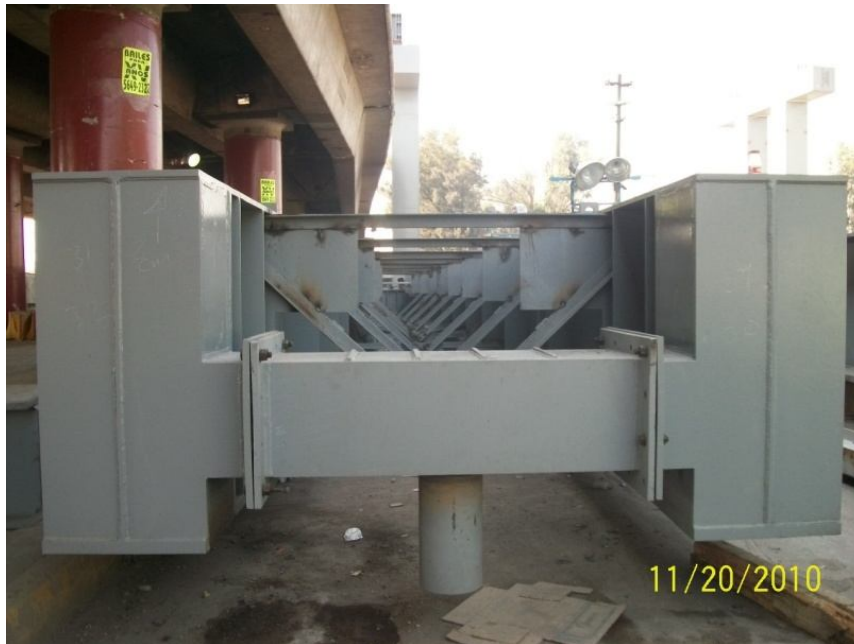
Imagen 38. Tope sísmico fijo
