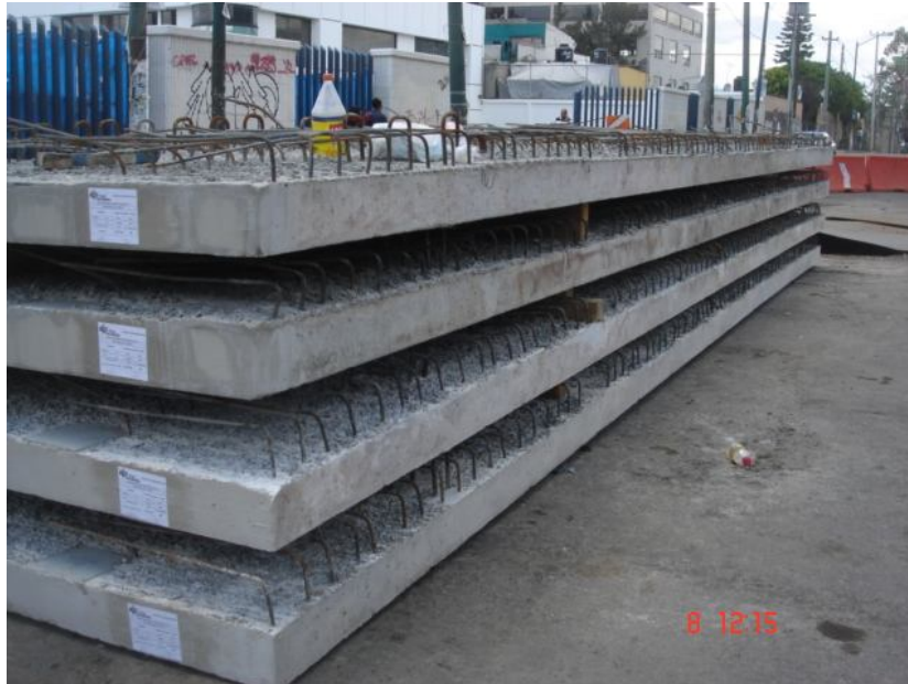
Imagen 39. Tabletillas prefabricadas para zona de vía
