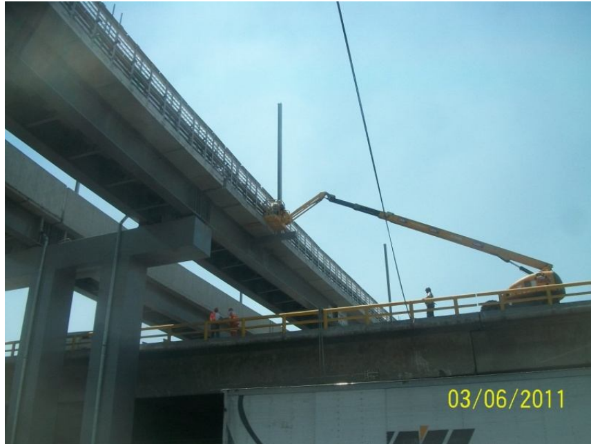
Imagen 64. Colocación postes para catenarias
