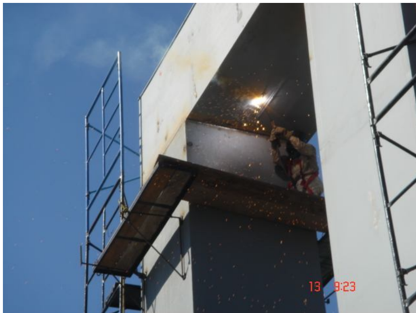
Imagen 28. Trabajos de soldadura en unión de cabezal con columnas metálicas
