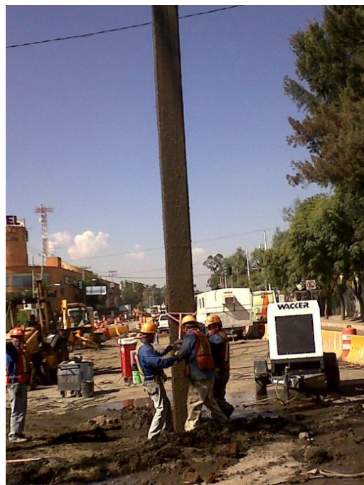
Imagen 6. Izaje, posicionamiento y lanzamiento del pilote de fricción
