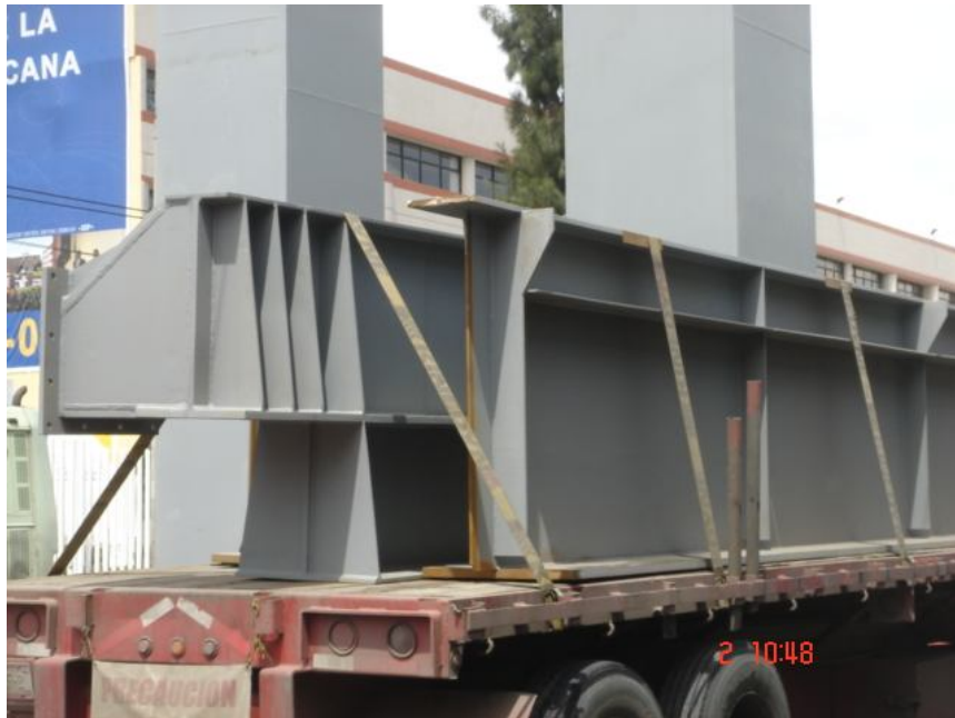
Imagen 30. Traslado de travesaños metálicos
