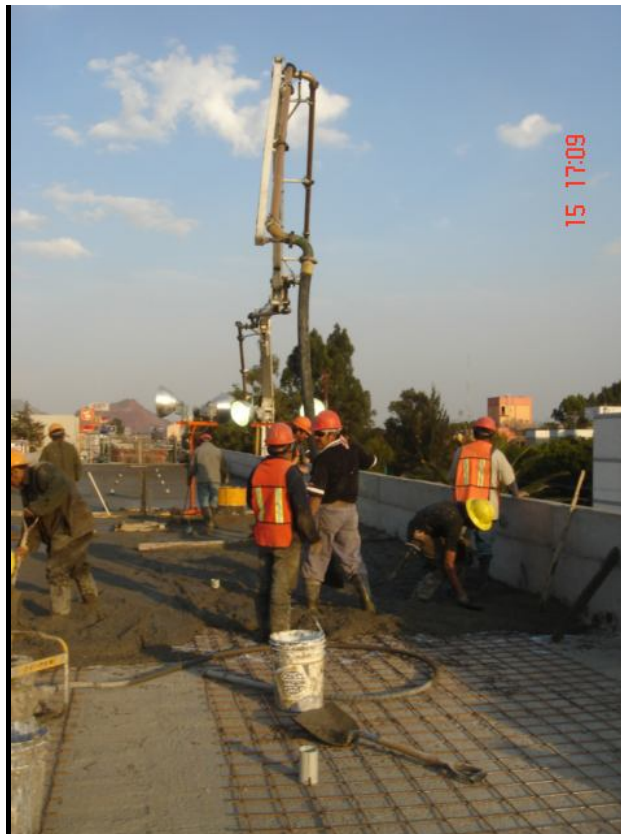
Imagen 45. Colado de segunda capa del firme de compresión
