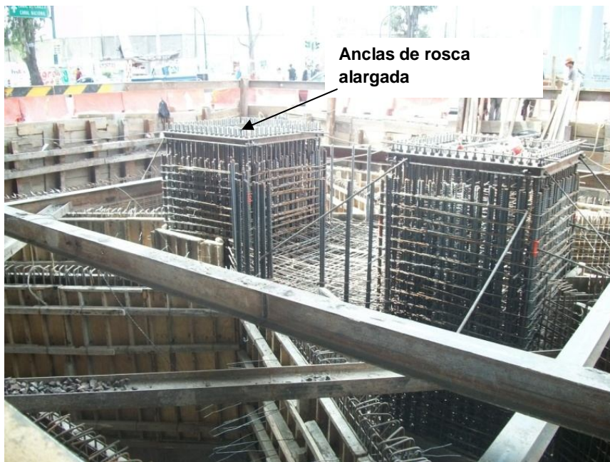
Imagen 15. Colocación de anclas para conexión con columnas metálicas
