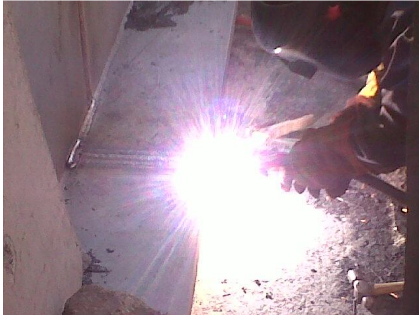
Imagen 33. Aplicación de método arco aire en raíz de patín inferior.
