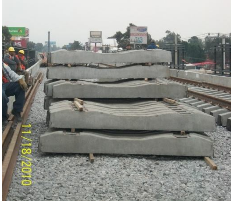
Imagen 52. Durmientes de concreto
