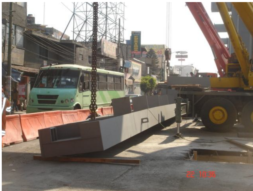
Imagen 31. Colocación de travesaños metálicos en obra
