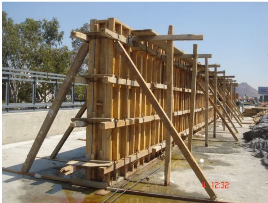
Imagen 47. Cimbrado y colado de muro central y muretes laterales
