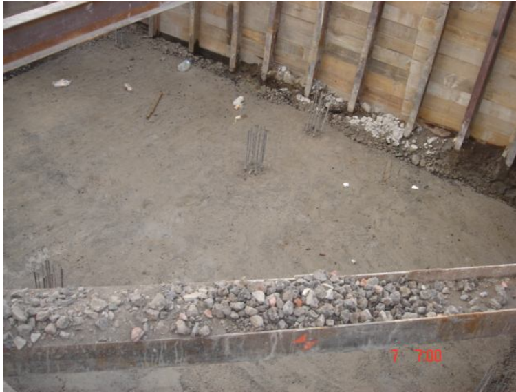
Imagen 8. Plantilla de concreto pobre
