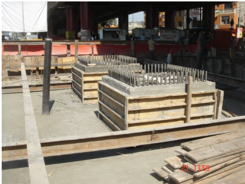
Imagen 19. Recubrimiento de placa de base
