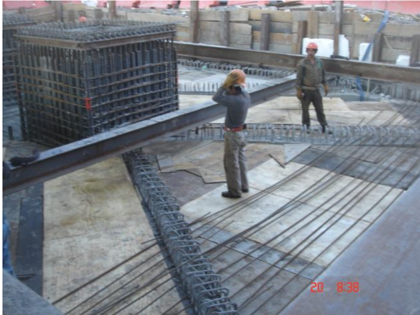
Imagen 17. Colado de losa tapa y colocación de cimbra para el colado de las mismas
