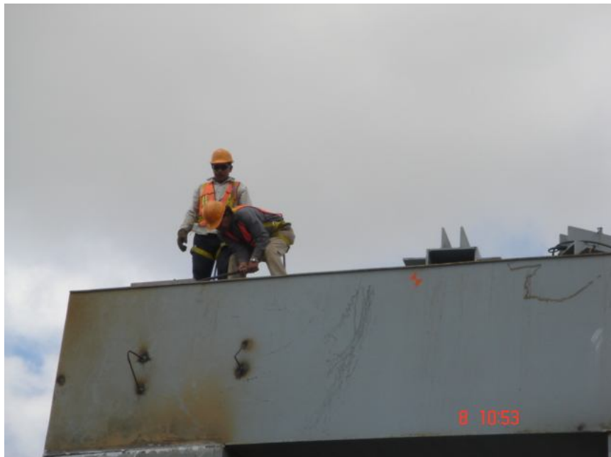
Colocación de los bancos de placas para placas de neopreno
