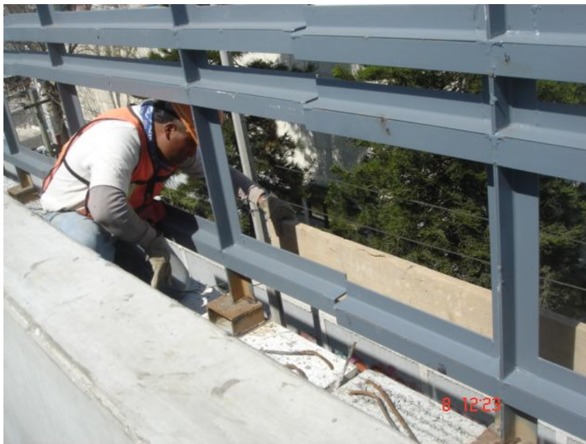
Imagen 57. Calzas para estructura de trinchera
