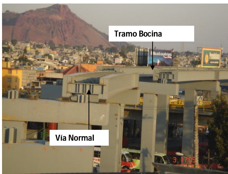
Imagen 2. Tramo en bocina
