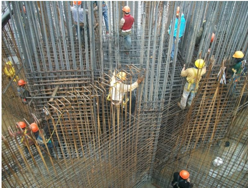
Imagen 12. Armado de muros, contra trabes y dados de columnas
