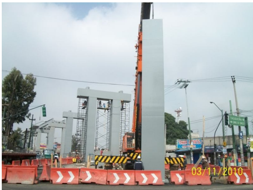
Imagen 22. Montaje de columna metálica con grúa móvil
