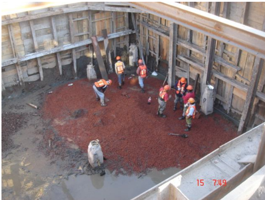
Tendido de cama de Tezontle para efectuar el colado de la plantilla
