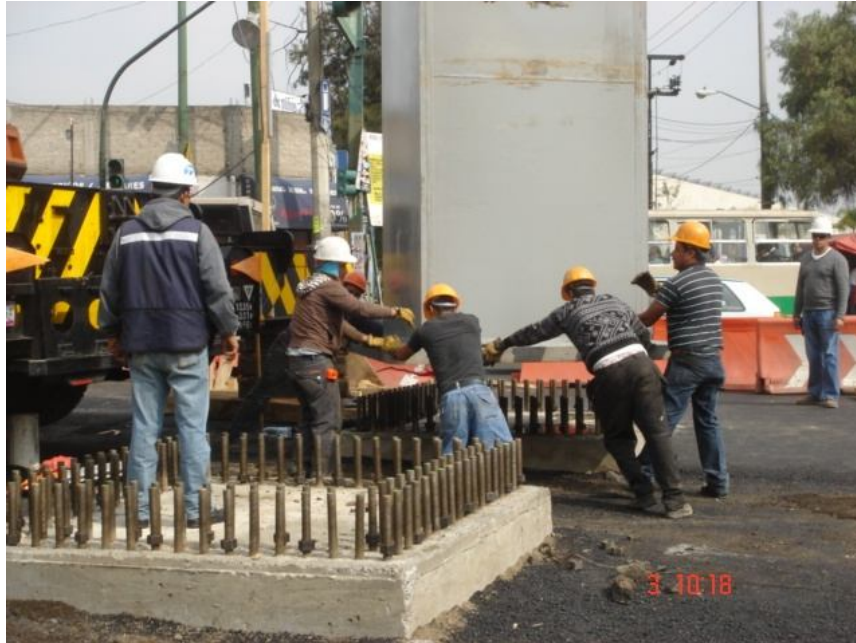
Imagen 23. Guía y empotramiento de columna metálica sobre anclas y base de columna
