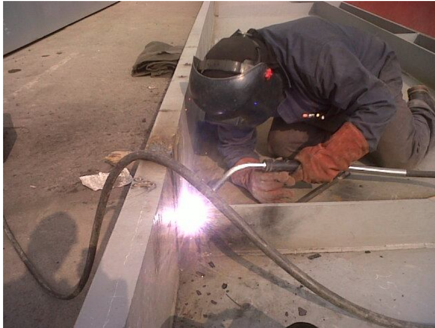
Imagen 32. Soldadura protegida con CO 2
