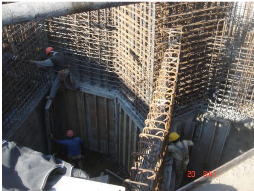
Imagen 13. Primer colado hasta 3.50 m
