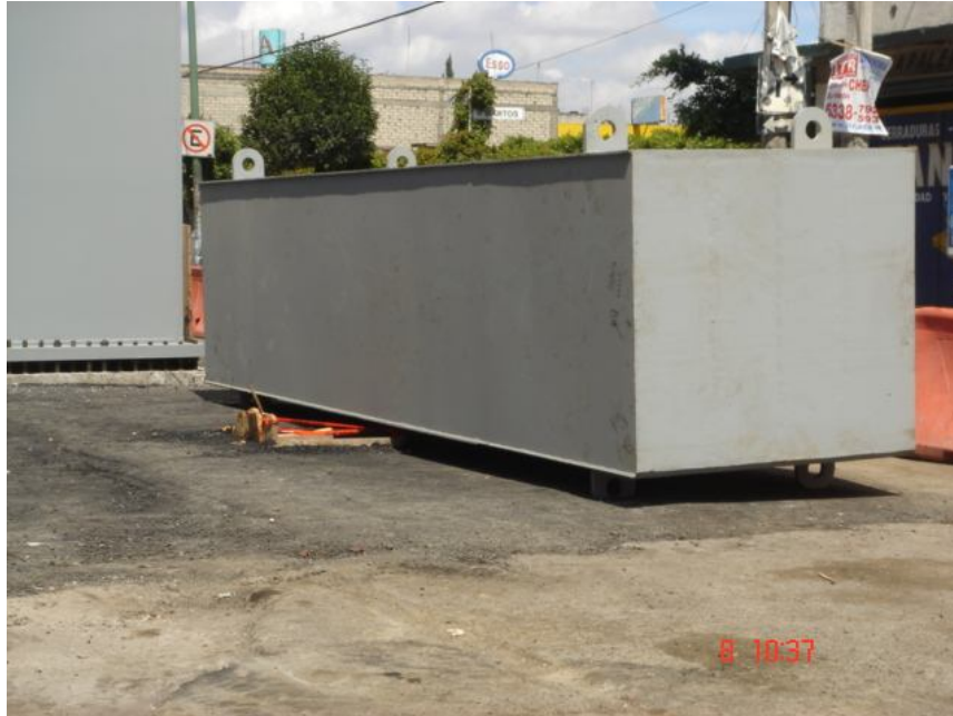
Imagen 27. Orejas para sujeción y montaje de cabezal metálico
