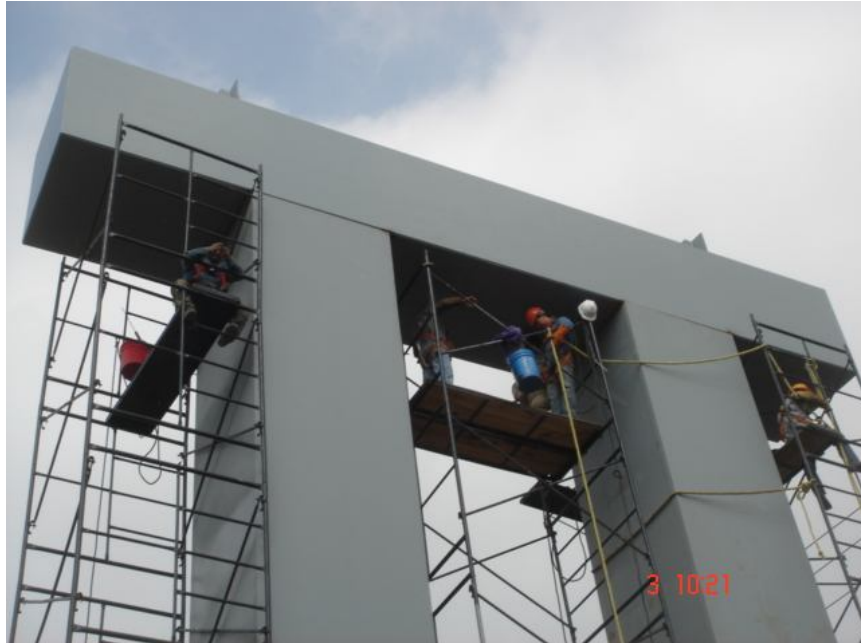
Imagen 29. Trabajos de detalle en soldadura de unión de cabezal con columna
