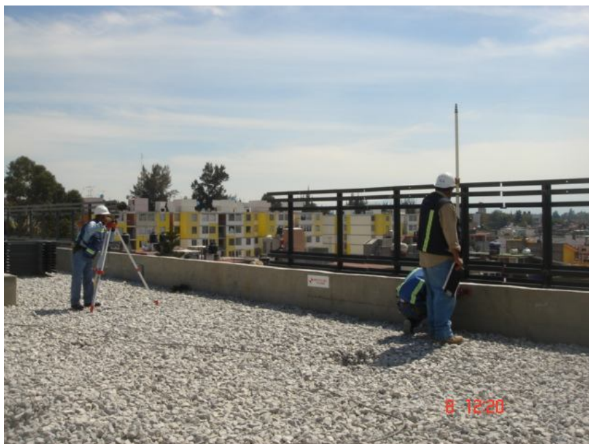
Imagen 51. Nivelación de balasto
