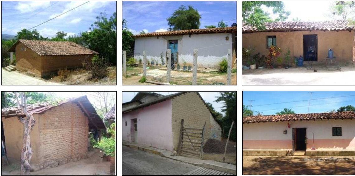
Figura 3.2 Viviendas de adobe en el estado de Guerrero, México (Cortesía de Roberto Arroyo Matus)
