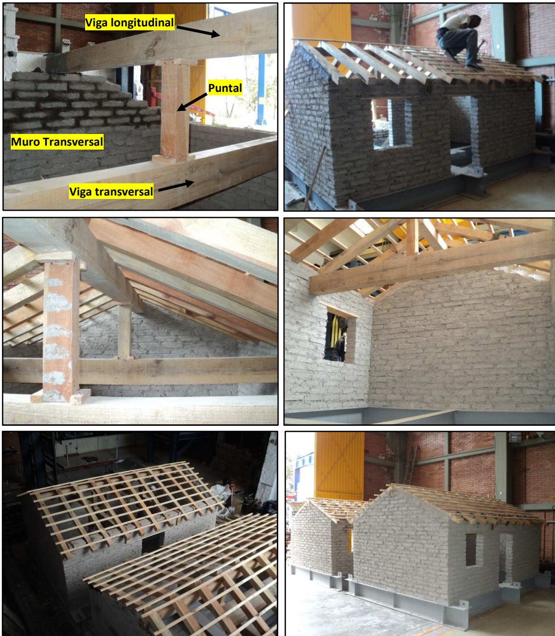
Figura 3.23 Construcción del techo y modelos terminados
