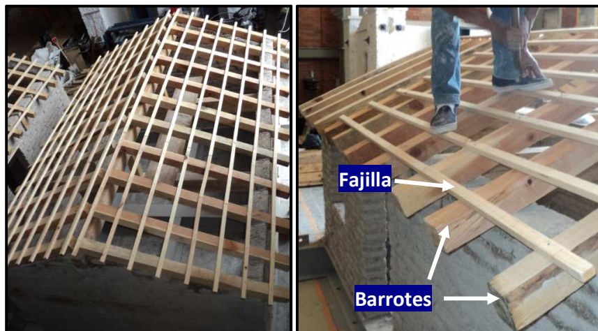
Figura 3.8 Sistema de techo del modelo uno
