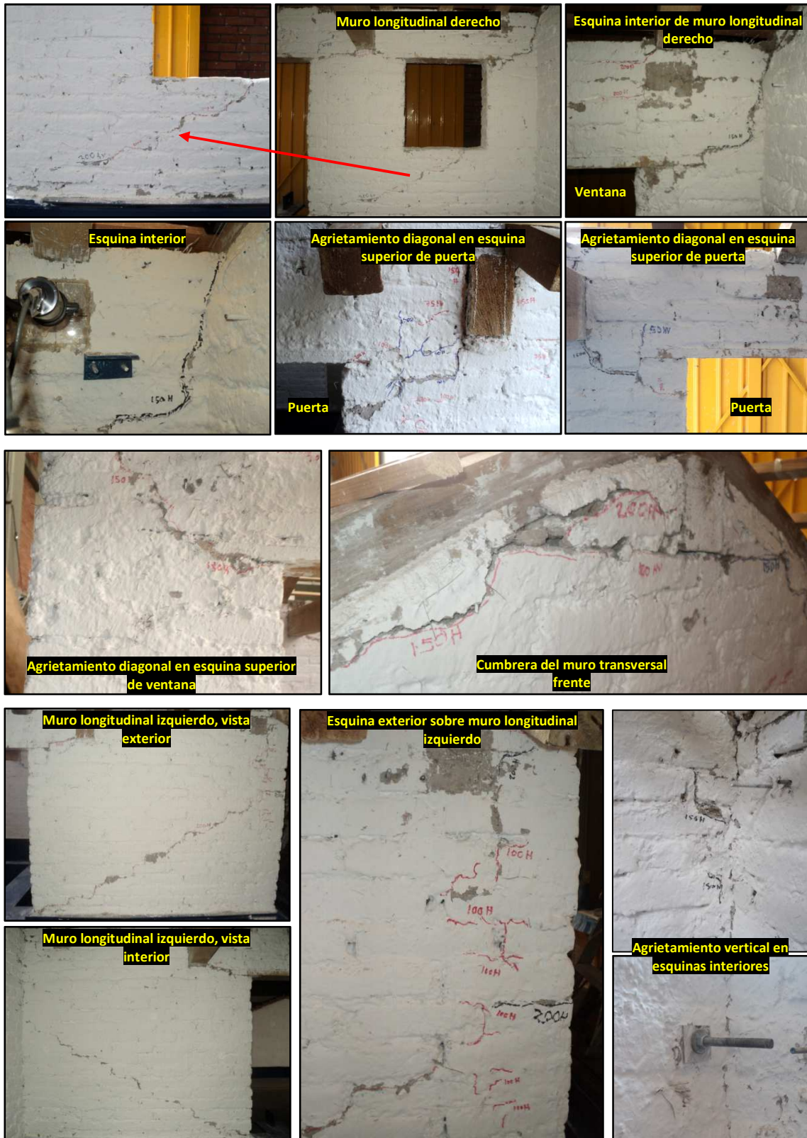
Figura 4.1 Principales daños en el modelo sin refuerzo al final del programa de pruebas
