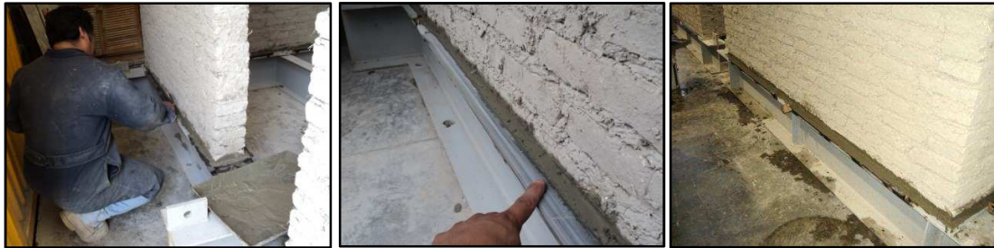
Figura 3.24 Colocación de placas perimetrales y mortero en la base de los modelos
