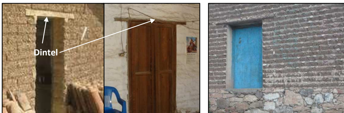
Figura 2.1 Dintel en puerta (izquierda) y cimentación de piedra braza (derecha)
