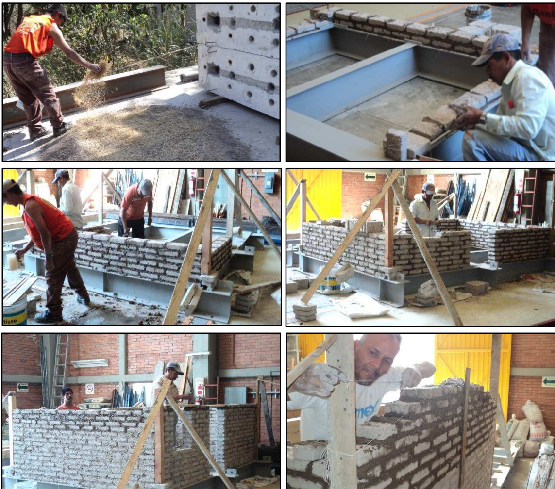
Figura 3.22 Construcción de muros
