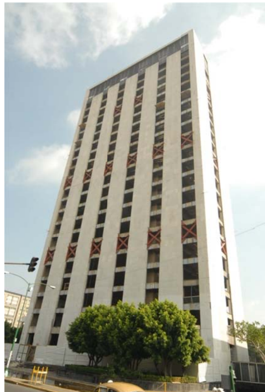
Fig 6.4 Fotografía de distribución de diagonales metálicas ó contraventeos en el eje "K" de la Torre Mayor
