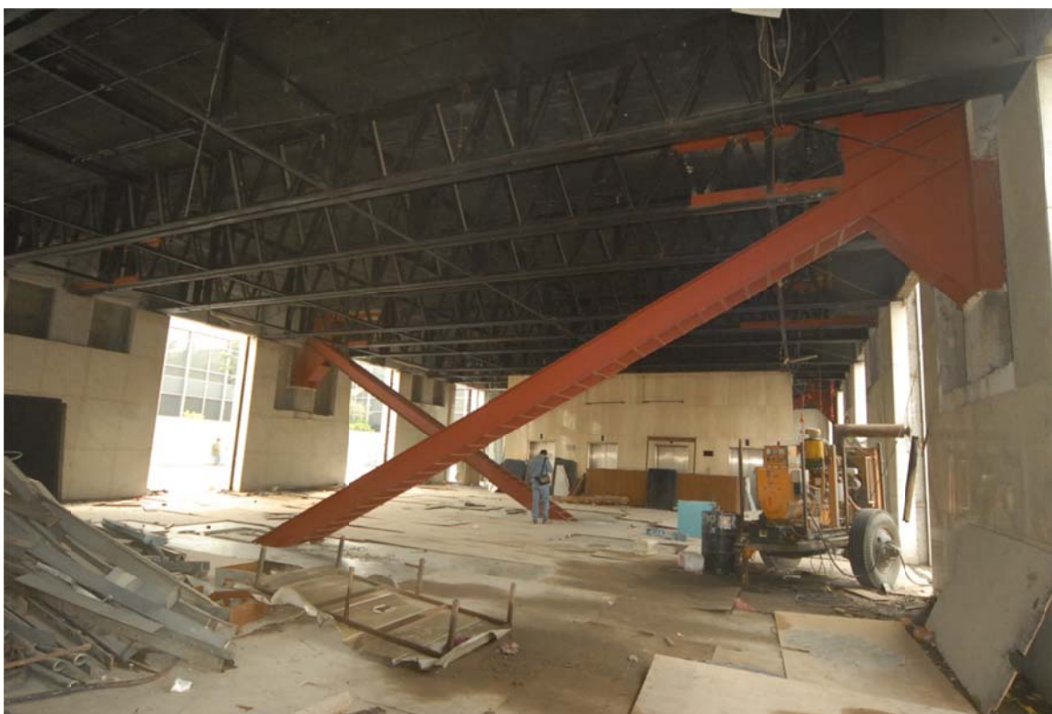
Fig 6.11 Fotografía de macrodiagonales en la dirección transversal de la Torre Mayor
