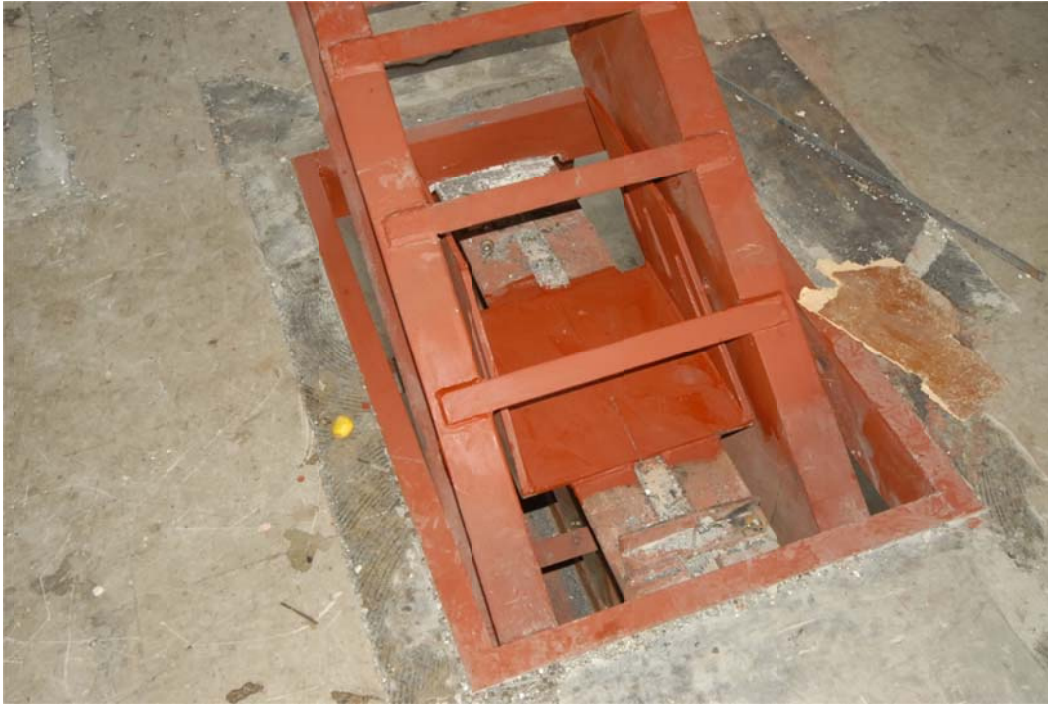
Fig 6.16 Fotografía de macrodiagonales en la dirección transversal de la Torre Mayor
