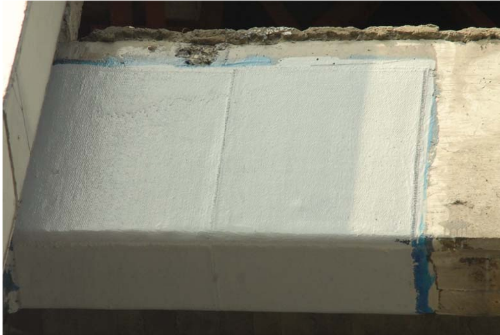
Fig 6.24 Fotografía de refuerzo de traveses existentes de los ejes “H”, “K” y “12” de la Torre Mayor con fibras de carbono
