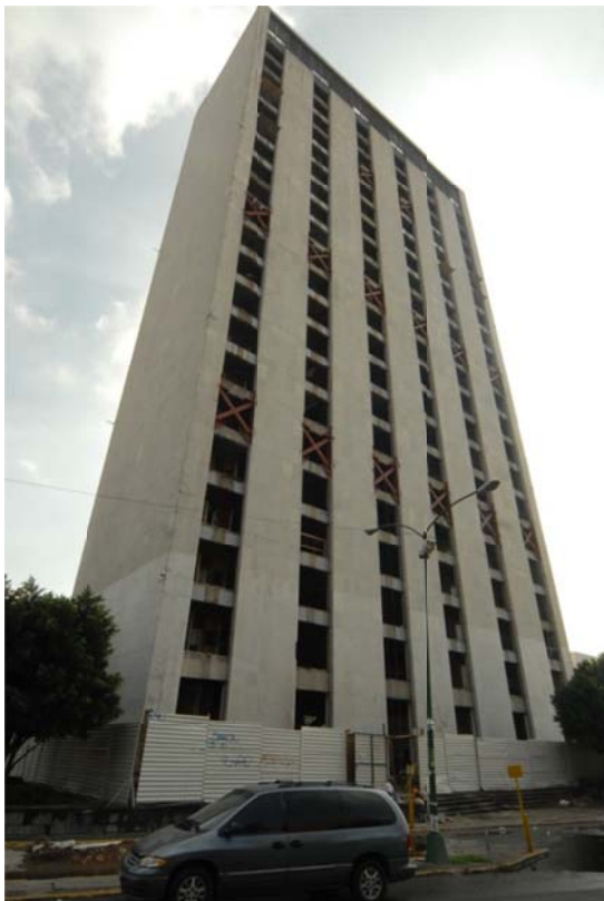
Fig 6.4 Fotografía de distribución de diagonales metálicas ó contraventeos en el eje "K" de la Torre Mayor
