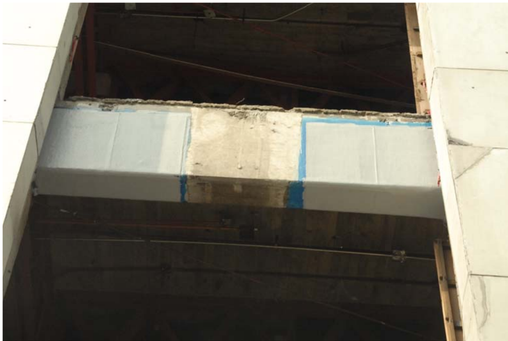
Fig 6.23 Fotografía de refuerzo de traveses existentes de los ejes “H”, “K” y “12” de la Torre Mayor con fibras de carbono
