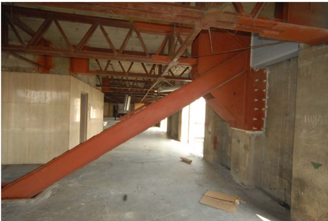
Fig 6.17 Fotografía de conexión de macrodiagonales con la estructura existente, de la Torre Mayor
