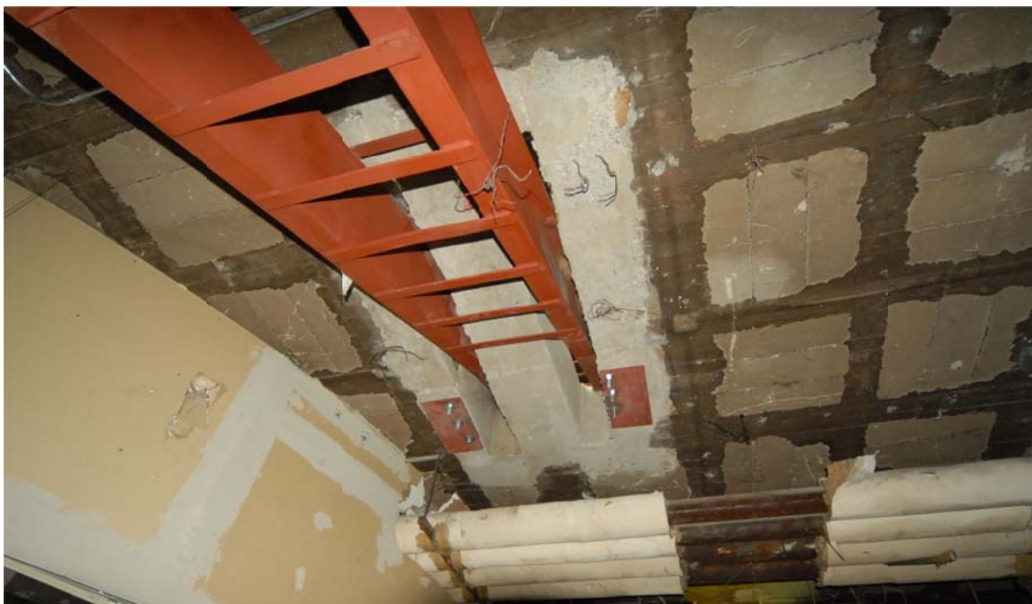
Fig 6.10 Fotografía de macrodiagonales en la dirección transversal de la Torre Mayor
