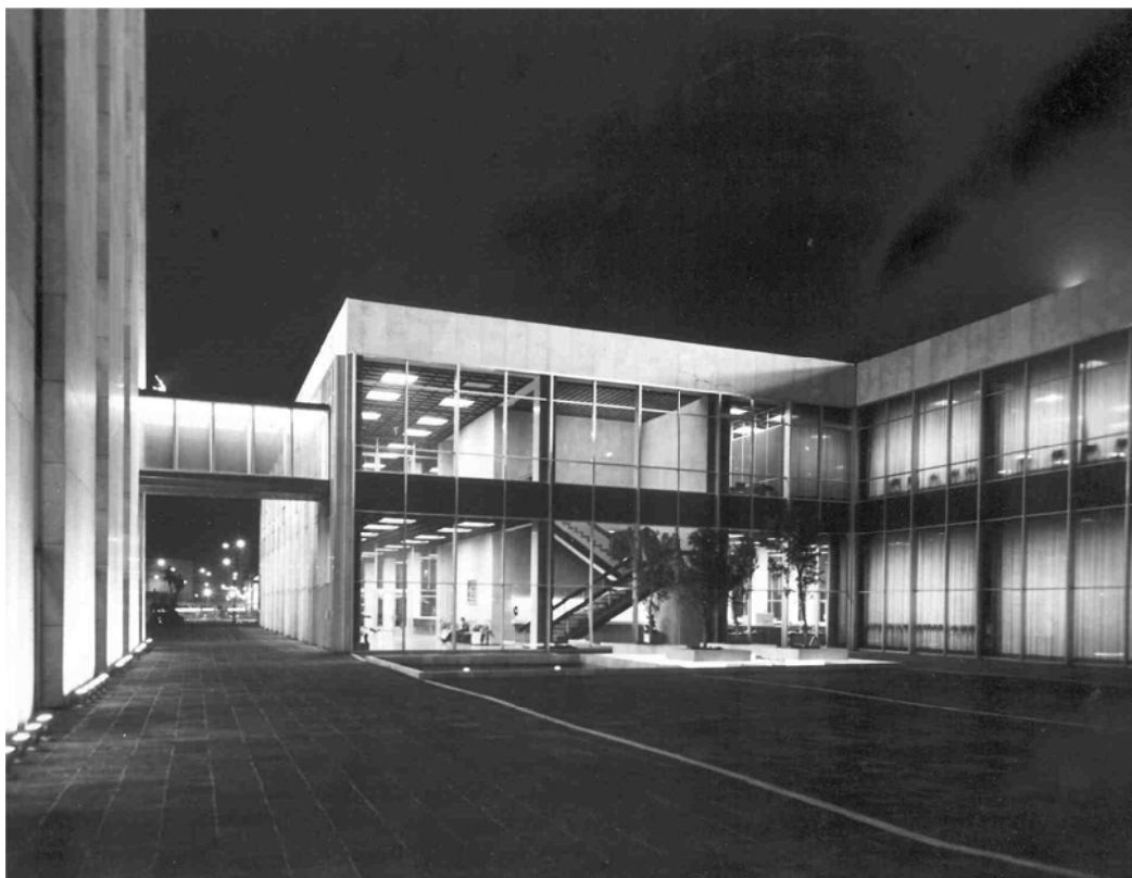
Fig 3.28 Fotografía del puente de comunicación entre Torre Mayor y Cuerpos Bajos (falló en los sismos de 1985)
