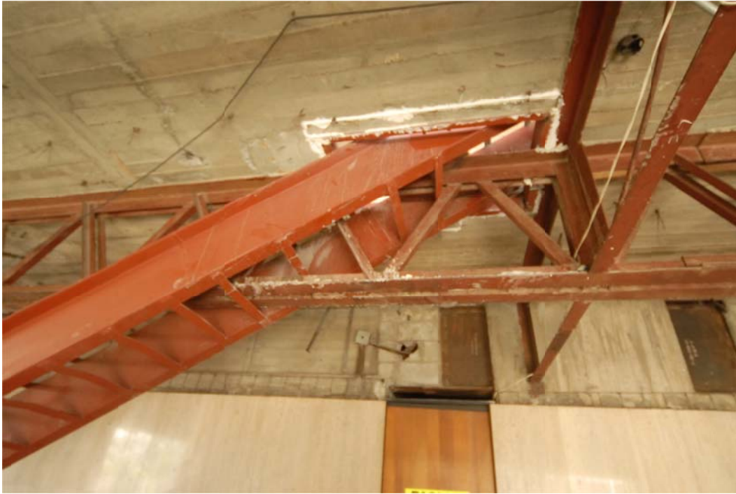
Fig 6.14 Fotografía de macrodiagonales en la dirección transversal de la Torre Mayor
