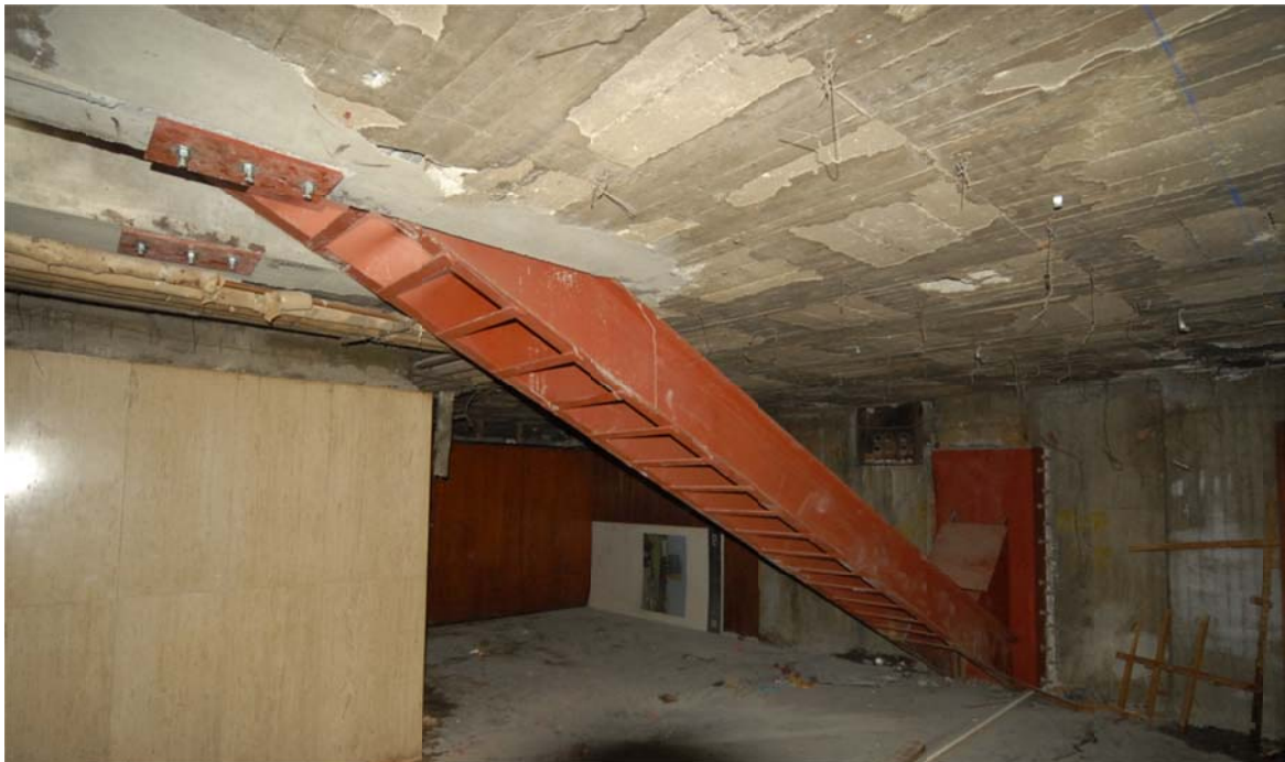
Fig 6.8 Fotografía de macrodiagonales en la dirección transversal de la Torre Mayor
