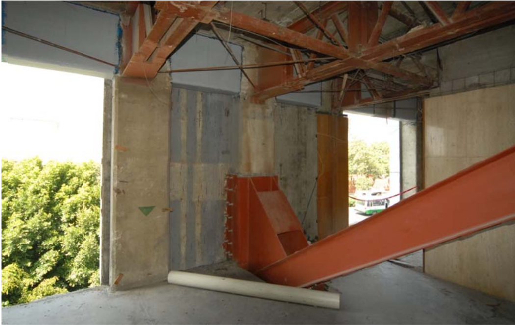
Fig 6.18 Fotografía de conexión de macrodiagonales con la estructura existente, de la Torre Mayor
