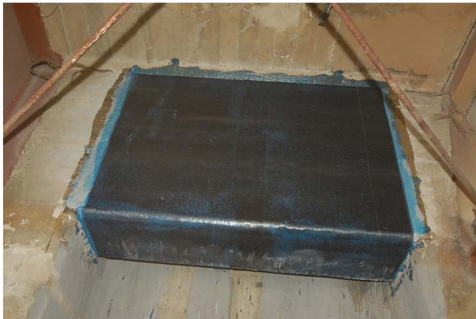
Fig 6.24 Fotografía de refuerzo de traveses existentes de los ejes “H”, “K” y “12” de la Torre Mayor con fibras de carbono
