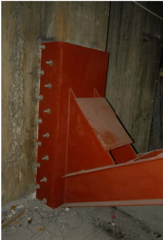
Fig 6.19 Fotografía de conexión de macrodiagonales con la estructura existente, de la Torre Mayor
