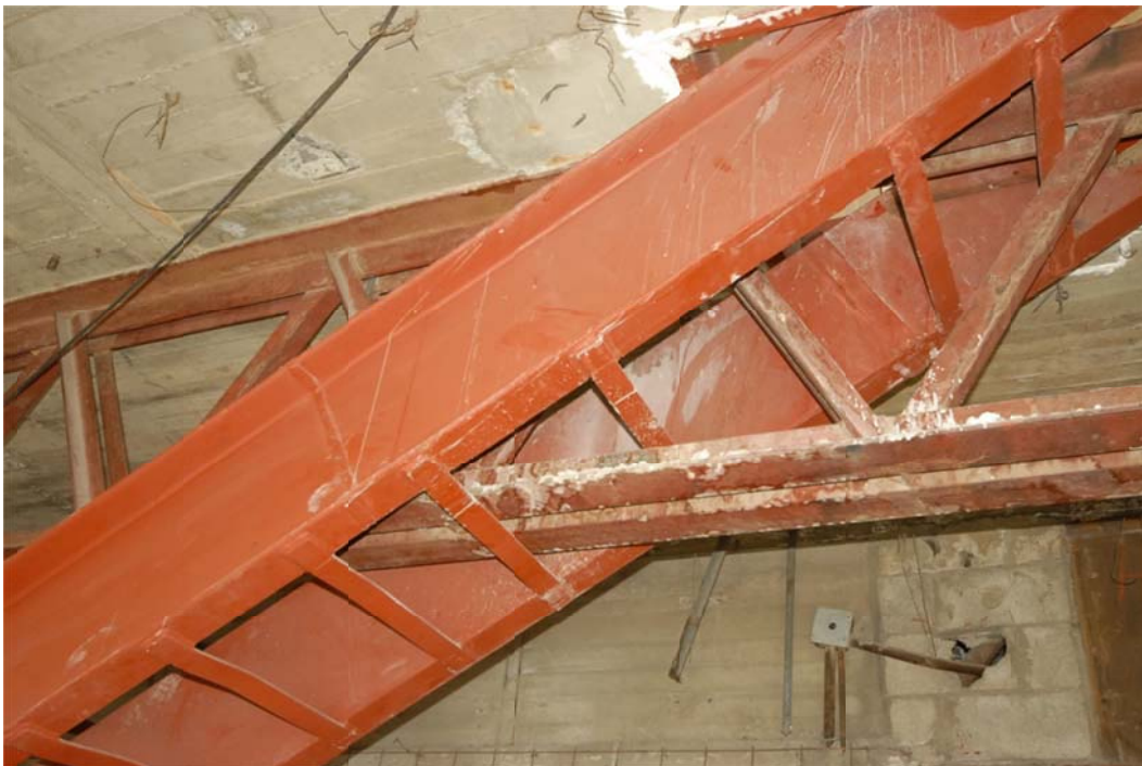
Fig 6.15 Fotografía de macrodiagonales en la dirección transversal de la Torre Mayor
