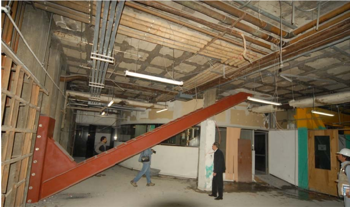
Fig 6.8 Fotografía de macrodiagonales en la dirección transversal de la Torre Mayor
