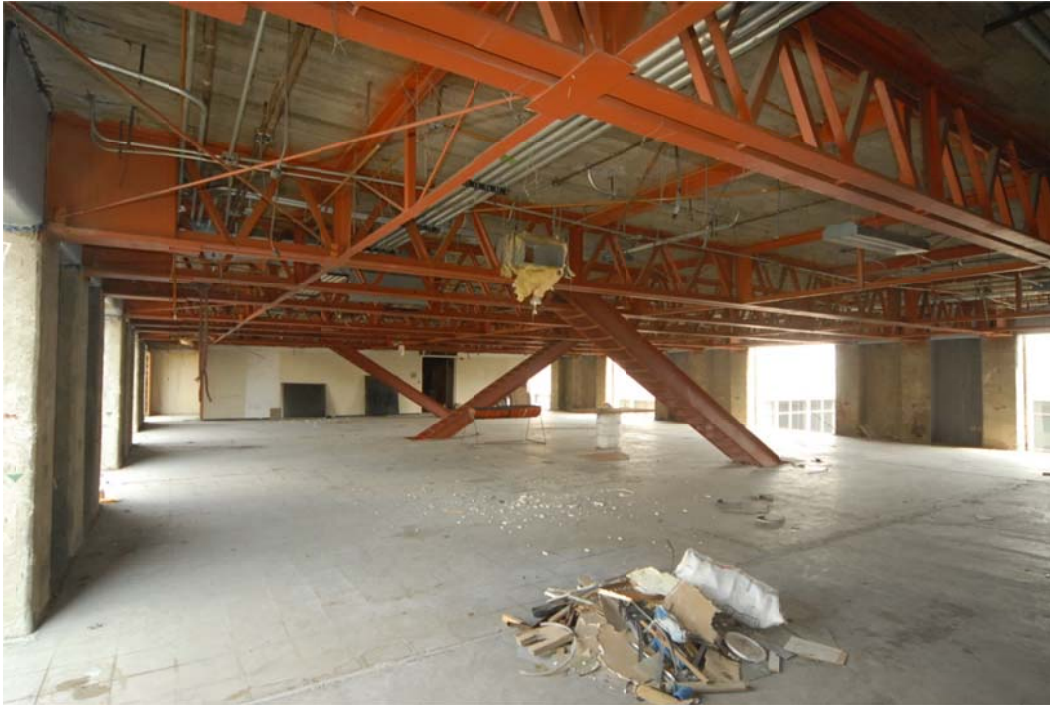
Fig 6.12 Fotografía de macrodiagonales en la dirección transversal de la Torre Mayor
