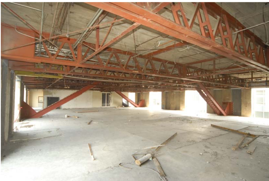
Fig 6.13 Fotografía de macrodiagonales en la dirección transversal de la Torre Mayor
