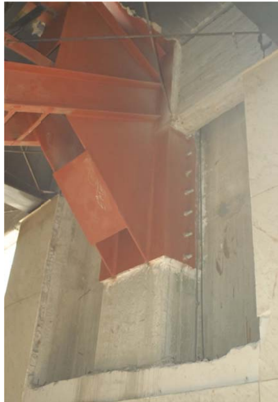
Fig 6.19 Fotografía de conexión de macrodiagonales con la estructura existente, de la Torre Mayor
