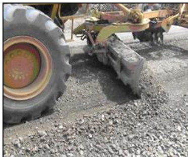
Fig. 10 Proceso constructivo de la imprimación reforzada
