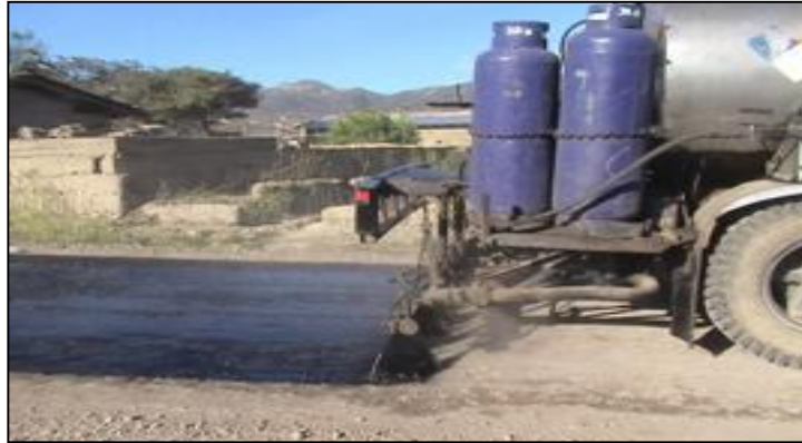
Fig. 8 Ejecución de la imprimación
