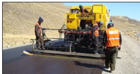
Fig. 16 Estabilización con emulsión asfáltica
