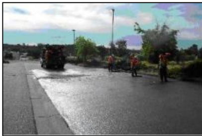
Fig.14 Ejecución del Slurry Seal
