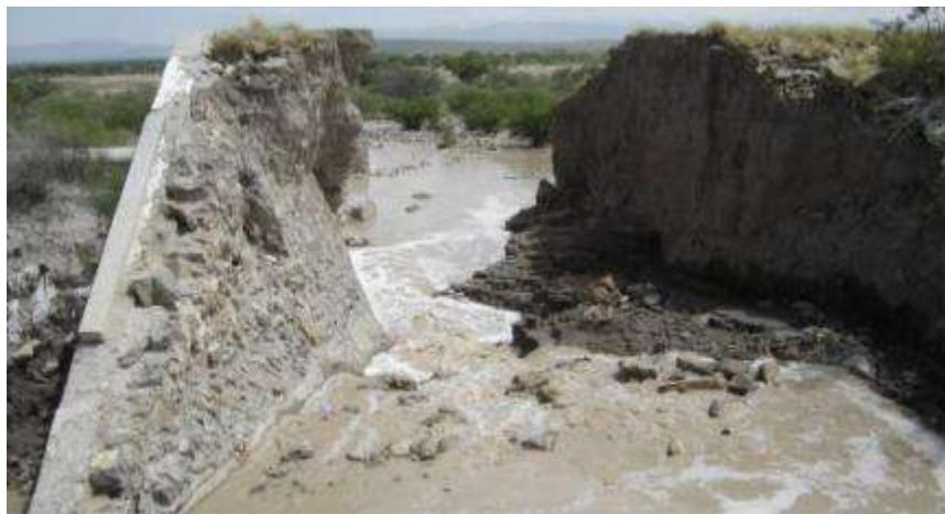
**Fig. 1-24** Presa Piedra Blanca, Coah. Segunda falla por tubificación, 2007. *Marengo (2011).*
