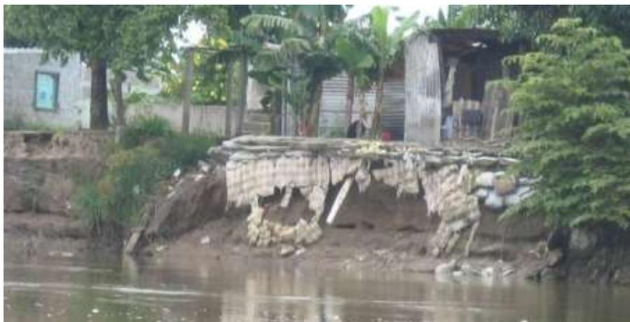
**Fig. 1-22** Evidencias de falla por tubificación en bordos marginales del río Carrizal.
