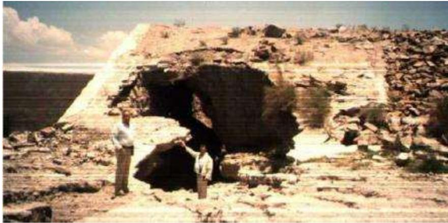
**Fig. 1-23** Presa Piedra Blanca, Coah. Primera falla por tubificación, 1999. *Marengo (2011).*
