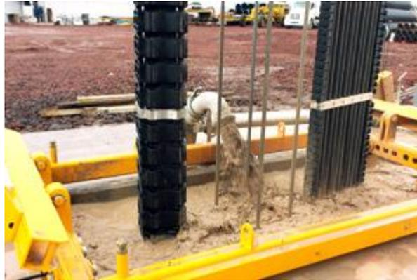
Figura 46. Recirculación de lodos en excavación de tableros<sup>59</sup>
