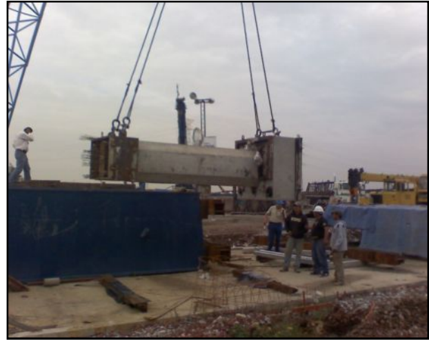
Figura 3.3 Proceso de construcción de un espécimen a escala 1/4. Armado y descimbrado de la columna.
