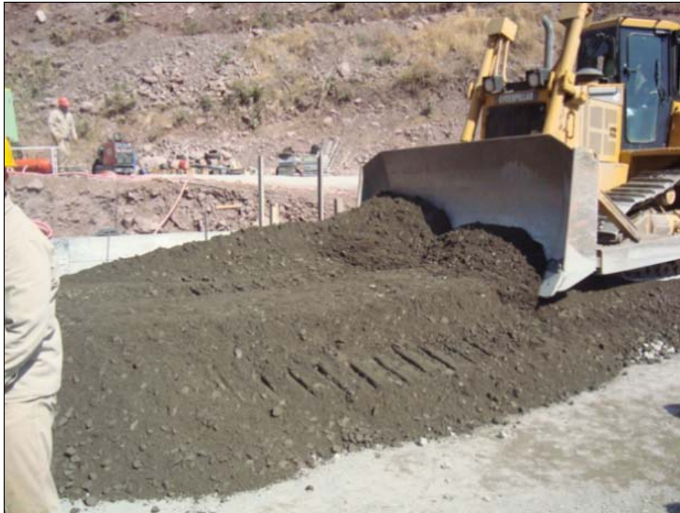
Figura VII-5 . Tendido del CCR
