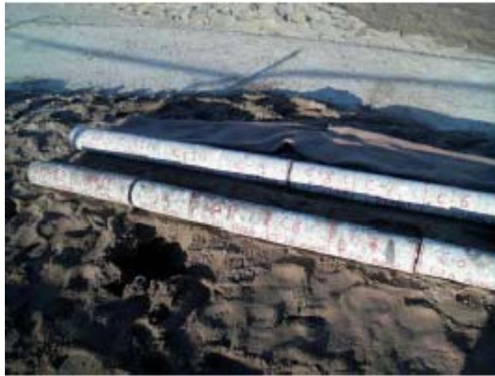
Figura VII-14 Testigos de 3 m de longitud extraídos de la losa de ensayo.
