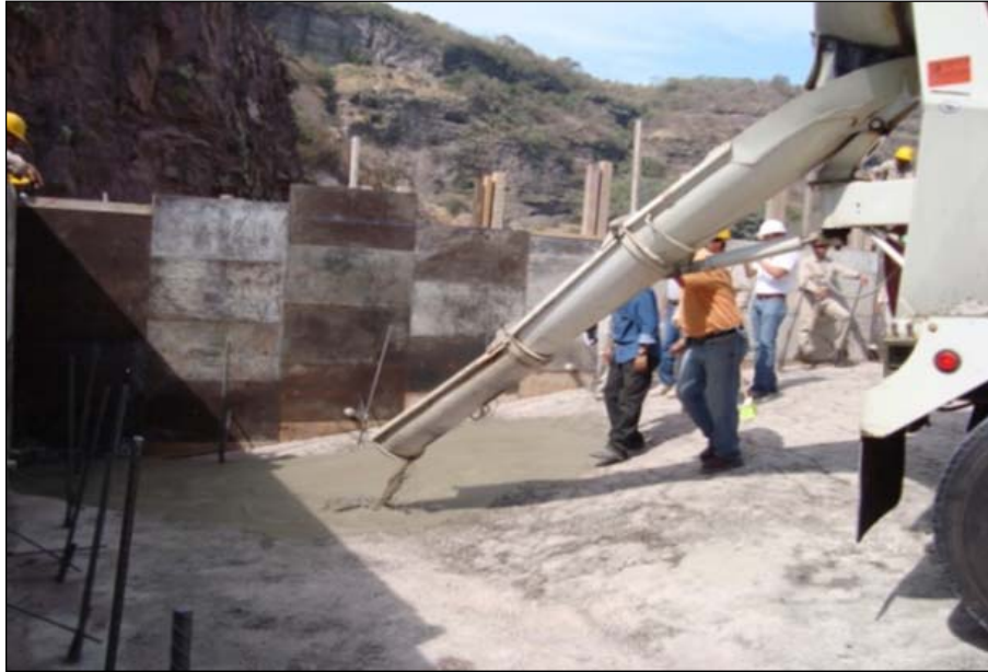
Figura VII-7. Colocación del mortero de liga
