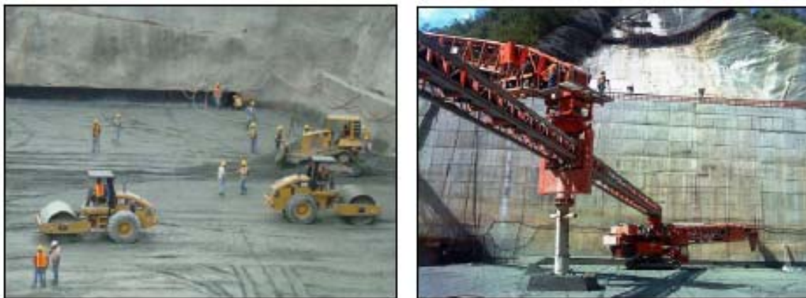
Figura VII-25 Equipos de distribución y compactación del CCR
