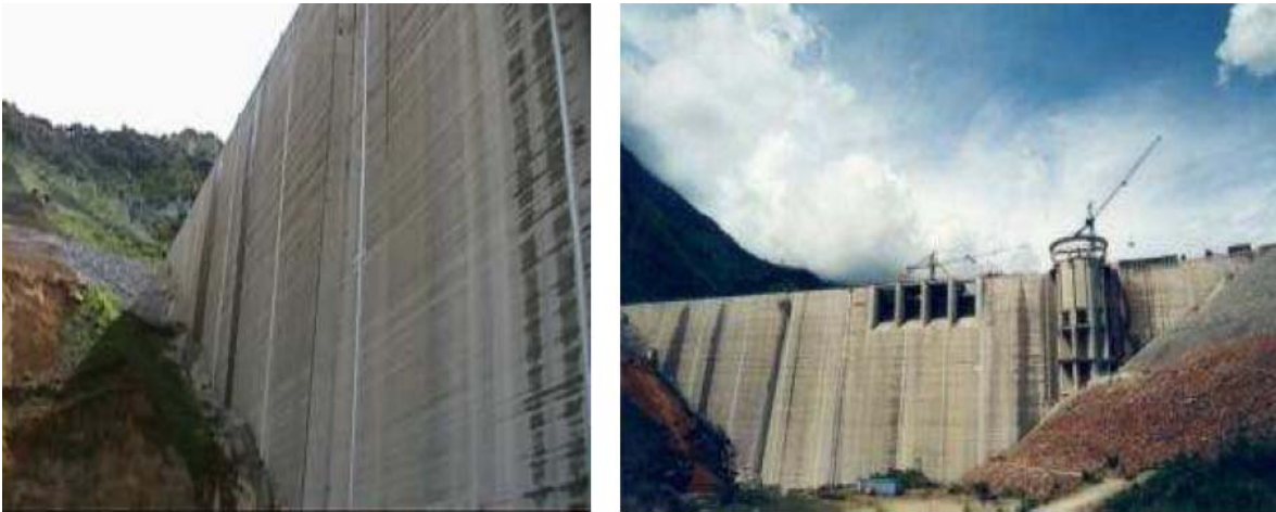
Figura VII-34 Vista exterior de la instalación de los waterstops.
