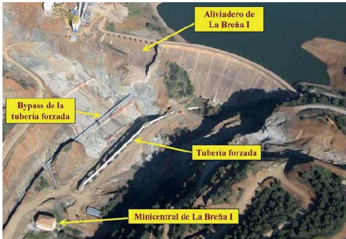
Figura VII-12 Vista general de las obras para el desvío
