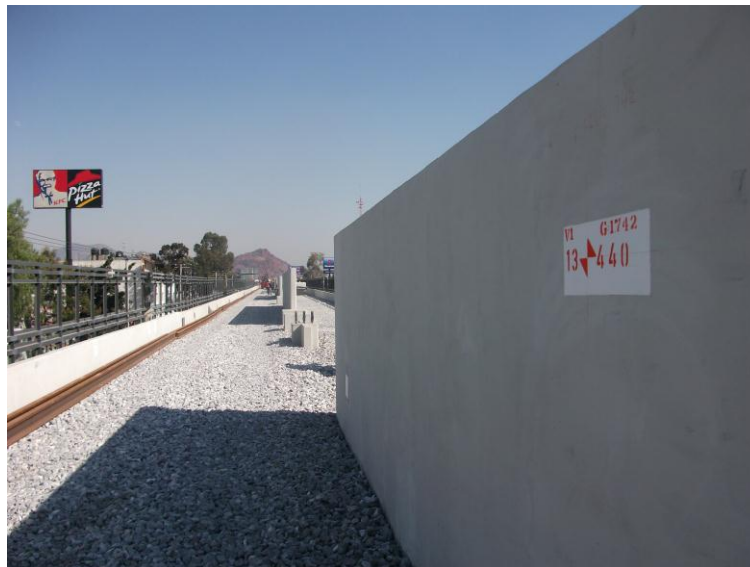
Marcas para la colocación de vía.
