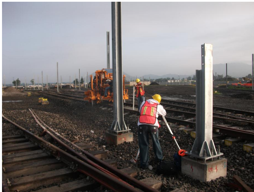
Calzado y ajuste de vía.
