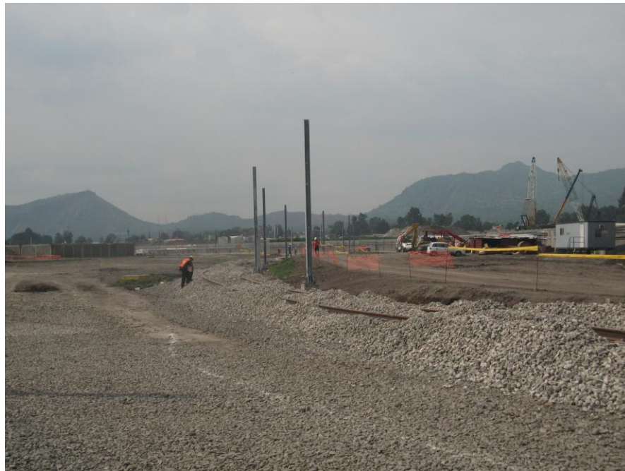
Esparcimiento de balasto.
