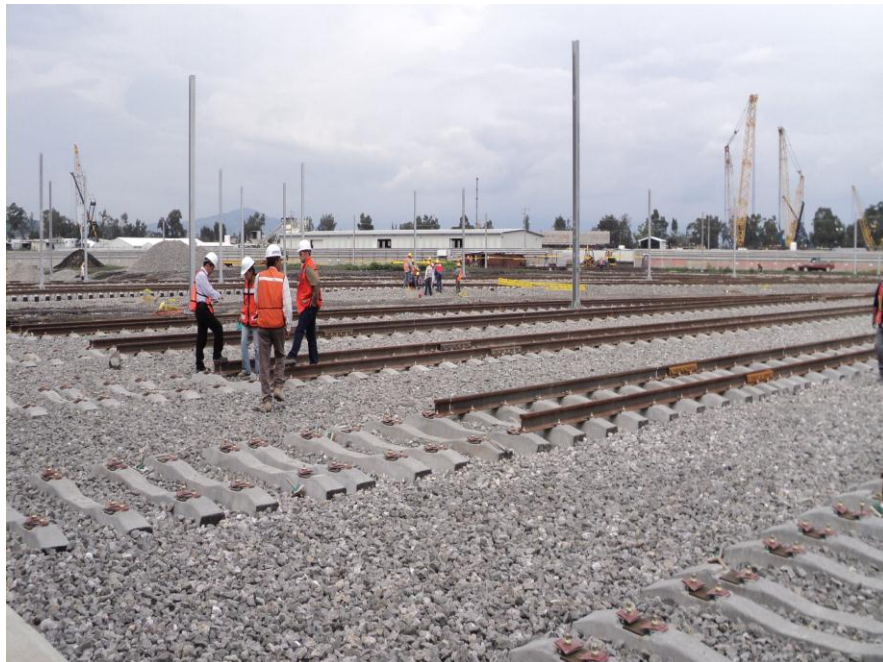
Armado de vía.
