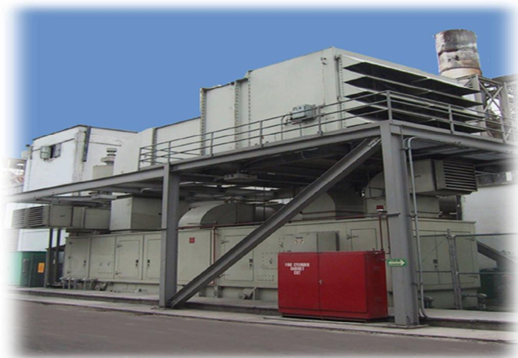
Foto 1. Central de cogeneración con turbogenerador a gas natural.
