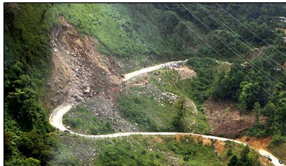
Figura 1.15. Ejemplo de un flujo de lodo que bloqueó un camino en la comunidad de Eloxochitlán, Puebla. Mayo 2007. Fuente: USA Today
