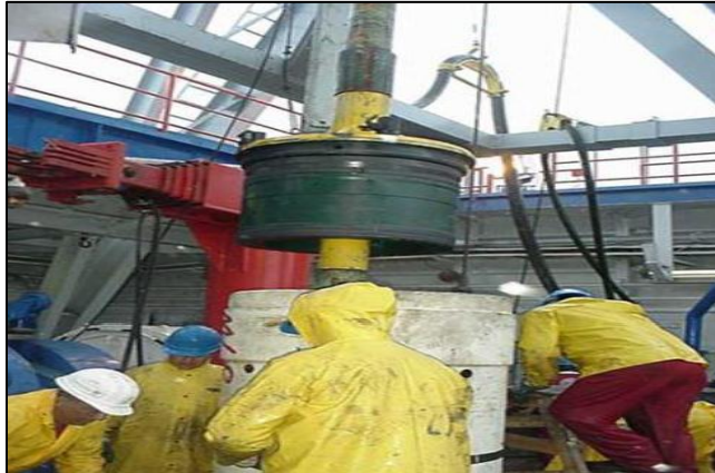
Figura 5.10 Conector del cabezal.
