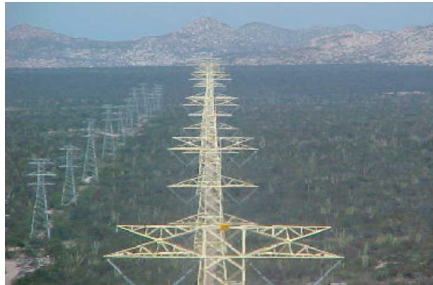
Fig. 2 Productos División Eléctrica (Líneas de Transmisión) Fuente: Portal Abengoa
