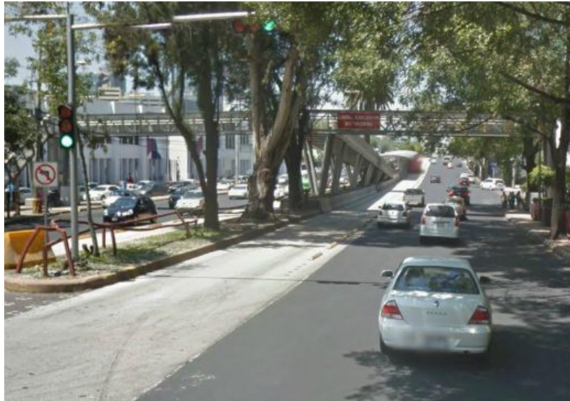
Ilustración 102 Estación Villa Olímpica Línea 1 Metrobús, alejada de la intersección
