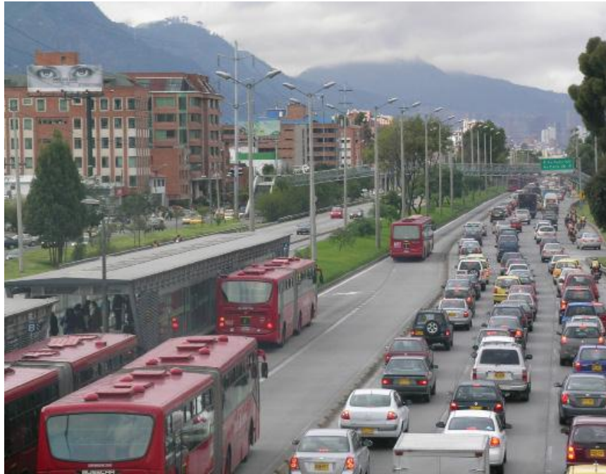
Ilustración 61 Transmilenio en Bogotá, Colombia, fue el primero en incluir carriles de rebase.
