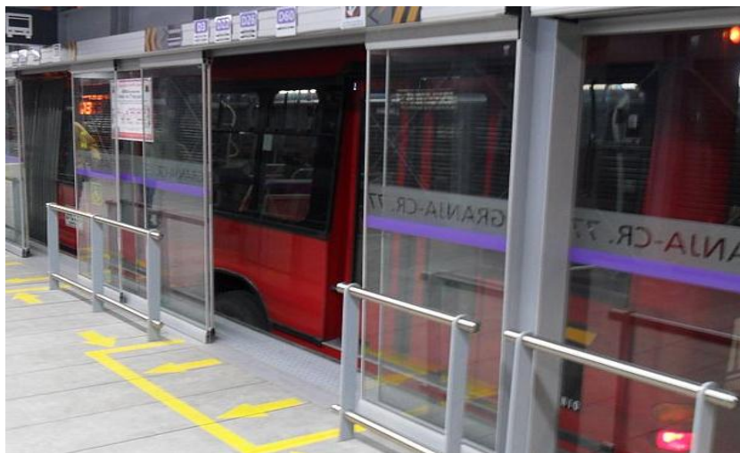
Ilustración 113 Puerta corrediza en estación sistema Transmilenio
