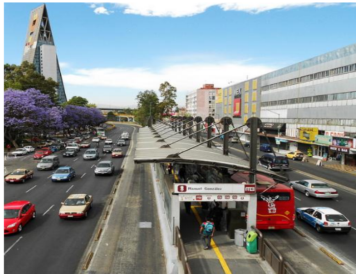
Ilustración 104 Estación del metrobús Línea 1 al centro de la calle
