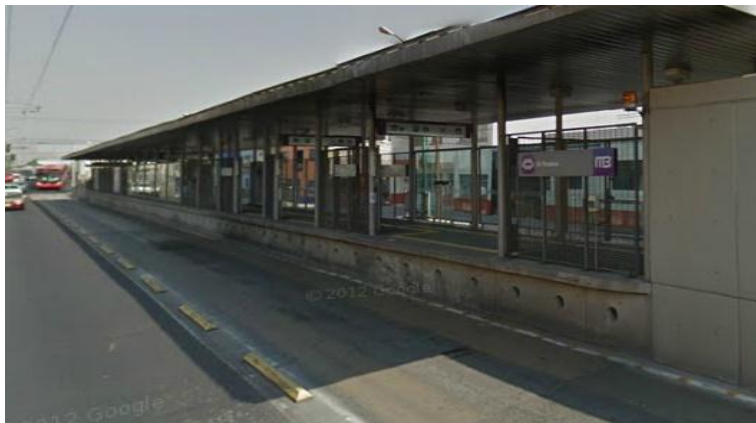
Ilustración 167 Línea 2 del Metrobús, estación sin paradas secundarias
