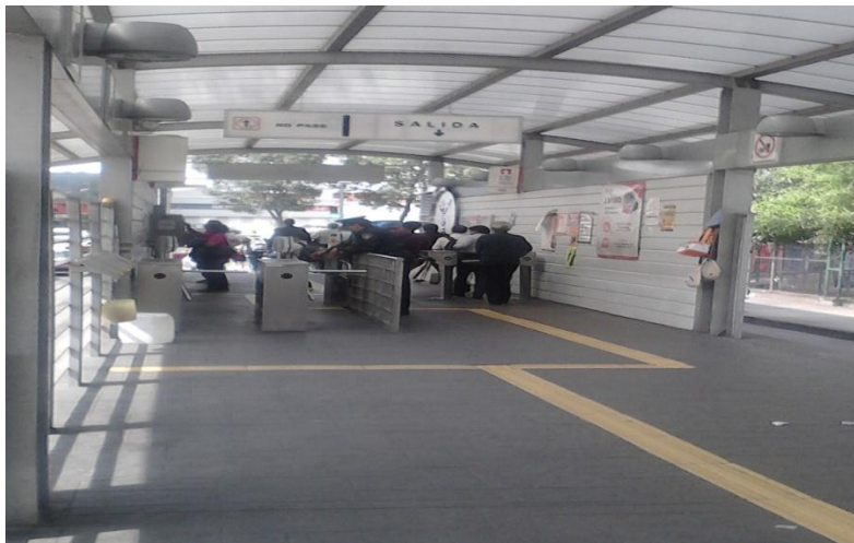
Ilustración 147 Estación de la Línea 1 con buen mantenimiento
