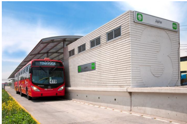
Ilustración 234 Marca para asegurar el acoplamiento del autobús y la plataforma
