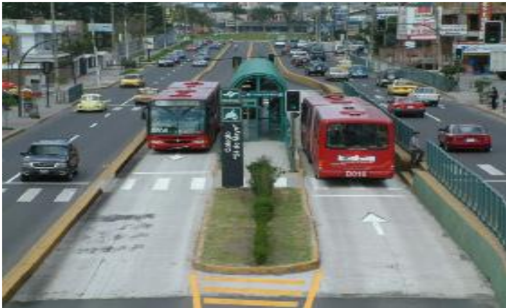
Ilustración 64 Estación en plataforma central Quito, Ecuador.
