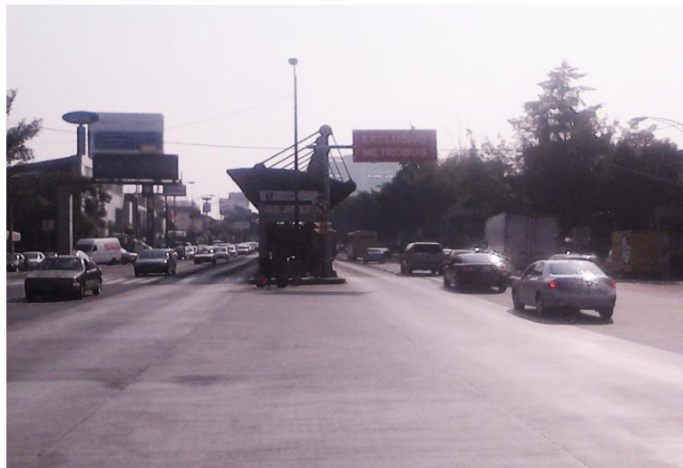
Ilustración 79 Alineación de carriles sistema Metrobús, Línea 1
