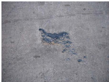
Figura. 2.1 Fotografía de un piso con un deterioro a simple vista; la parte faltante dejó un hueco que fácilmente se desmorona.
