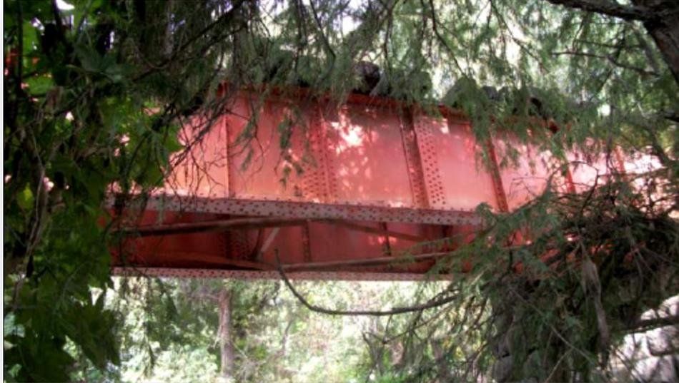
*Figura 2.3 Traveses longitudinales de acero de 1.61 m de peralte, contraventeadas en sentido transversal y horizontal*
