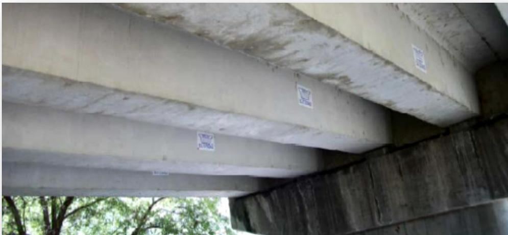
*Figura 2.22 Superestructura, conformada por un firme apoyado en cinco traveses de sección cajón con aletas.*
