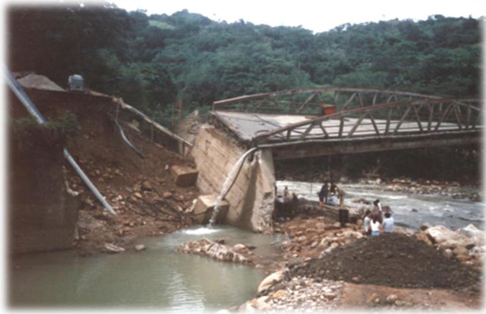
*Figura 1.1 Fallo del estribo del puente Unete (Colombia) por socavación*
