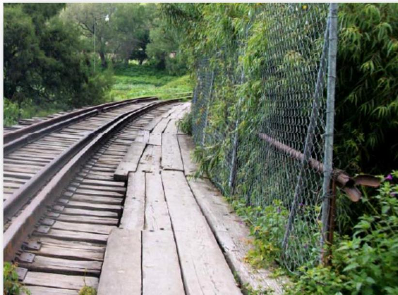
*Figura 2.4 Arreglo de vías de ferrocarril y andador peatonal improvisado con malla de protección*
