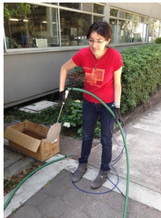
Figura 31. Colocación de ducto de protección a los cables de los instrumentos
