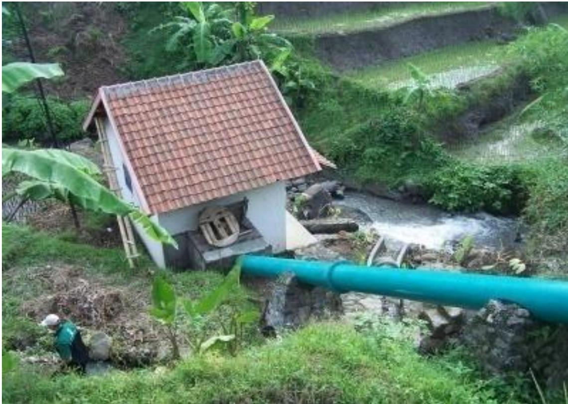
Figura 3.16 Casa de maquinas en una mini-central hidroeléctrica
