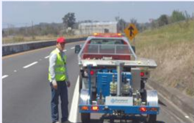
Se observa la preparación del equipo FWD
