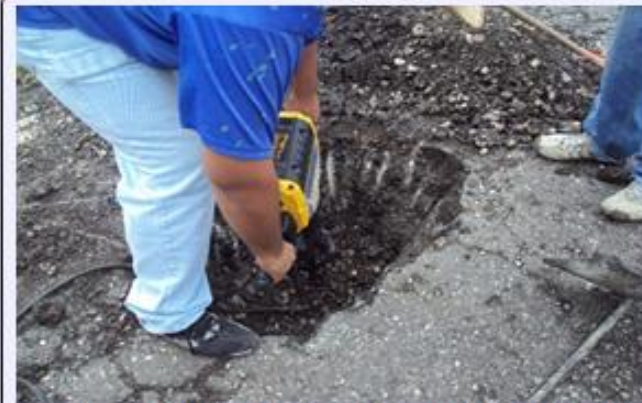
Se observa la realización de sondeos en la superficie del pavimento
