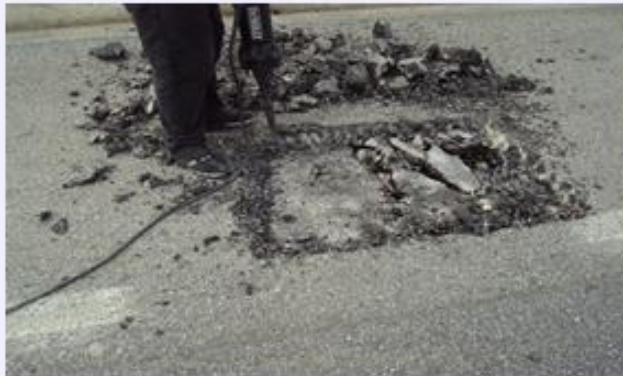
Se observa la realización de sondeos en la superficie del pavimento
