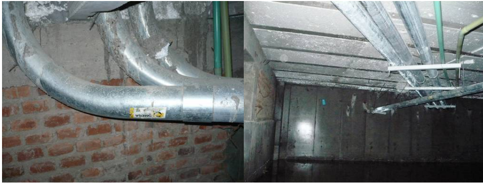
Fig. 5.8 Área a dismantlar para nuevo Alimentador.
