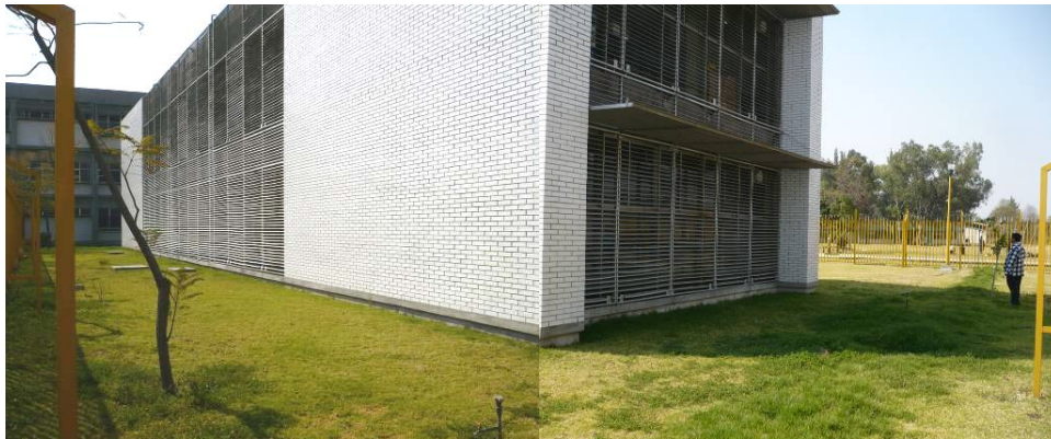
Fig. 5.4 Vista posterior del Centro de Cómputo.
