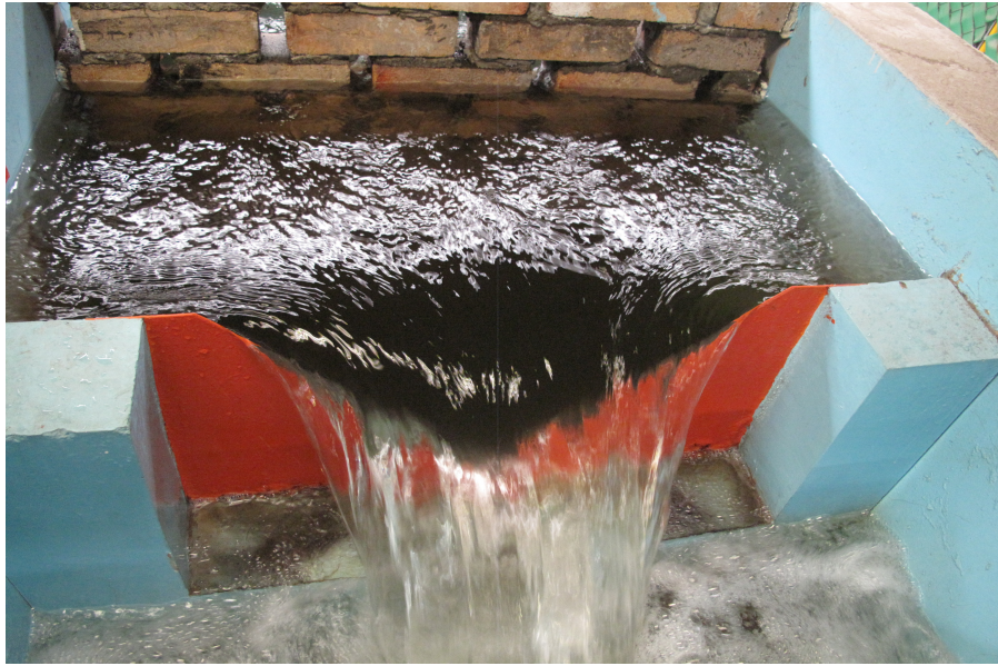
Figura 4.5. Vertedero del canal.
