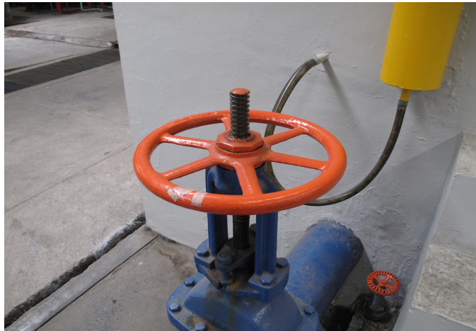
Figura 4.7. Válvula de control del gasto.
