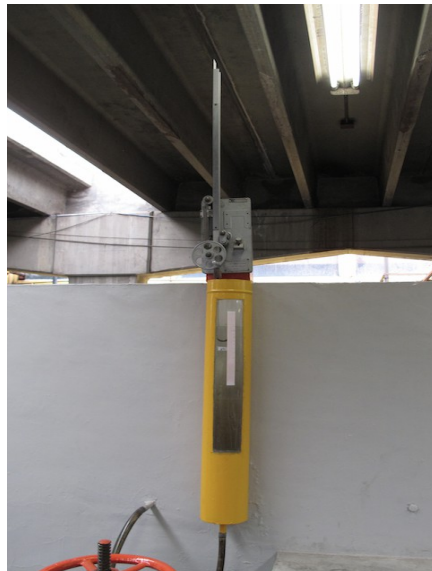
Figura 4.6. Limnómetro del vertedero.
