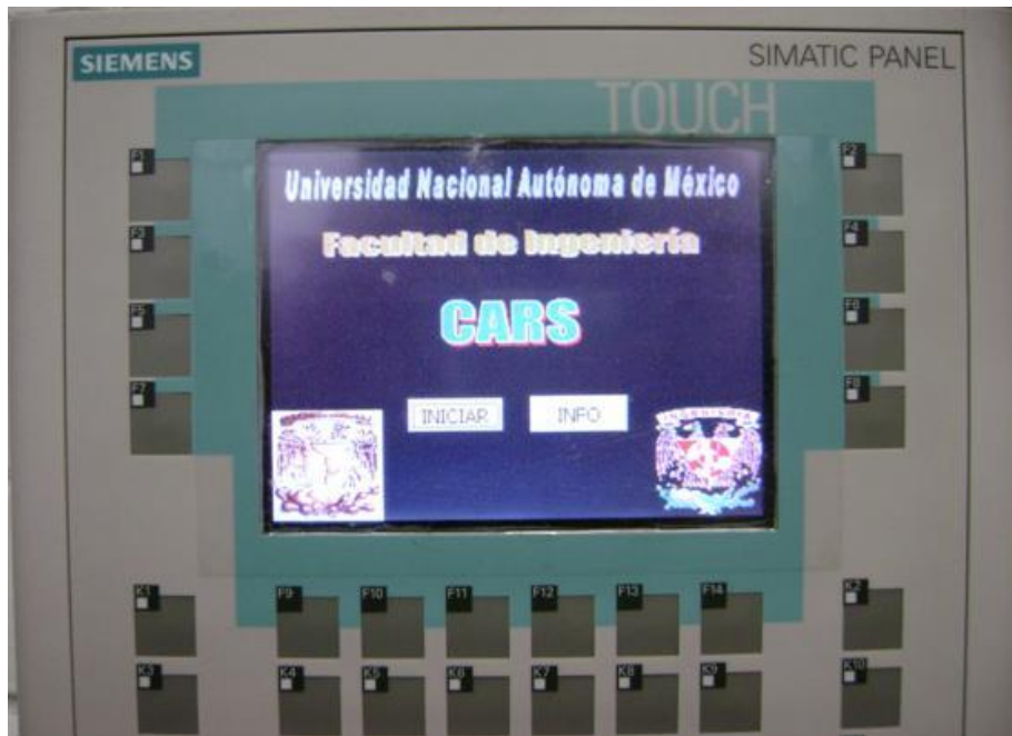
Figura 4.42. Panel de operado con HMI.
