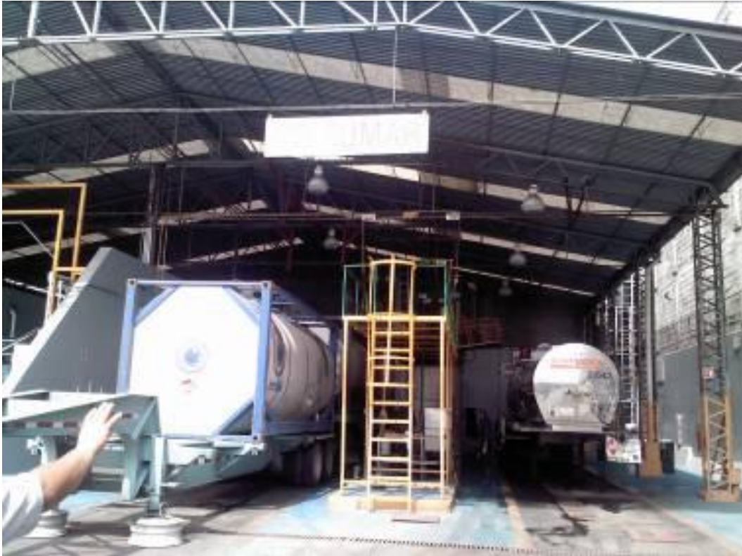
Figura 5.4. Lavaderos 1 y 2 de ATOSA para lavado exterior.
