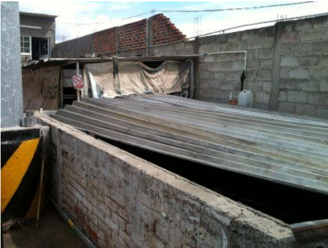
Figura 5.14. Fosa de agua para lavado exterior del centro Vaporizaciones .
