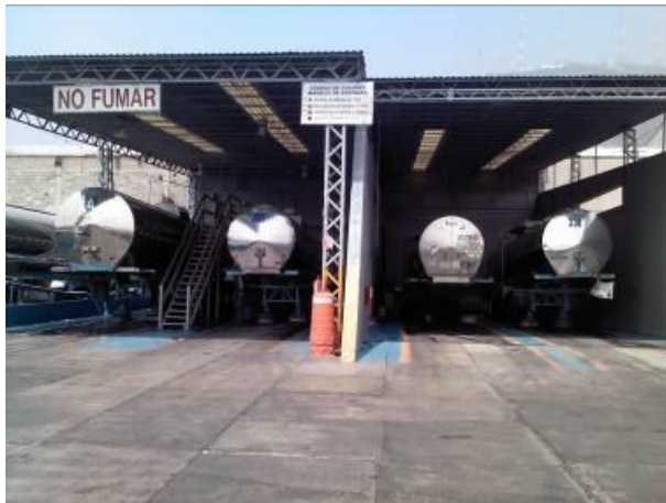
Figura 5.6. Lavaderos 3 y 4 para grado sanitario.
