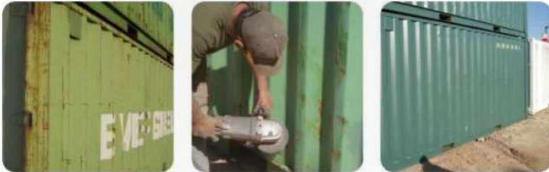
Fig 2.1. Mantenimiento de contenedores. Fuente: Sitio de internet http://issuu.com/ledg/docs/contenedoresmaritimos
