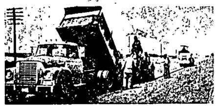
Fotografía 2. Trabajando en un carril ya escarificado y regado con agente rejuvenecedor, los pavimentadores del Distrito tienen espesores de 1.7 a
