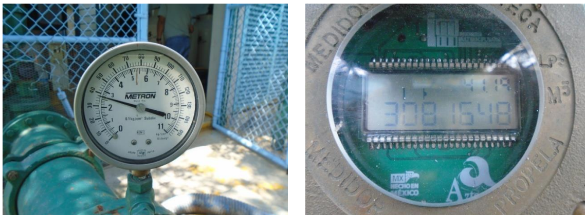
Figura 31 Manómetro y caudalímetro colocados en la obra de captación.
