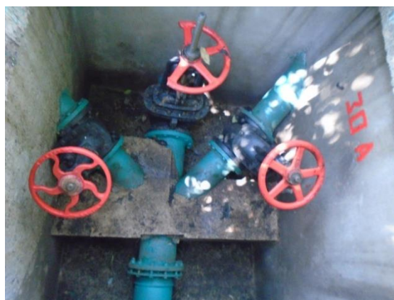
Figura 41 Crucero (30-A), arreglo de válvulas.
