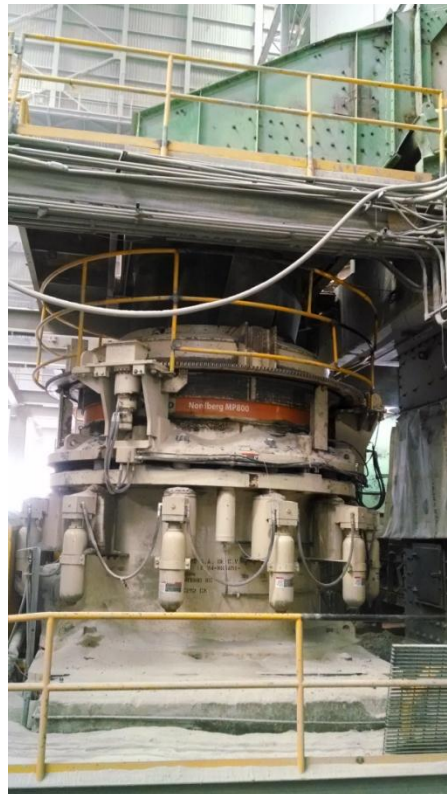
FIG. 2.22 Alimentación de criba a quebradora secundaria
