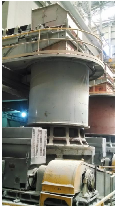
FIG. 2.65 Quebradora terciaria Allis Chalmers/Kobe Steel 3" x 84".
