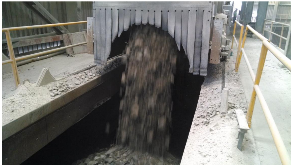
FIG. 2.15 Descarga de mineral del tripper 4a a la tolva de compensación de la quebradora secundaria
