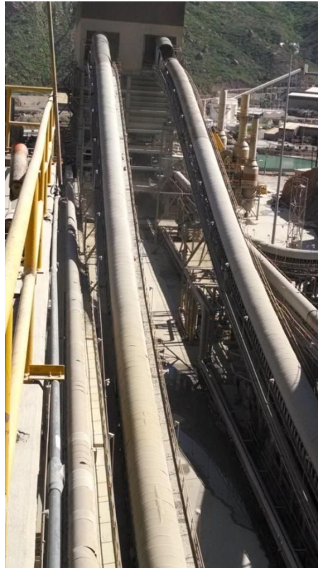
FIG. 2.46 Vista de bandas 5a y 5b
