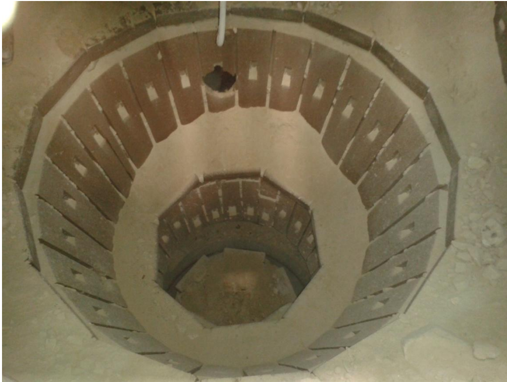
FIG. 2.23 Alimentación a quebradora secundaria
