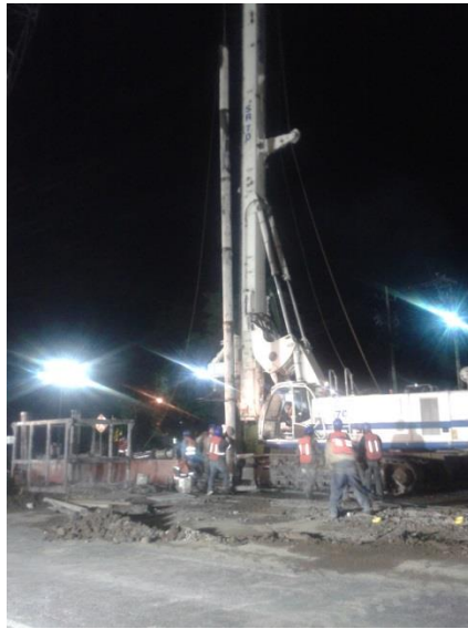
Figura 49. Soilmec SR-70 Equipo más utilizado– Pilas en Roca
