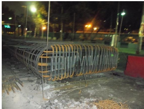
Figura 66 .Refuerzo estructural. Pilas Oblongas
