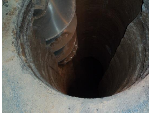
Figura 72. Perforación de galería de acceso. Pilas en Zona Minada
