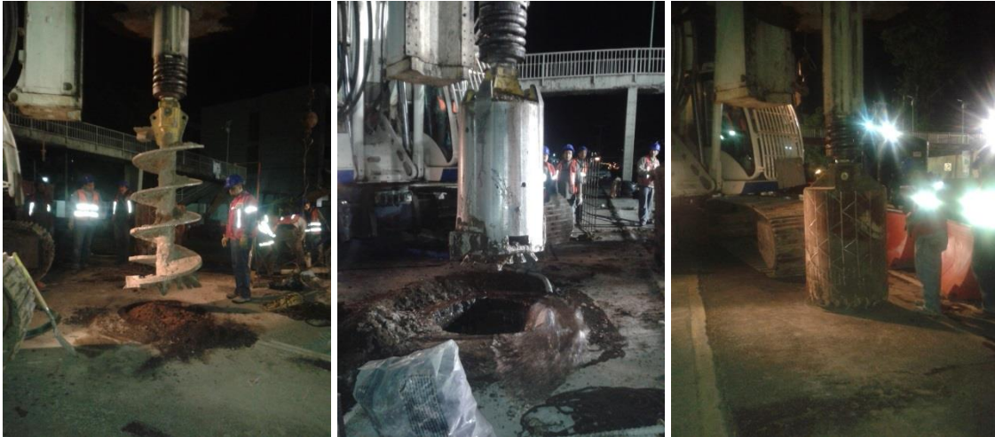
Figura 10. Perforación de pilas con distintos tipos de herramienta.
