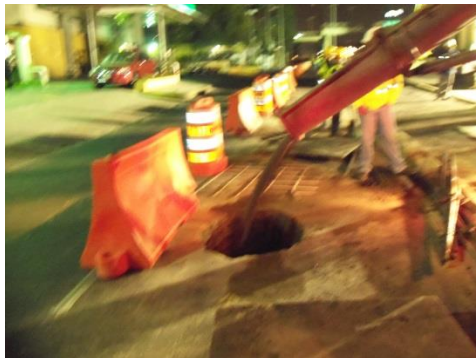
Figura 44. Vertido de relleno fluido. Pilas en Arenas
