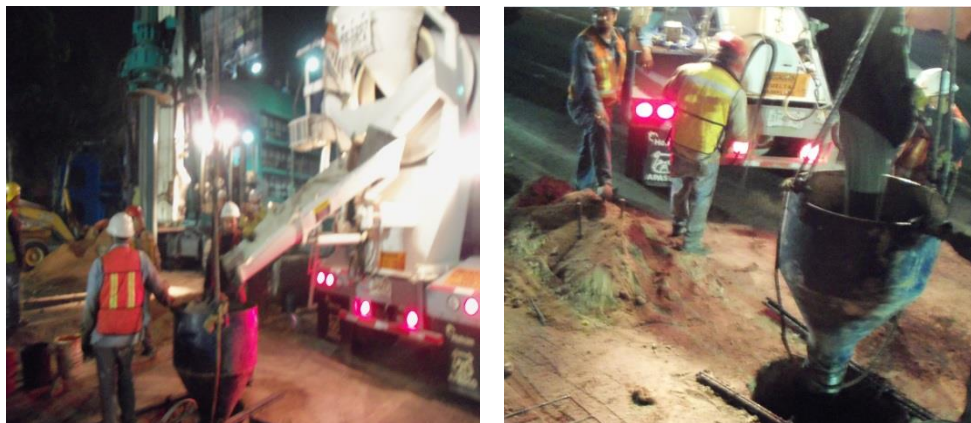
Figuras. 13 y 14. Colado de pilas AUN y AUS.
