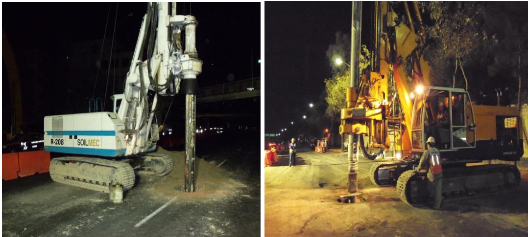
Figura 9. Perforación de pilas AUN y AUS.
