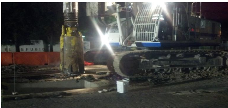
Figura 58. Primera etapa de perforación - Pilas Oblongas
