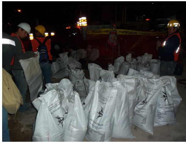
Figura 74. Colocación de confinamiento (Costalera). Pilas en Zona Minada
