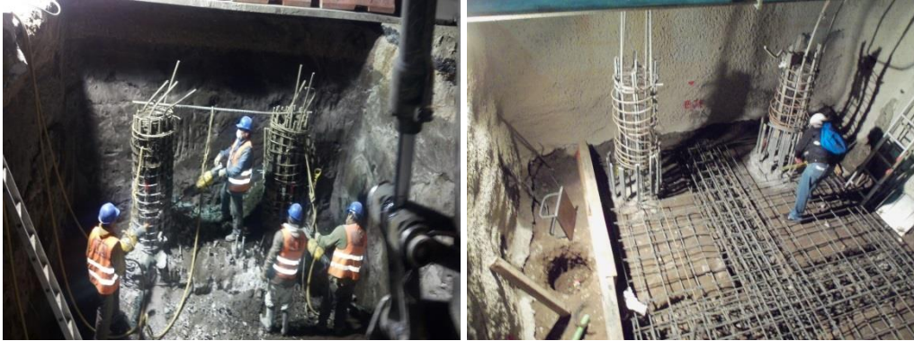
Figuras 22 y 23. Descabece de pilas y armado de plantilla
