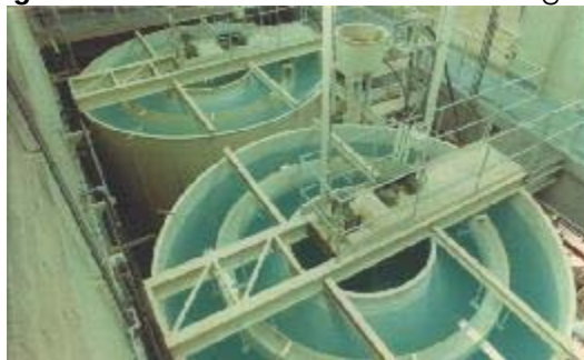
Figura 57. Edificio de tratamiento de agua.
