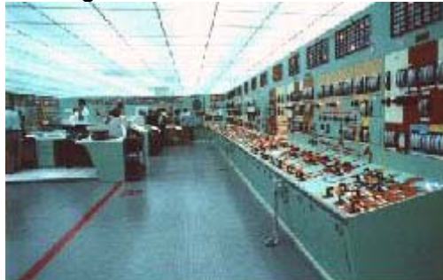
Figura 56. Edificio de control.
