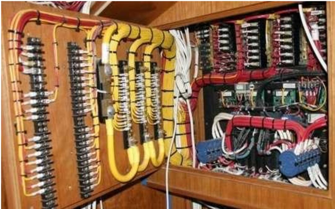
Figura 2.27 Panel de conexión del cableado eléctrico de un velero [25]
