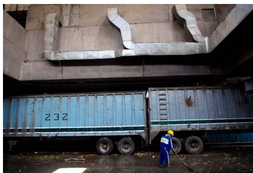
Figura 11: Estación de transferencia 13
