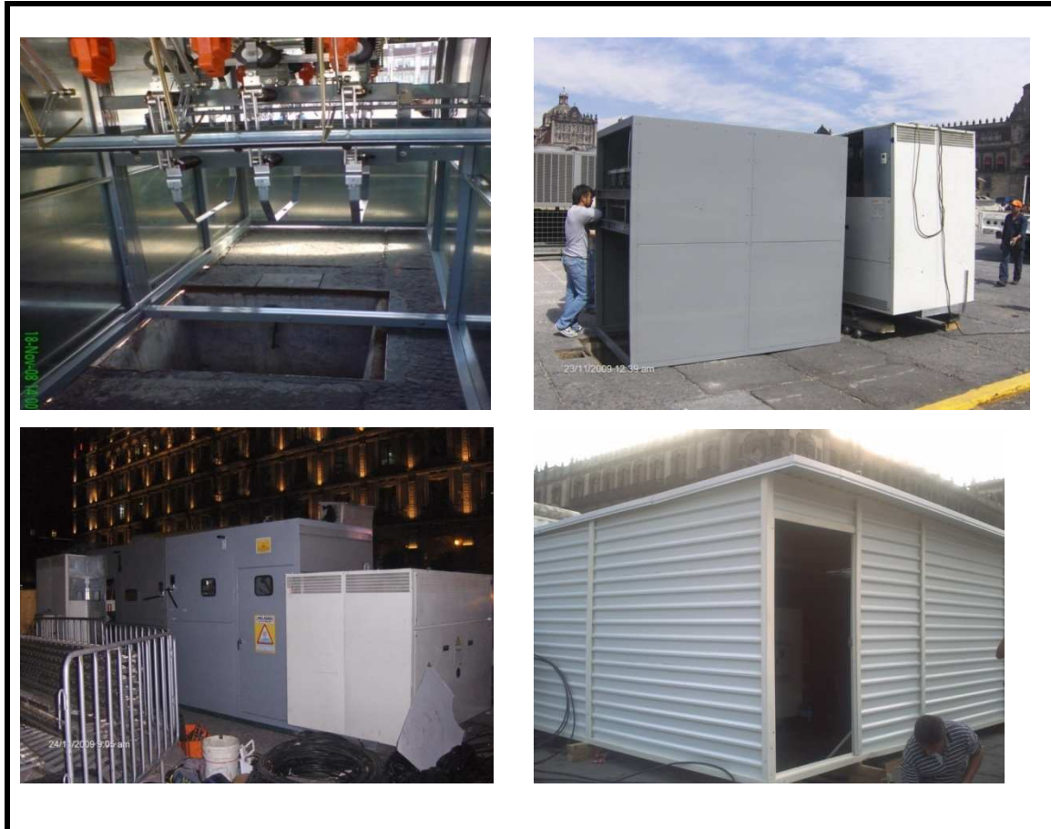
Figura 5.2 Proceso de montaje de la subestación eléctrica. (Información recabada 2009).
