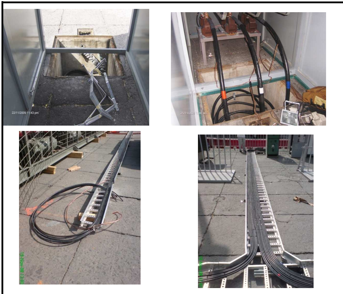
Figura 5.3 Acometida de Cia suministradora y distribución en charola. (Información recabada 2009).
