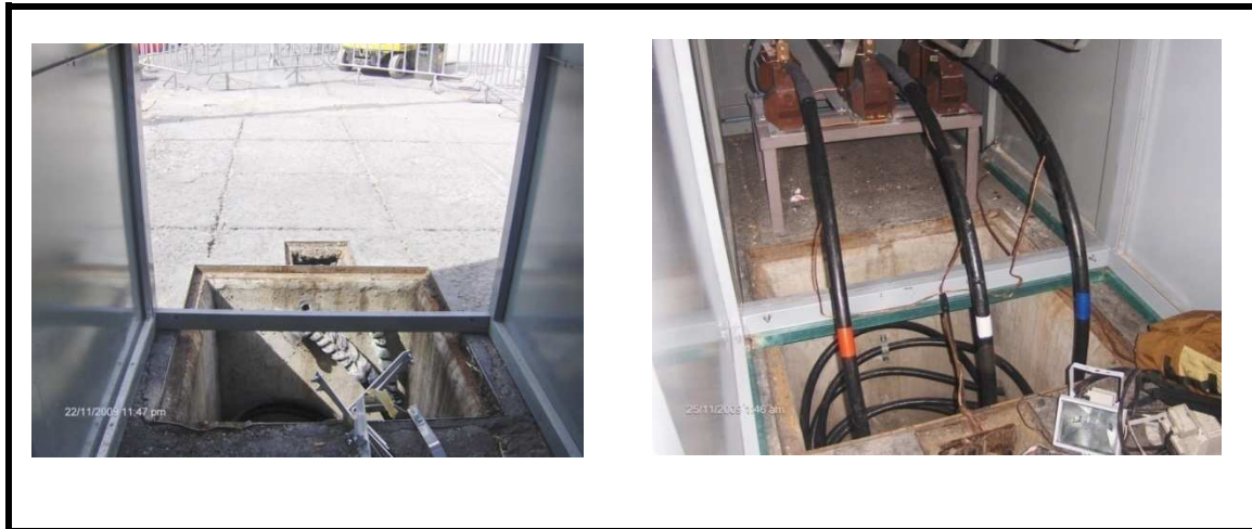
Figura 5.4 Acometida y punto de conexión de Cía. Suministradora. (Información recabada 2009).
