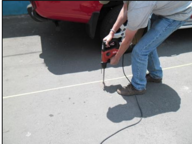
Figura 3.20 Perforación del asfalto
