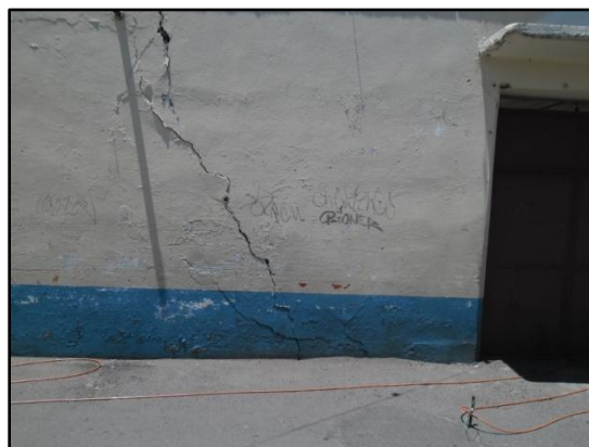
Figura 3.24 Electrodo frente a grieta
