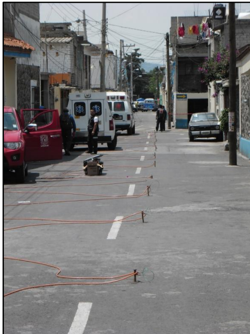
Figura 3.23 Tendido del Equipo
