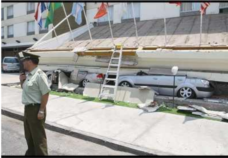
Figura 10.9 Caída de un voladizo debido a un sismo.
