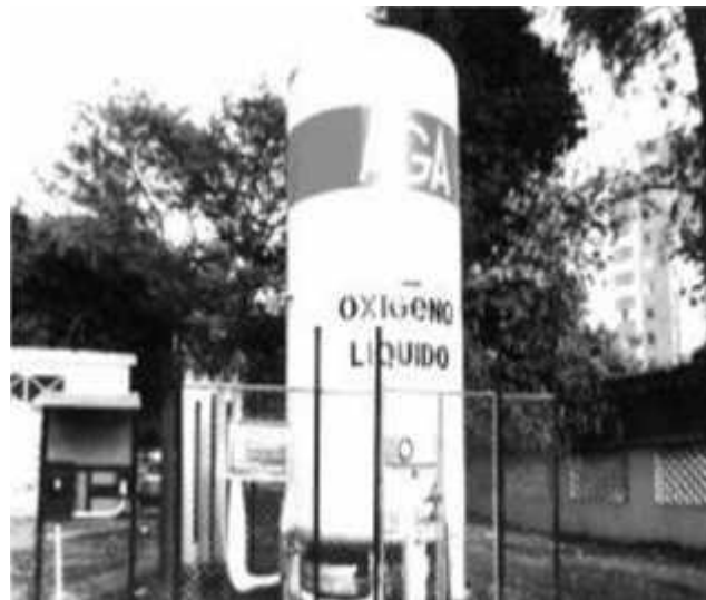
Figura 10.6 Tanque de oxígeno líquido.
