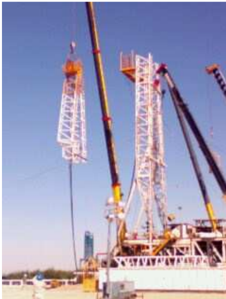
Figura 8. Separación de la sección dañada.
