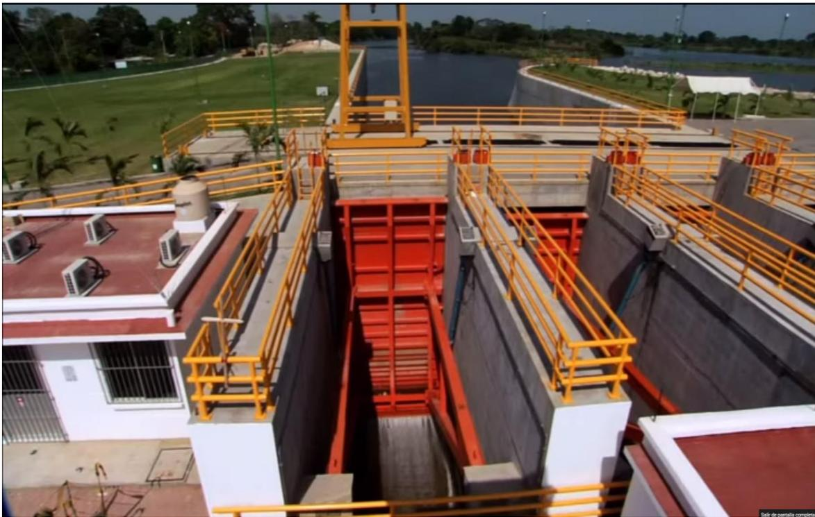
**Figura 5.1** Compuertas radiales de la estructura de control El Macayo, canal de la margen derecha
