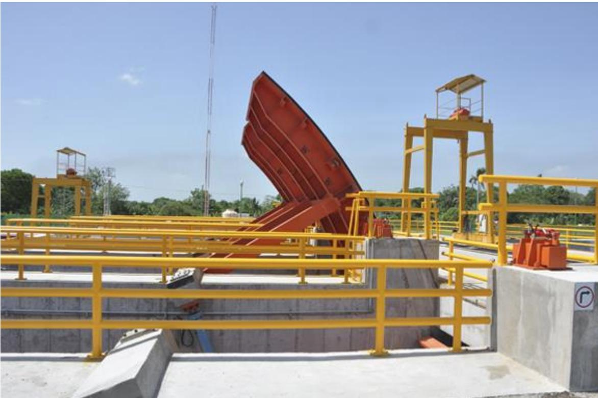
**Figura 1.1** Compuertas radiales de la estructura de control El Macayo
