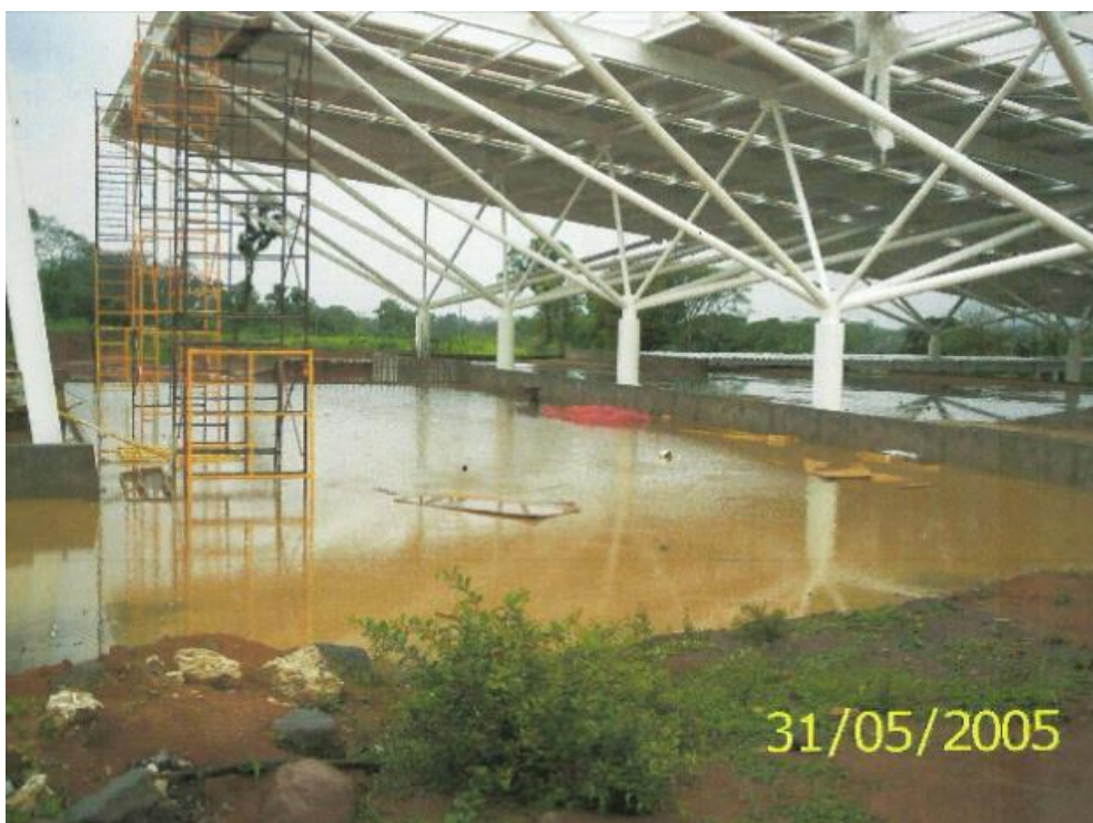
Figura 3.11 Etapa de construcción del edificio principal del campus USBI-Ixtac.
