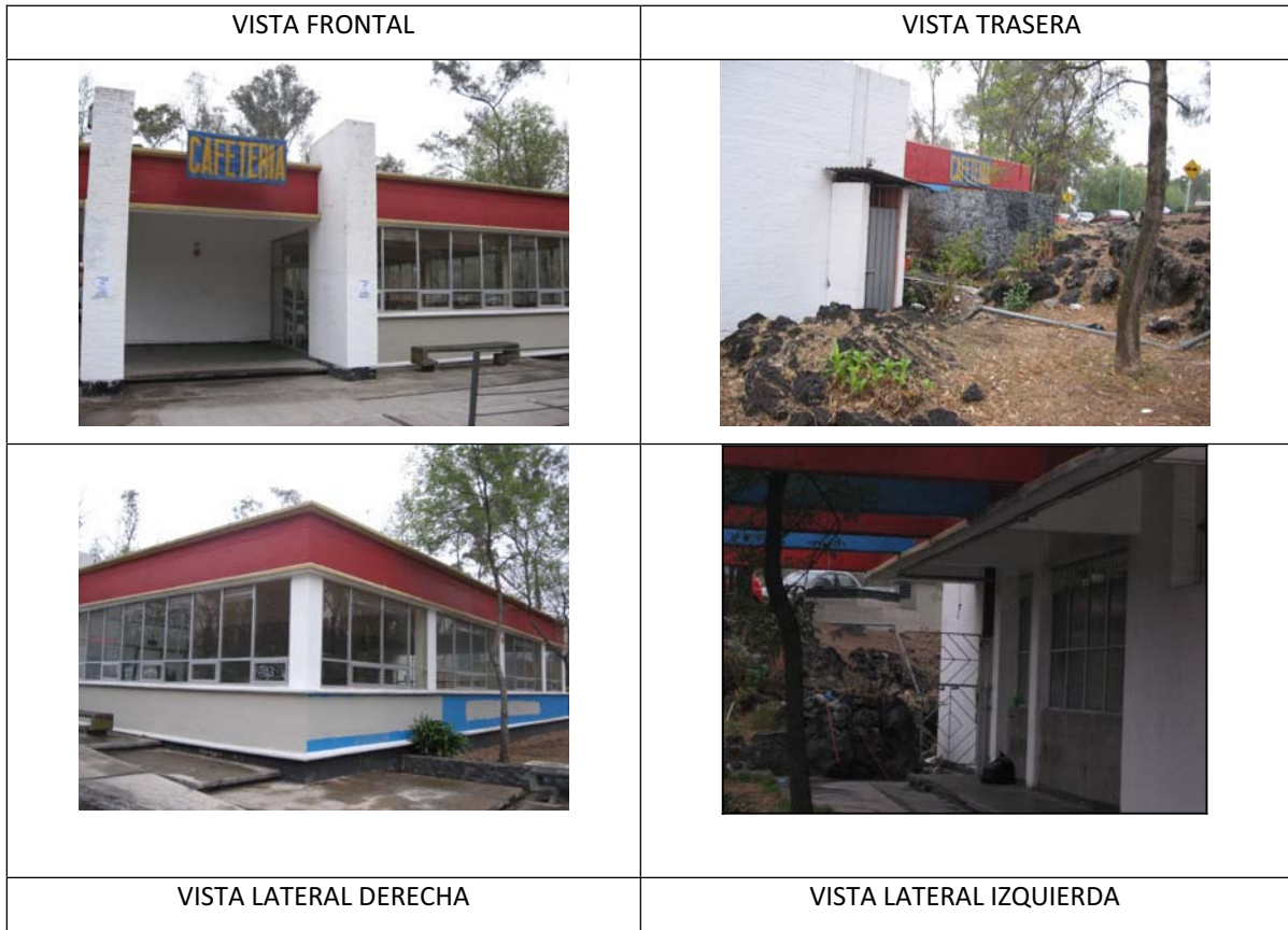
Figura 3. 6 Fotografía del área propuesta de instalación del digestor.
