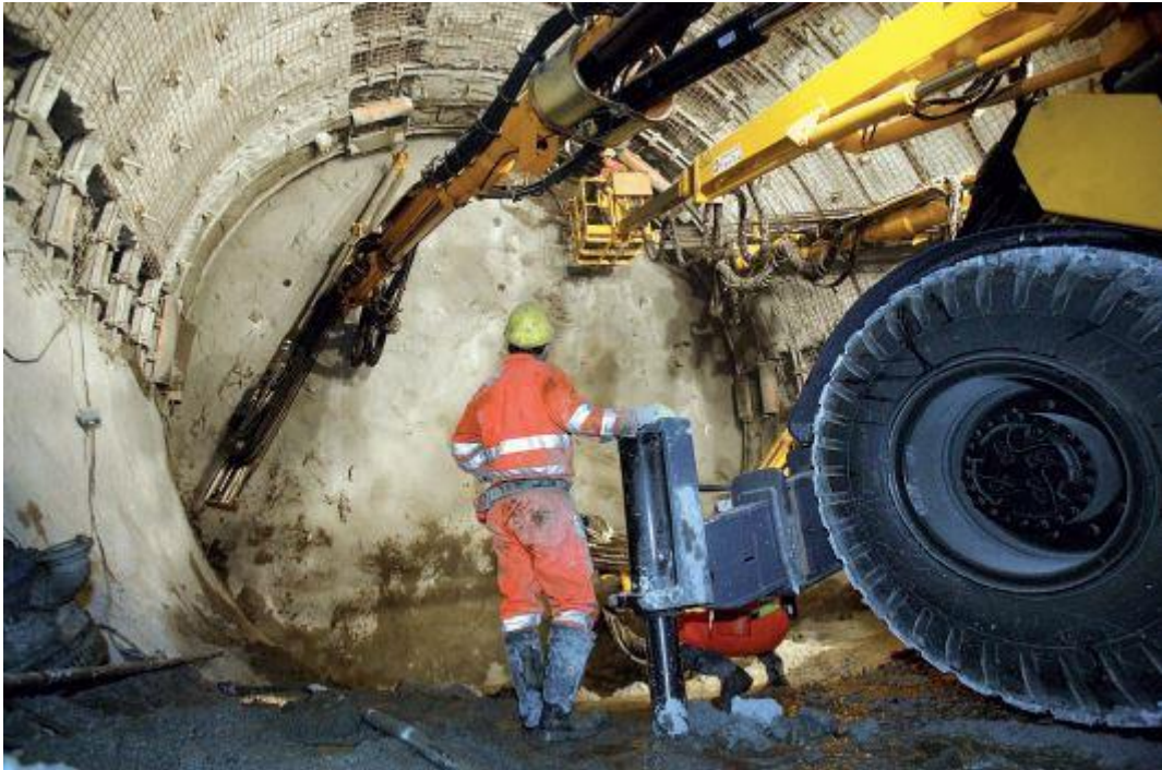
Figura 1.11 Pernos de anclaje
