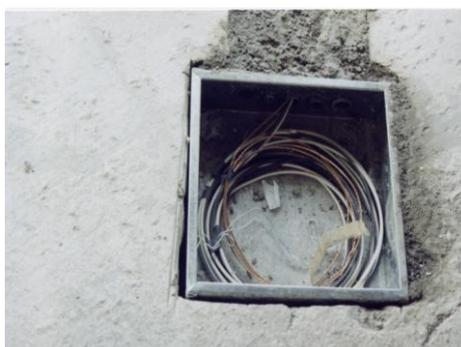
Figura 1.3 Instalación eléctrica totalmente oculta o ahogada.
