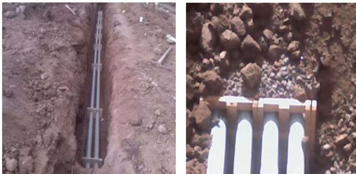
Figura 2.20 Arreglo de ductos en cepa con sujetadores y encofrado.
