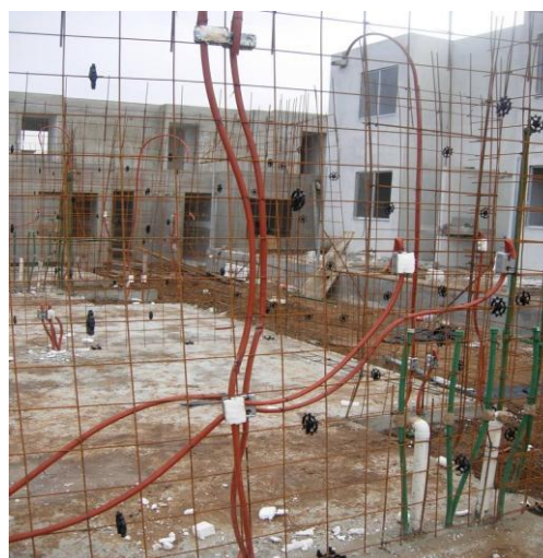
Figura 2.7 Cajas chalupa usada como caja de conexiones.
