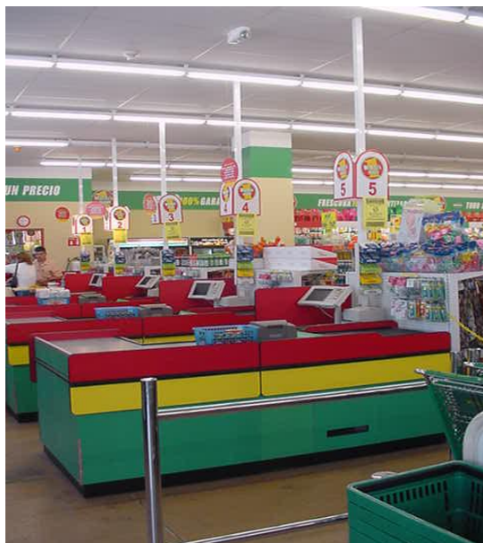
Figura 2.2 Luminario tipo sobreponer en área de cajas.
