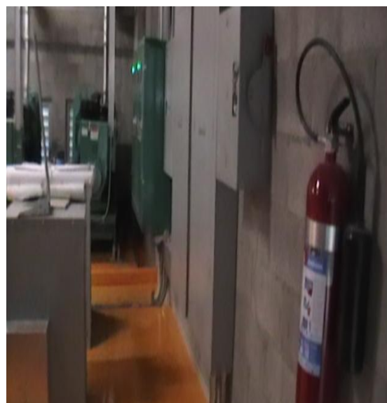
Figura 2.29 Montaje de extintor en subestación.
