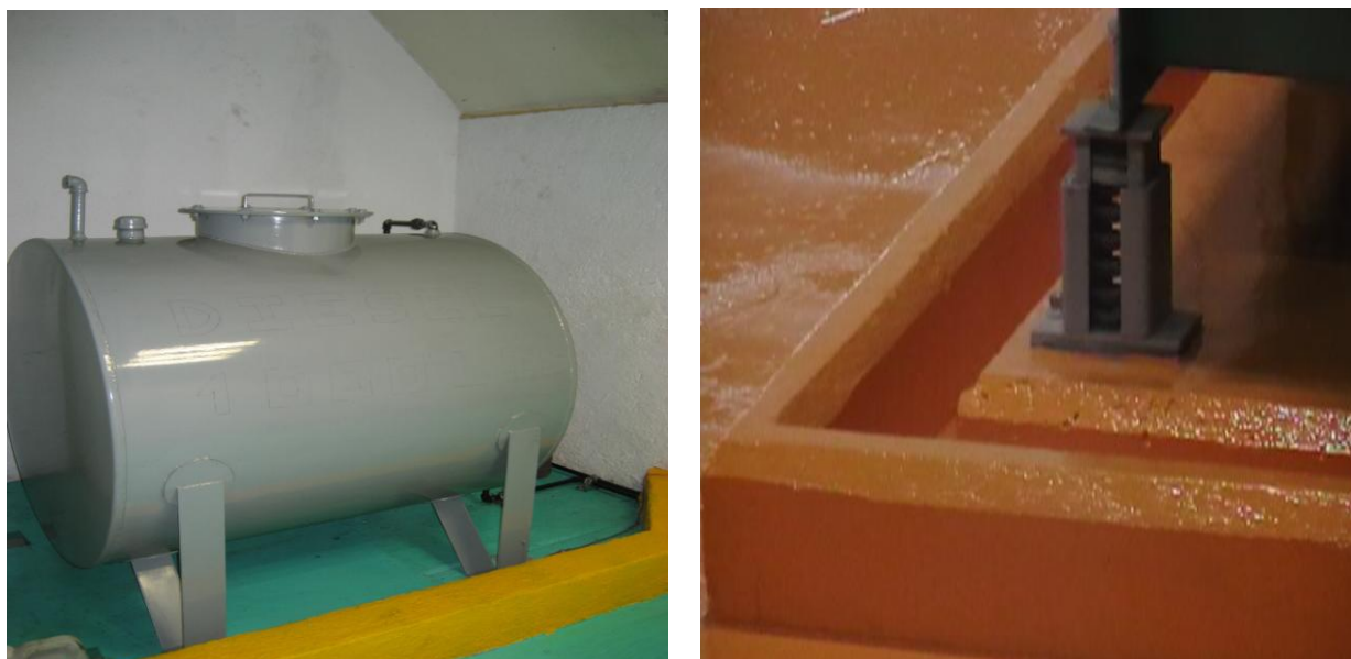
Figura 2.23 Sardinel para contenedor de diesel y sardinel para planta de emergencia con base tanque.
