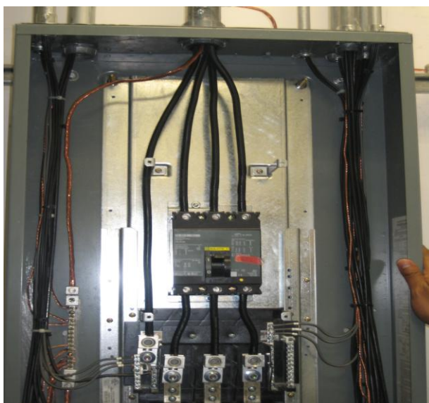
Figura 2.14 Alimentador principal en B.T.
