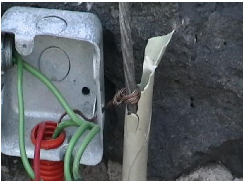
Figura 3.17 Conexión incorrecta del conductor de puesta a tierra.
