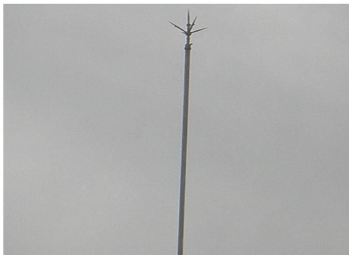
Figura 3.32 Punta pararrayos tripolar.
