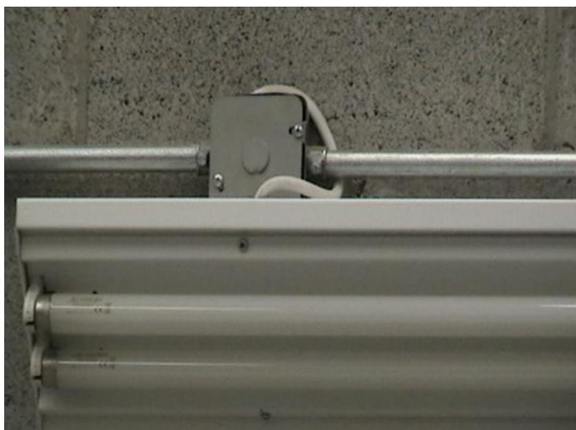
Figura 3.16 Luminario sin conductor de puesta a tierra
