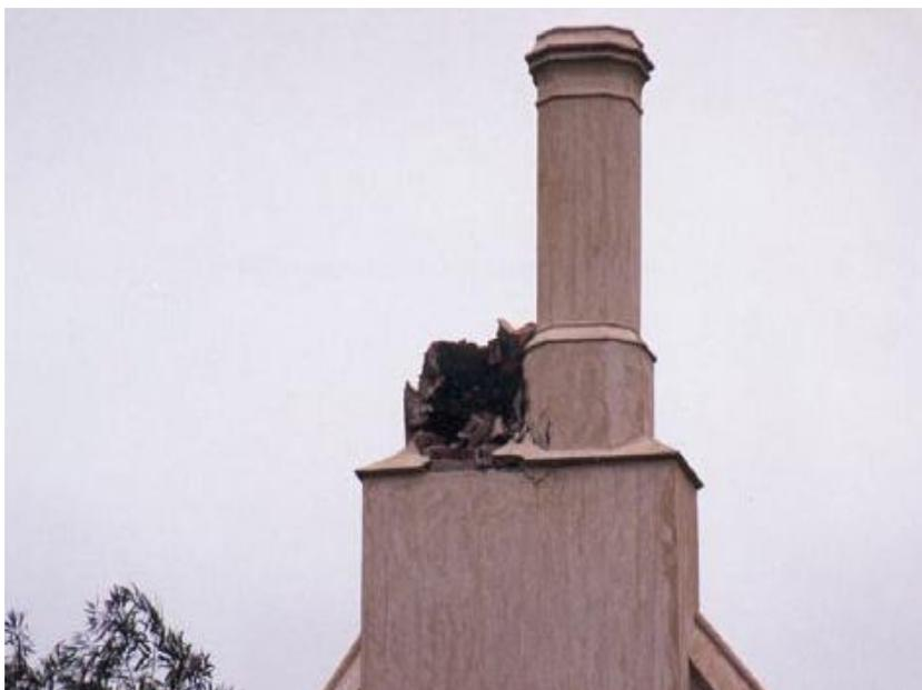
Figura 3.18 Estructura dañada por una descarga atmosférica.
