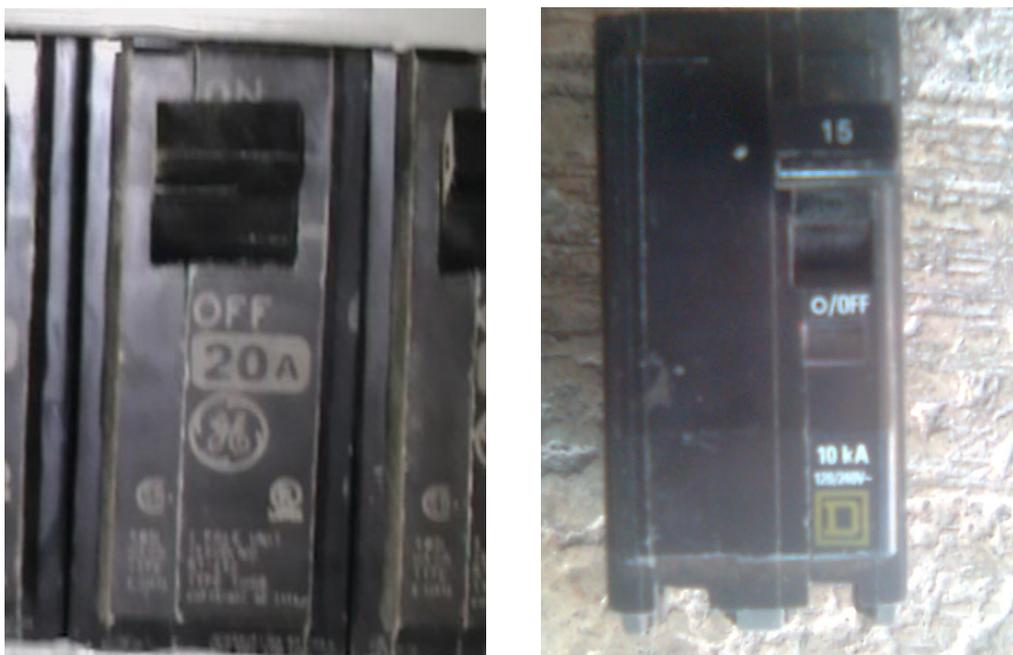
Figura 4.10 Capacidad nominal en amperes y capacidad interruptiva en kA.
