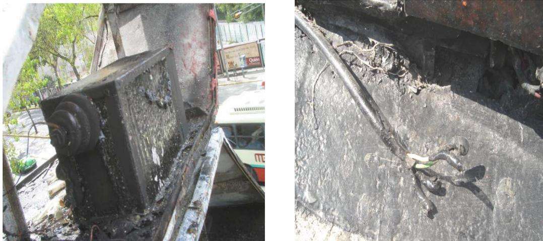
Figura 5.2 Transformador completamente quemado y cables de alimentación sin canalización y de uso interior utilizados como uso exterior.
